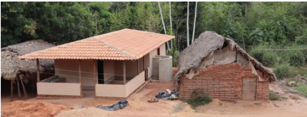
Figura 6. Contraste entre o pau a pique tradicional à direita e o pau a pique após a capacitação à esquerda na aldeia Tiracambu (crédito: TIBÁ Arquitetos)
