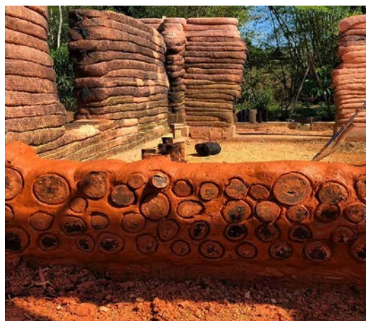
Figura 4. Paredes externas feitas de terra ensacada e parede interna na técnica de cordwood . Ao fundo, plantação de bambu disponível no local (crédito: L. Lopes, 2019)
