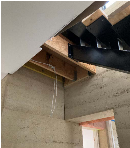
Figura 15 – Estrutura metálica da escada
