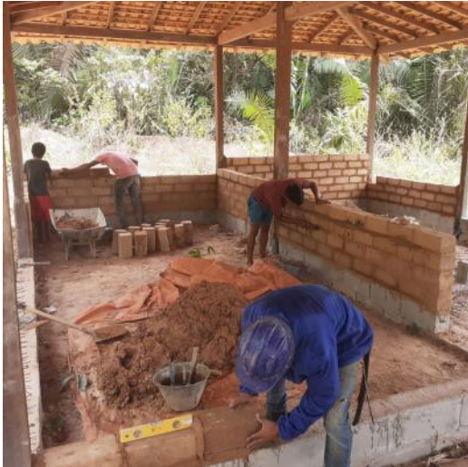
Figura 7. Bolsistas auxiliando na construção de casa de adobe (crédito: TIBÁ Arquitetos)
