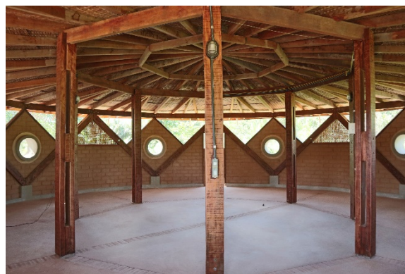
9 - Estrutura de madeira, Redário
