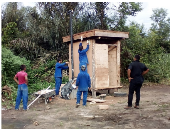
20 - Capacitação dos indígenas para execução de reboco no banheiro seco, aldeia Tiracambú
