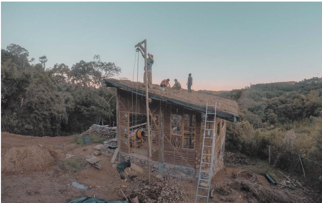
Figura 7: Execução do telhado verde extensivo
