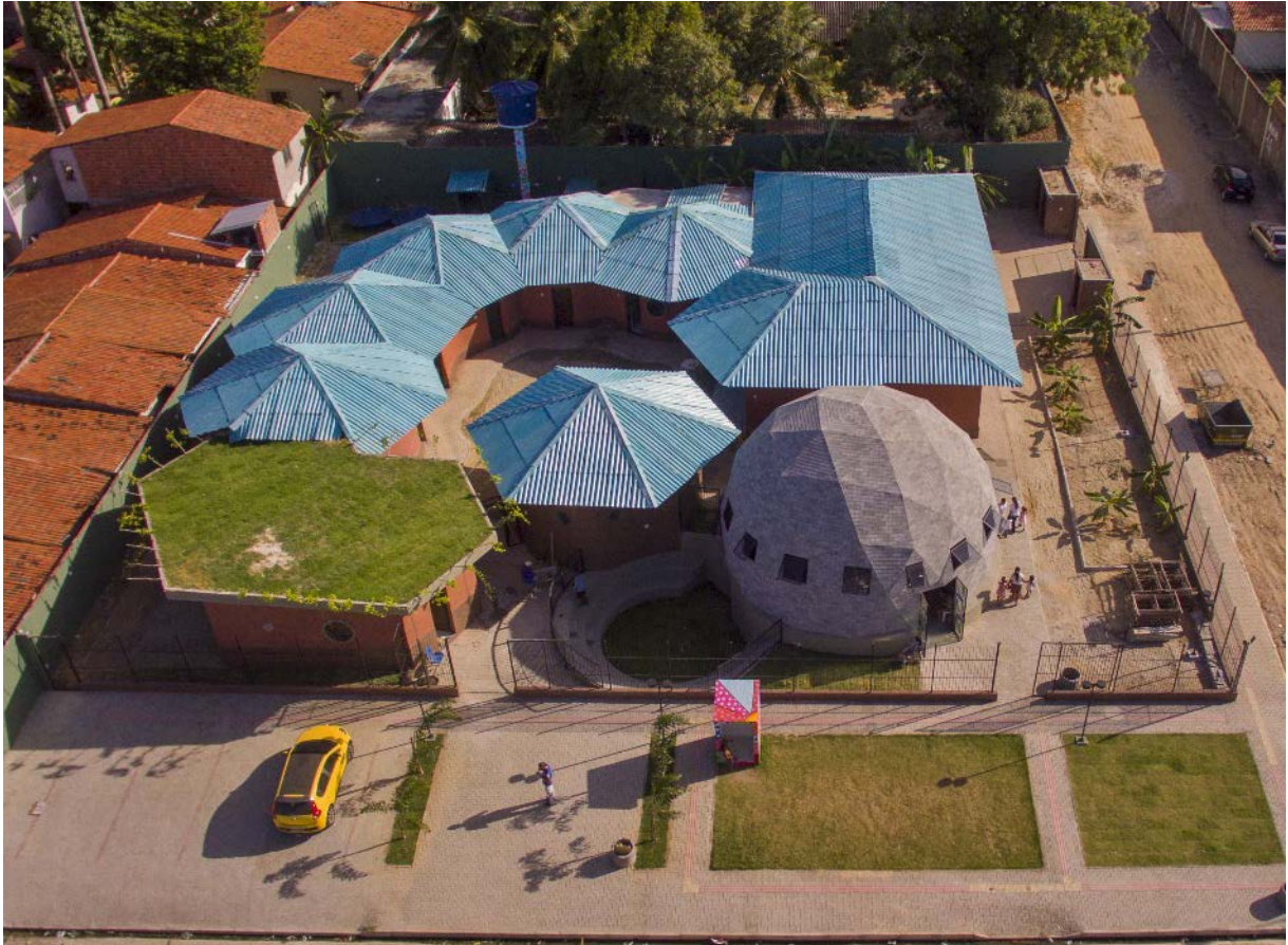
Figura 18 – Imagem superior da cobertura
