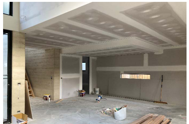
Figura 12 – Execução do gesso acartonado
