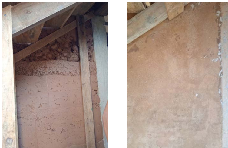
Figura 8: Antes e depois da aplicação da argamassa experimental de revestimento
