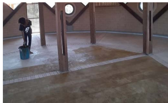
27 - Aplicação de cera de abelha no piso de solo-cimento, Redário aldeia Awá
