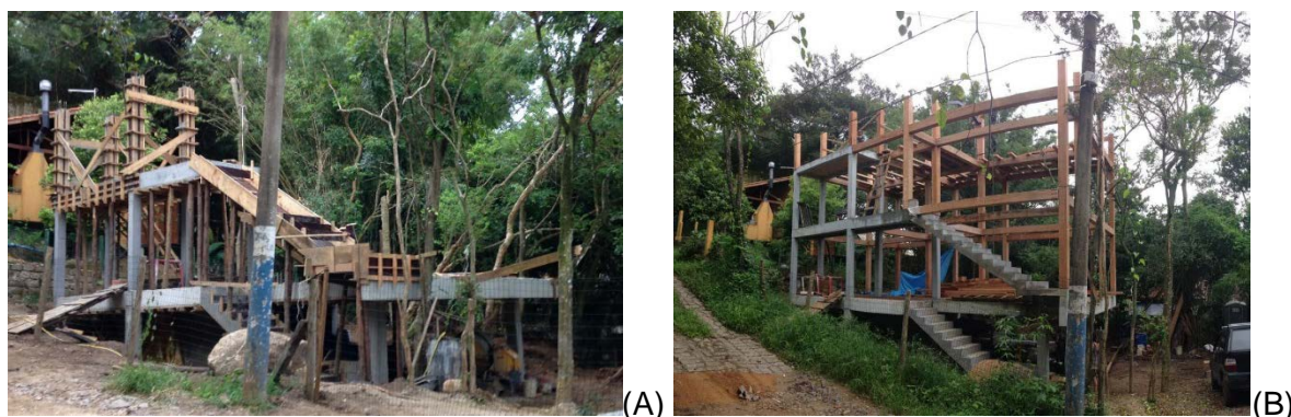
Figura 7 – (A) Concretagem dos pilares de suporte da laje da caixa d'água e a caixaria da escada que leva ao primeiro pavimento (B) Estrutura de concreto finalizada e pronta para montagem da cobertura
