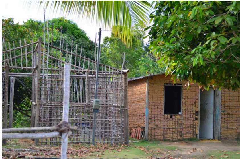
Figura 3 - Casa de pau a pique, típica dos Tupinambá de Olivença
