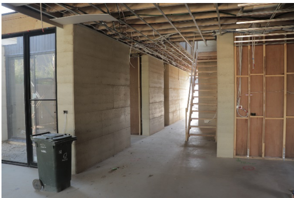
Figura 11 – Execução do forro interno
