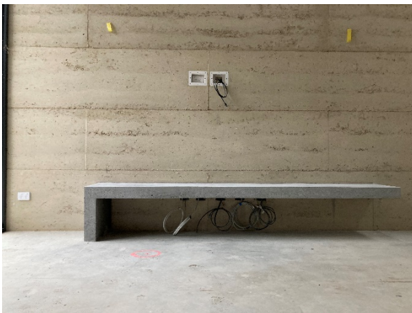
Figura 17 – Bancada de concreto na taipa
