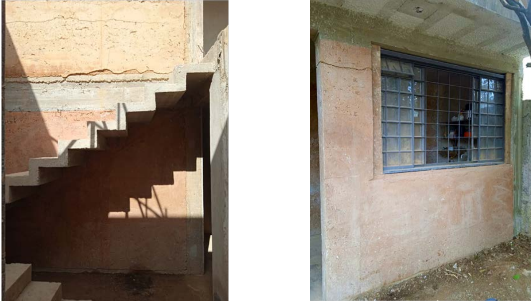
Figura 10: Parede 1 executada à esquerda e Parede 2 executada à direita
