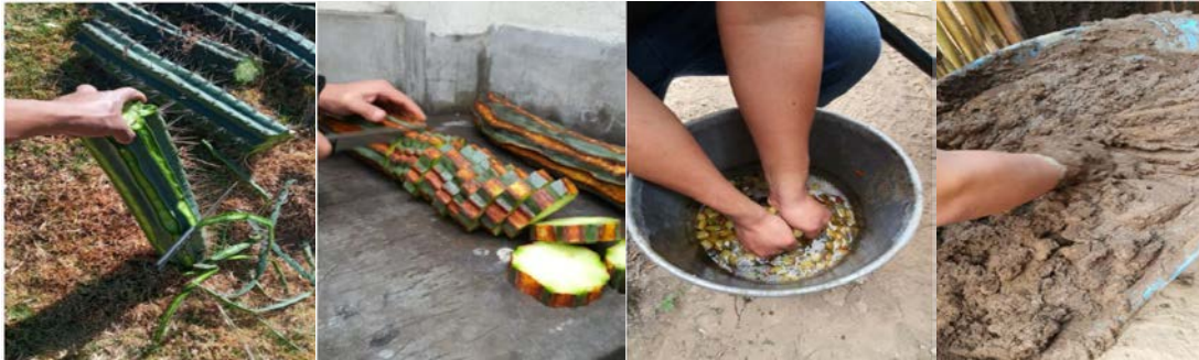
Figura 2. Proceso de preparación de la mezcla de tierra, agua y mucilago de sanqui (CECOS-BRIGURP, 2021)
