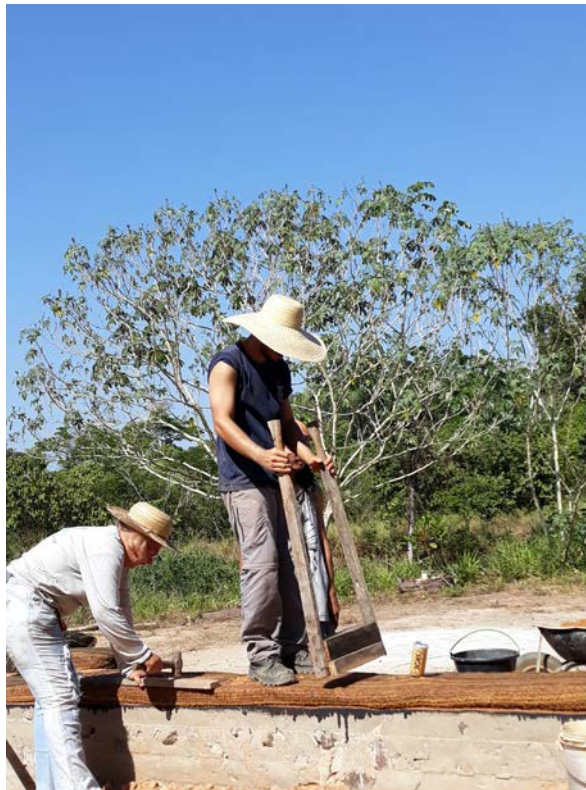
Figura 6. Compactação da primeira fiada de terra ensacada durante o 1º Curso de Bioconstrução em Rondônia (crédito: R. Morão, 2018)
