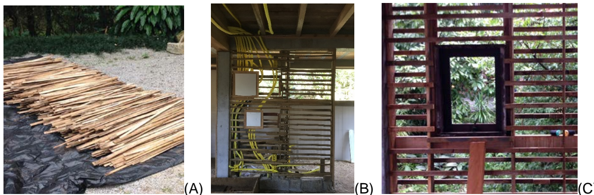
Figura 12 – (A) Peças de bambu tratado, prontos para colocação na trama das paredes (B) Quadros de instalação elétrica e tubulação passando pela trama da estrutura (C) Trama do pau a pique com abertura
