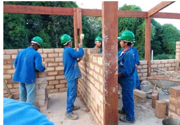
Figura 4. Construção da alvenaria da habitação na aldeia Awá (crédito: TIBÁ Arquitetos)
