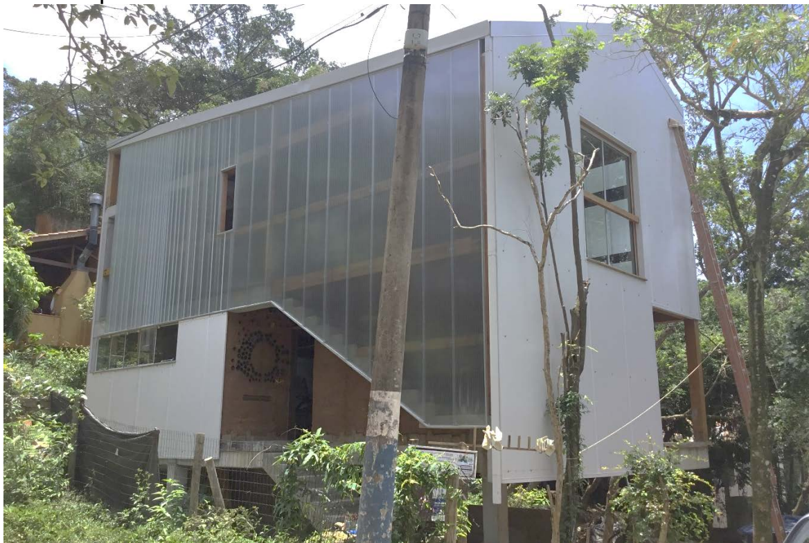
Figura 1 – Fachada sul voltada para a rua, ainda em obras. Paredes de terra na entrada com Mandala feita de tijolos de garrafas de vidro
