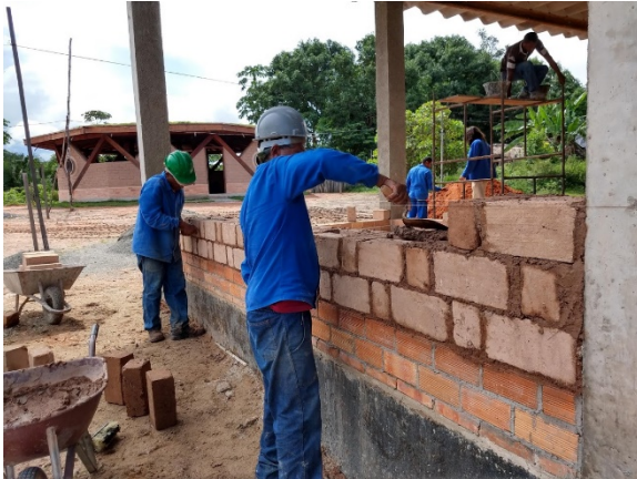
22 - Execução da alvenaria de adobes da Casa de Conversa, aldeia Awá
