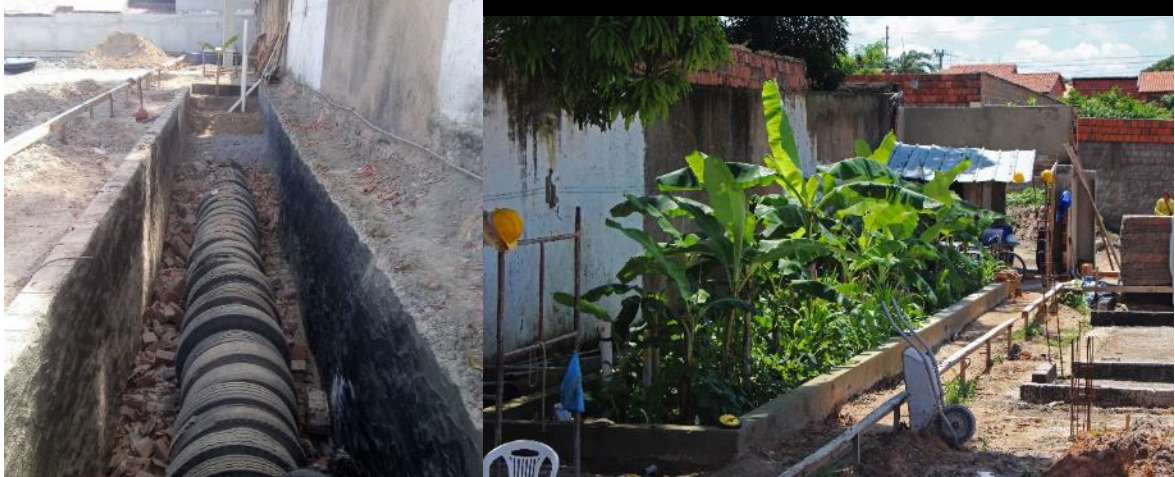
Figura 3 – Etapas da construção da bacia de evapotranspiração
