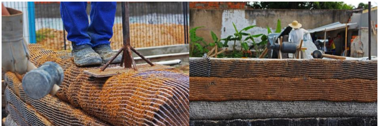
Figura 8 – Alvenaria externa de terra ensacada
