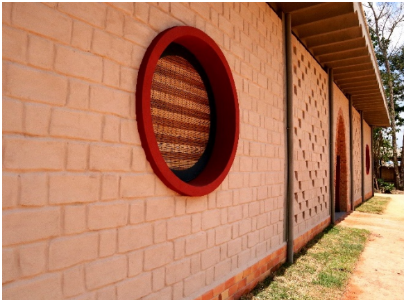
24 - Acabamento dos adobes na face externa do Centro Cultural, aldeia Maçaranduba
