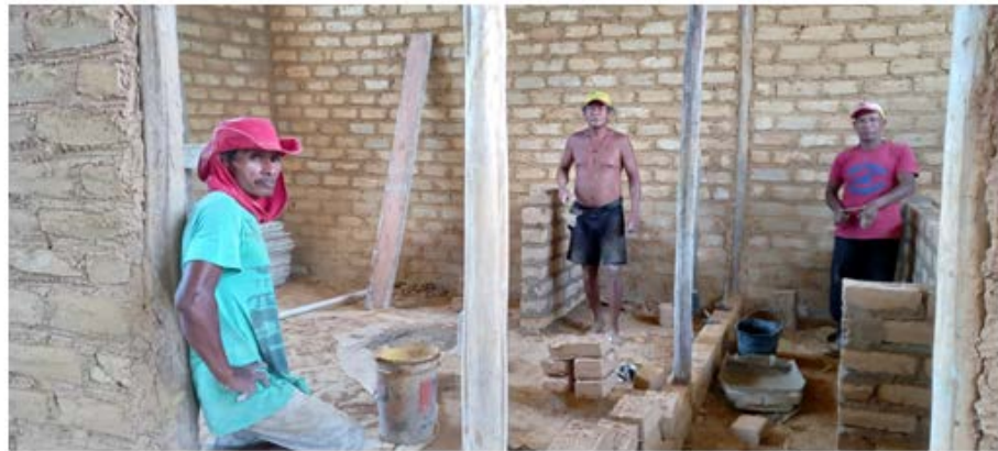
Figura 8 – Construção da casa do cacique em regime de mutirão, 2021
