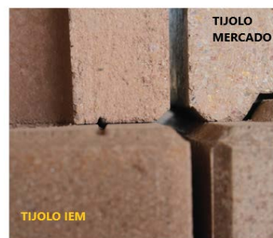
b) Uso de guia horizontal para alinhamento dos tijolos nas fiadas
