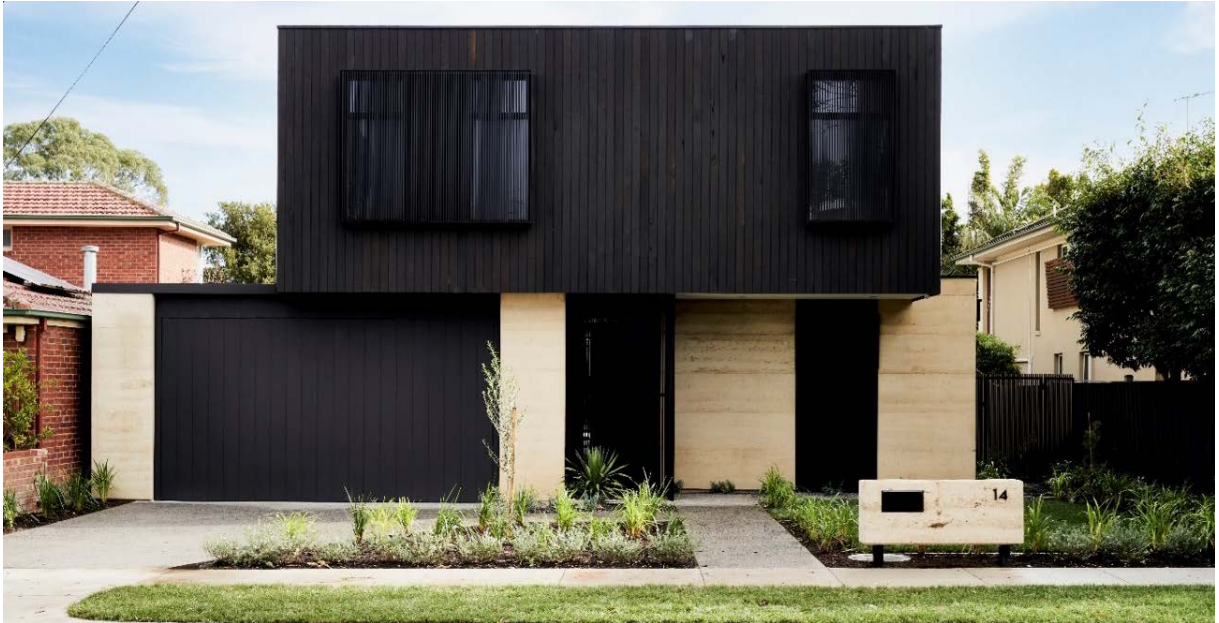
Figura 26 – Vista frontal da residência ao Leste
