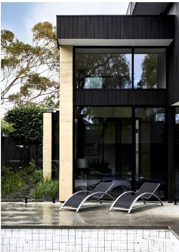
Figura 22 – Detalhes de acabamentos externos com a taipa
