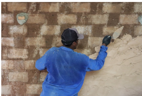
8 - Aplicação de reboco de cal, Centro Cultural Maçaranduba
