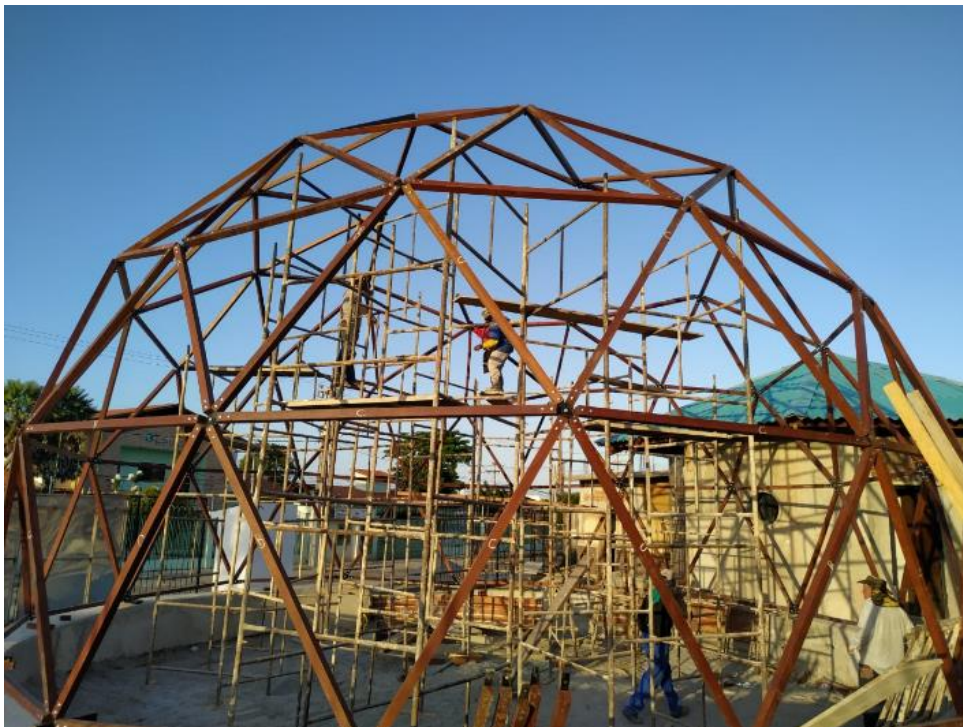
Figura 4 – Montagem da estrutura do domo geodésico
