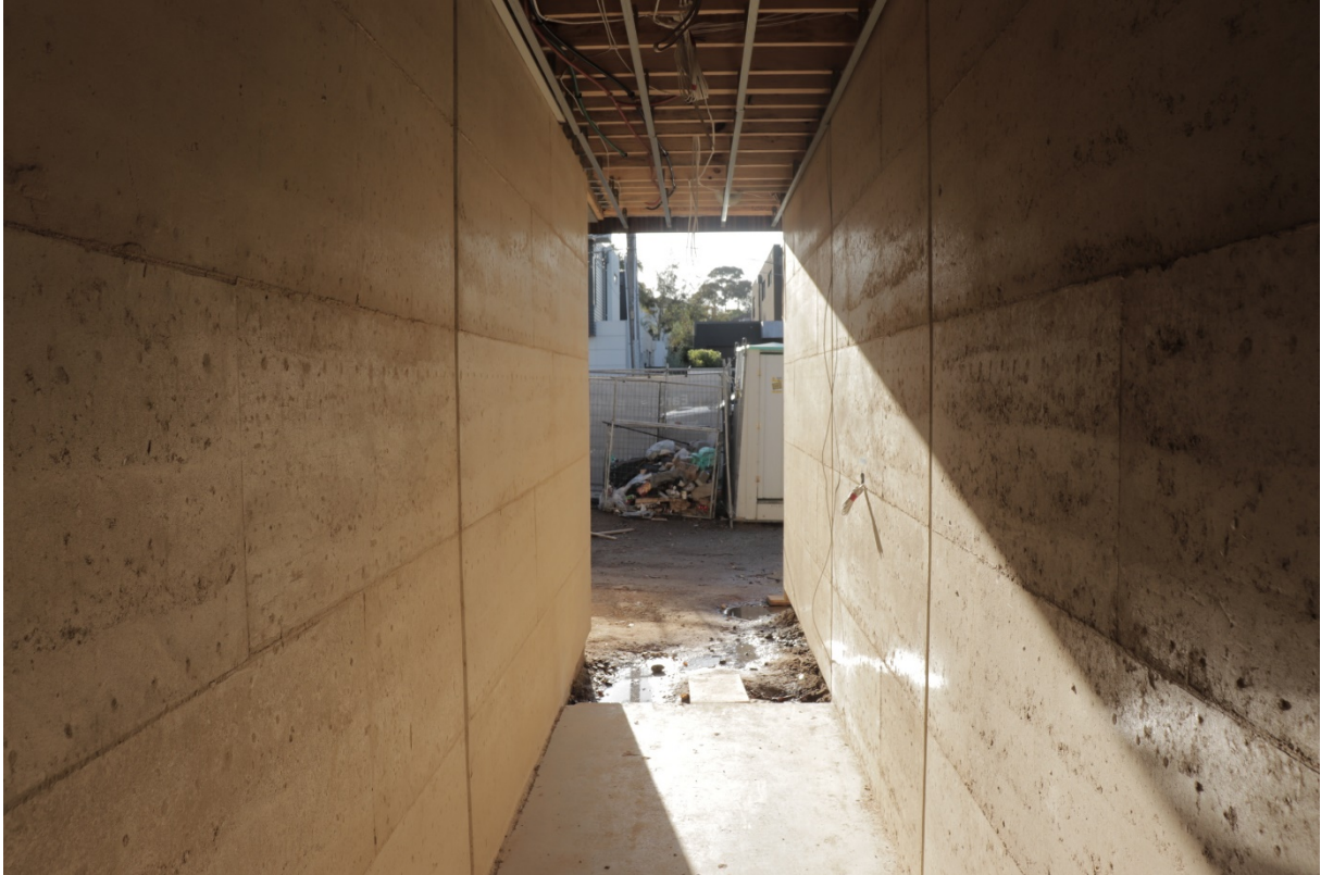
Figura 8 – Entrada da residência em obra
