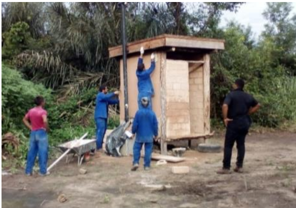
Figura 3. Aplicação de reboco a base de cal na aldeia Tiracambu (crédito: TIBÁ Arquitetos)
