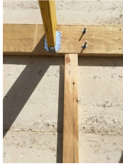
Figura 16 – Viga de madeira aparafusada na taipa
