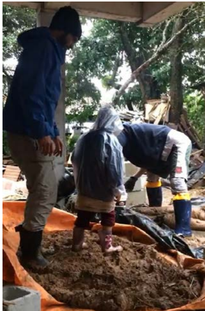
Figura 14 – Equipe de obra pisoteando o barro para o pau a pique com a simpática participação de uma das muitas crianças que passaram pelo canteiro e contribuíram para a execução de parte da Casa Bambuzal
