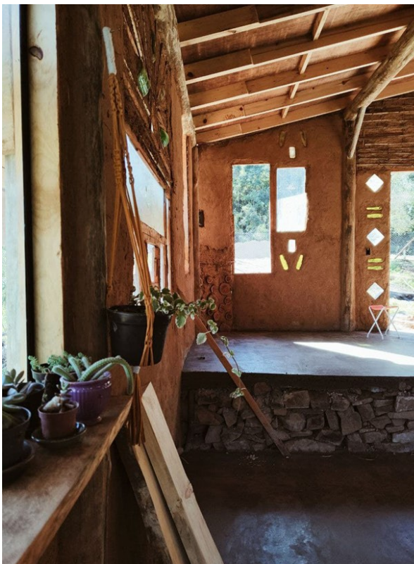
Figura 10: Detalhes do interior da casa
