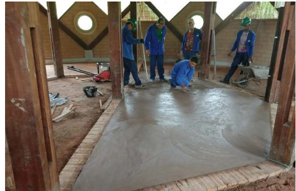
13 - Capacitação da equipe de obra para execução de piso de solo-cimento, Redário aldeia Nova Samyã
