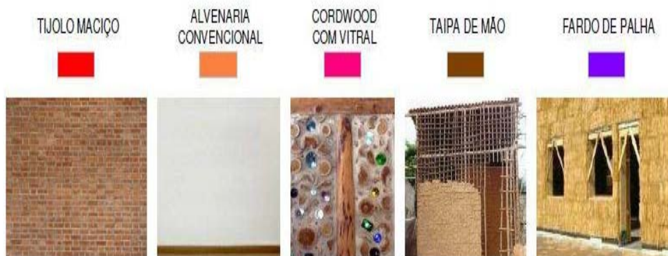
Figura 12 - Tipos de paredes aplicados na edificação
