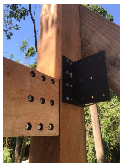
Figura 9 – (A) Recortes para conexão das vigas com o auxílio de um tira taboas (crédito: Bruno Condi Cavagnari); (B) Detalhe dos conectores 2 instalados para conexão das vigas
