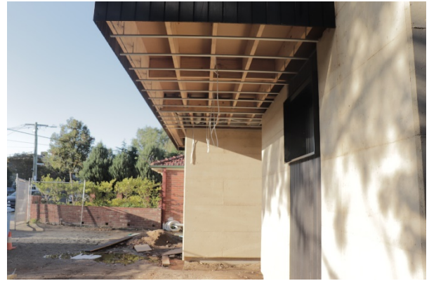
Figura 10 – Execução do forro externo
