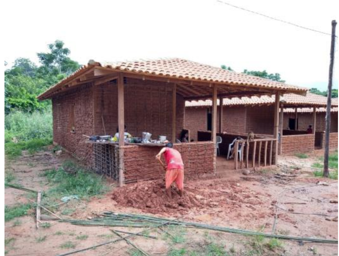
Figura 8. Indígena preparando a massa para execução do barreamento. (crédito: TIBÁ Arquitetos)
