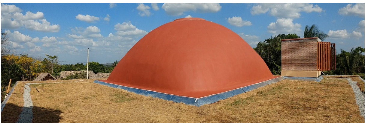
7 - Cobertura do Centro Cultural aldeia Maçaranduba
