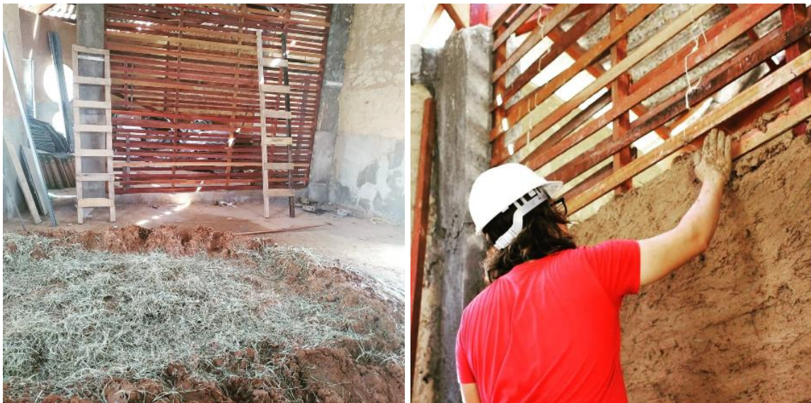
Figura 6 – Estrutura do pau a pique e barreamento
