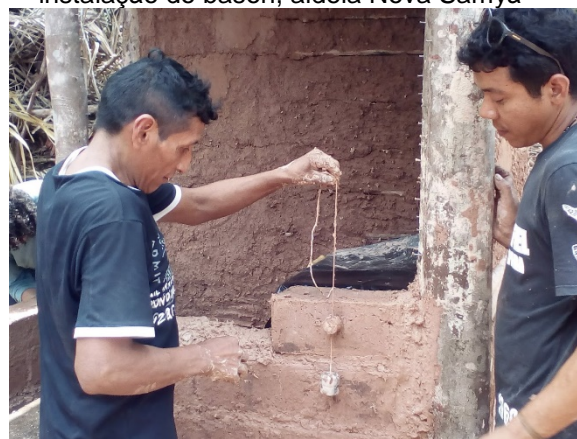
21 - Capacitação dos indígenas para utilização do prumo de face, aldeia Awá
