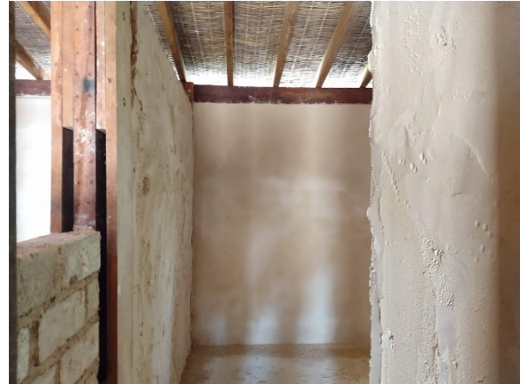
23 - Reboco de cal nas paredes internas da Habitação Modelo, aldeia Maçaranduba
