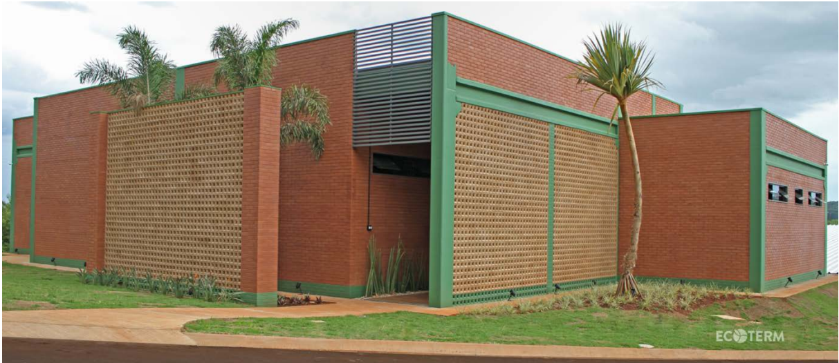
Figura 4. Imagem de uma construção feita com tijolos de solo-cimento contendo 30% de resíduos de construção e módulos vazados produzidos com 85% de terra de descarte de mineração
