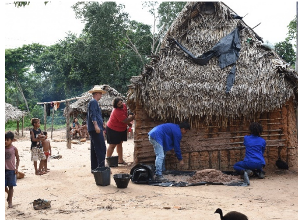
25 - Aplicação de reboco em moradia existente, aldeia Awá
