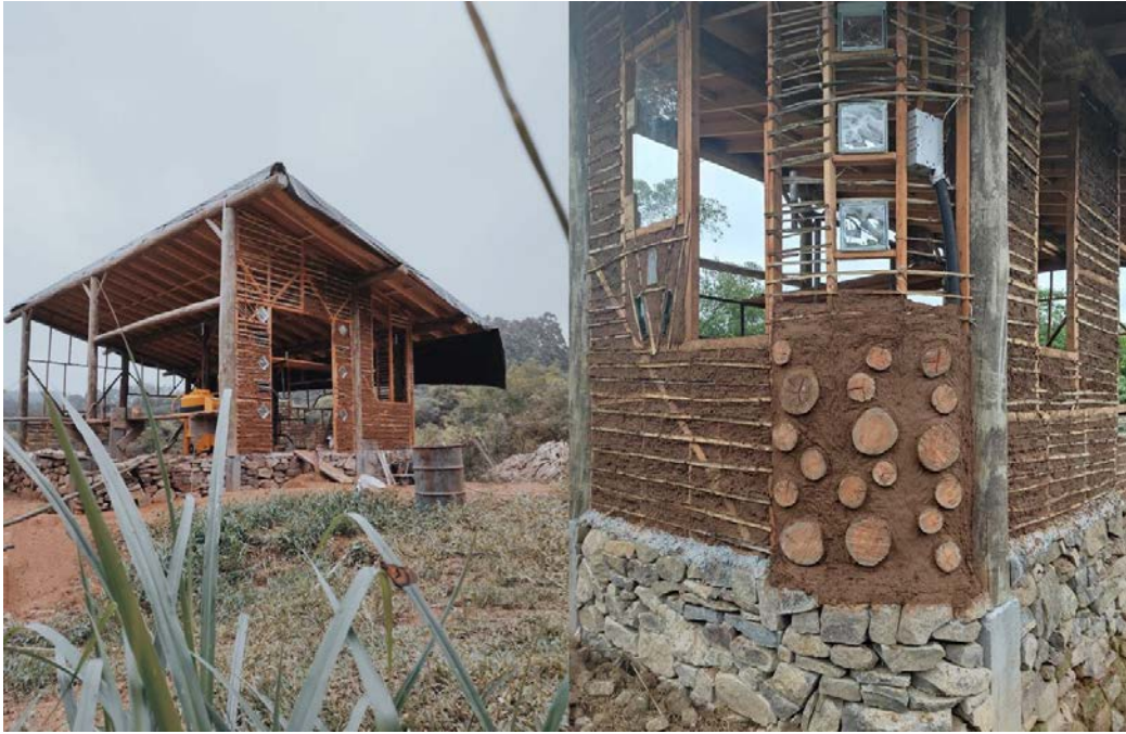
Figura 8: Execução das paredes de terra
