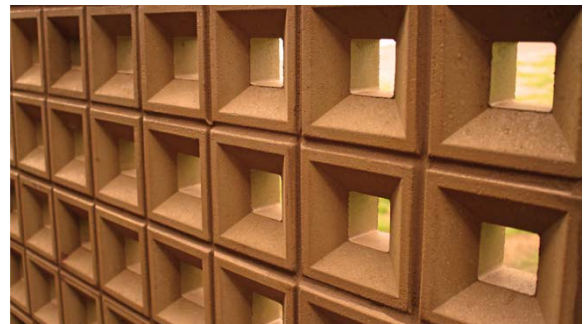
Figura 6. Detalhe de um painel construído com os módulos vazados Ecoterm®
