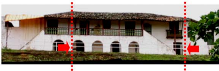
Figura 7. Fachada do engenho Poço Comprido, Vicência/PE, com indicativo do trecho originário.
