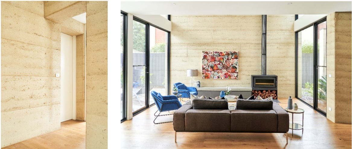
Figura 24 – Detalhes da taipa em ambientes internos
