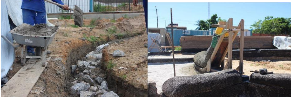
Figura 5 – Detalhe da fundação de pedra argamassada, “hiperconcreto” e impermeabilização
