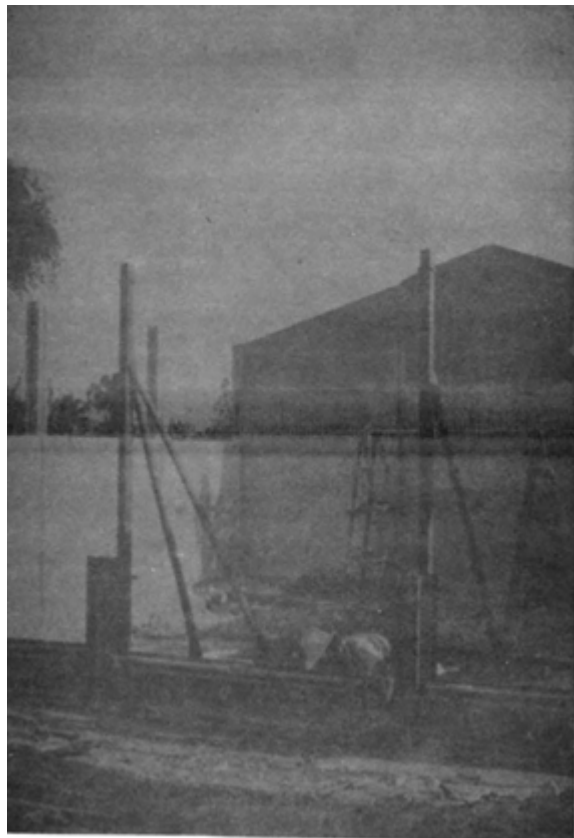
EXECUÇÃO DE PAREDES MONOLÍTICAS COM USO DE GUIAS EXTERNAS DE MADEIRA
