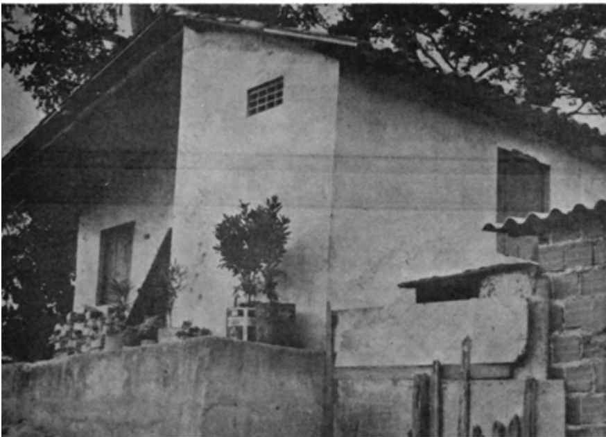
PROTÓTIPO EXECUTADO NO BAIRRO FAZENDA SETE DE ABRIL – SALVADOR (BA)
