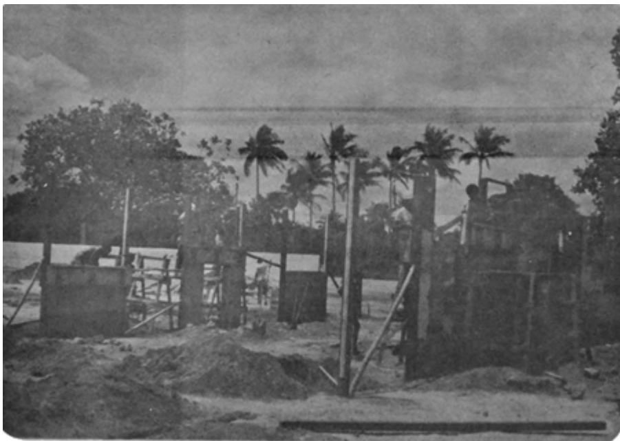
EXECUÇÃO DE PAREDES COM GUIAS RECUPERÁVEIS DE MADEIRA
