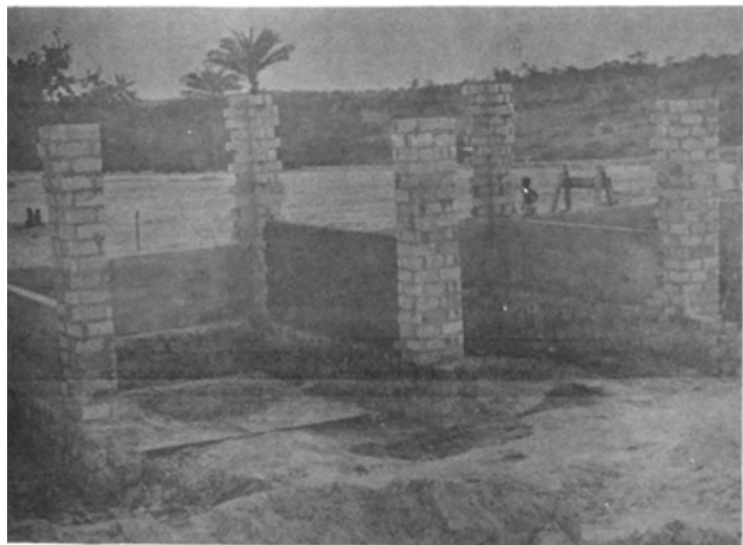
PILARETE DE TIJOLOS COMO GUIAS PERDIDAS
