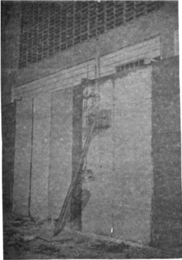
ENSAIO DE PERMABILIDADE DE PINTURAS NA PAREDE DE SOLO-CIMENTO COMPACTADO
