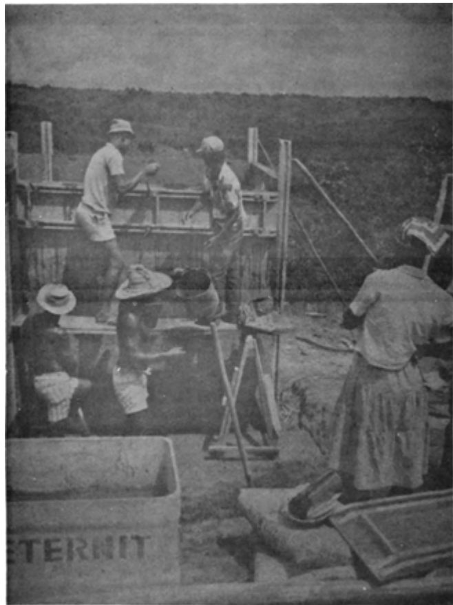
EXECUÇÃO DE PAREDES COM GUIAS PERDIDAS DE CONCRETO
