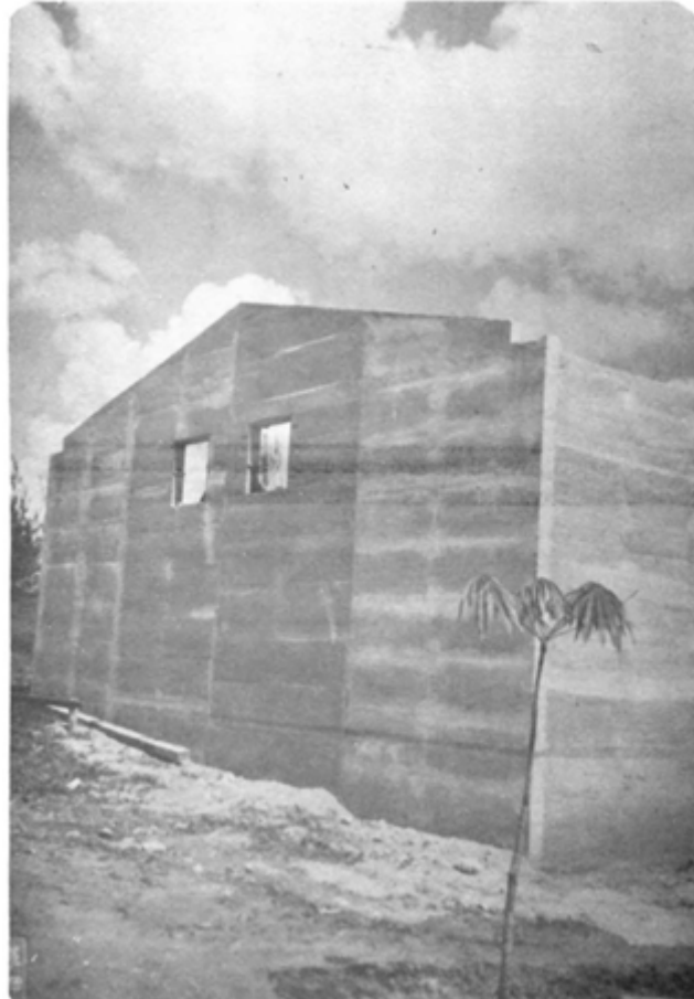
PAREDES EXECUTADAS COM GUIAS RESUPERÁVEIS DE MADEIRA
