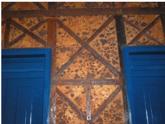
Figura 5 - Parede de um o sobrado em Alcântara com estrutura em Cruz de Santo André – observa-se o uso da pedra no preenchimento da parede. Foto: Margareth Figueiredo, 2006
