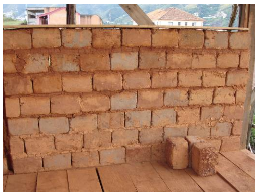
Figura 1 – Confeção de adobes para execução de parede
