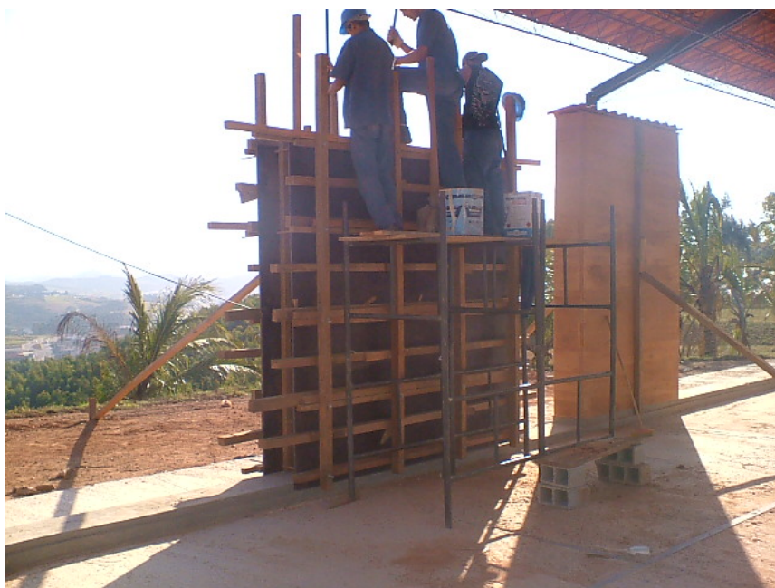
Figura 5 – Apiloamento de parede em taipa de pilão
