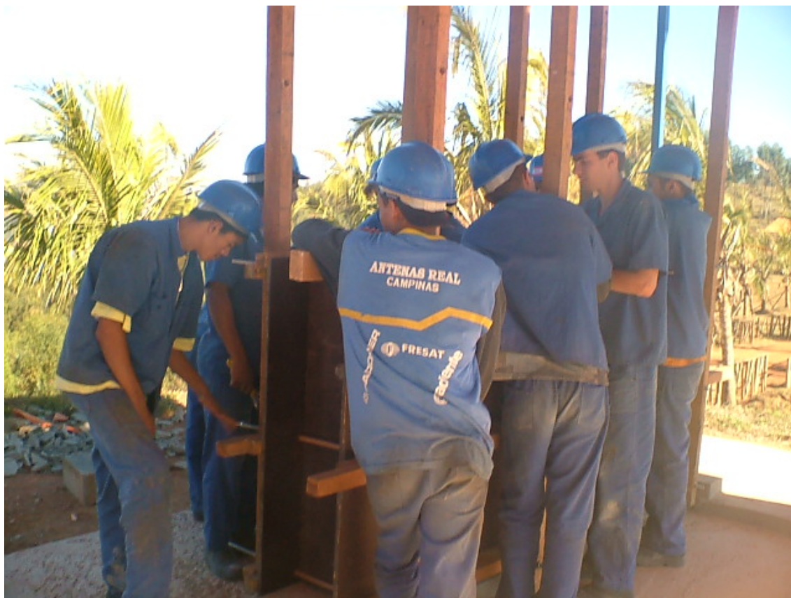
Figura 4 – Montagem de forma de taipa de pilão
