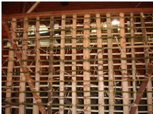
Figuras 3 e 4 – Execução da trama do pau-a-pique
