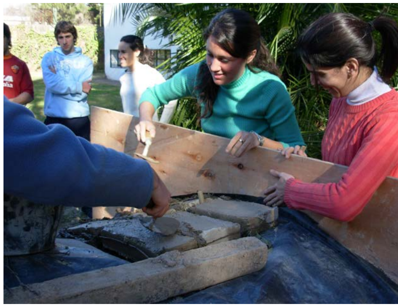
Figura 5 – Dovela de ladrillos de adobe estabilizado
