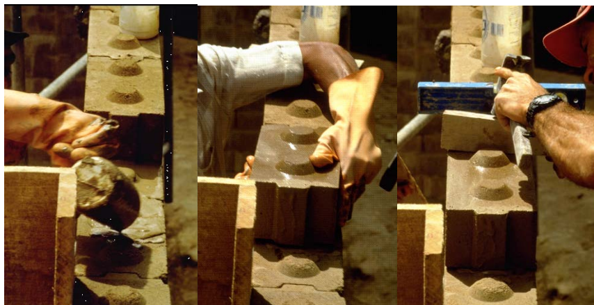
Figura 1 – Blocos Mattone e execução de alvenaria
