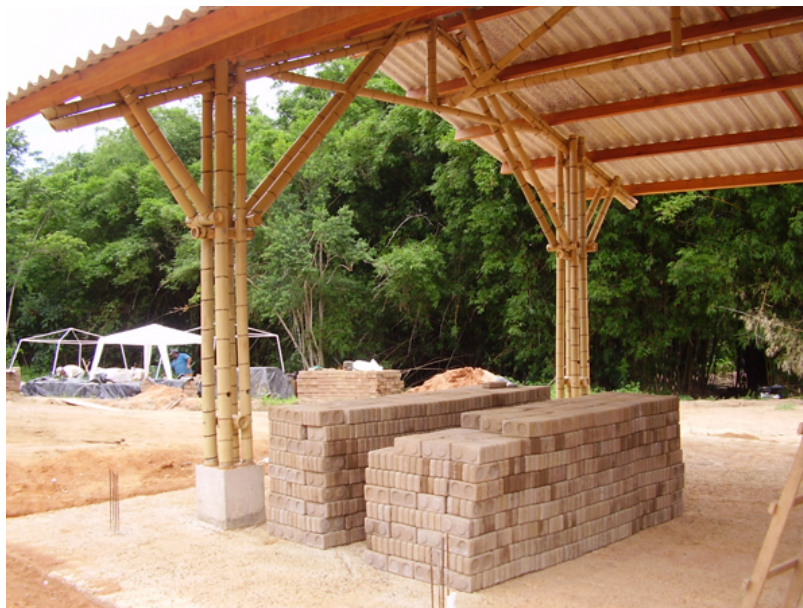
Figura 4- Galpão-garagem armazenando BTCs e ao fundo produção local do BTC
