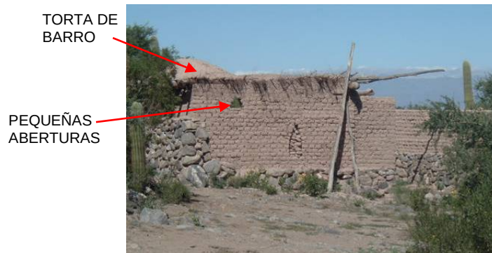
Figura 2 – Construcción tradicional de muros de adobes de gran espesor y pequeñas aberturas
