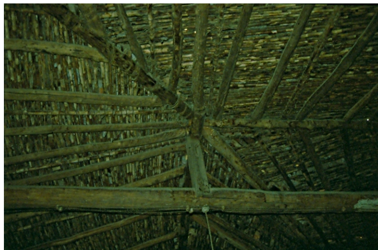
Figura 14 – Cubierta de caña, propicia para infestación. Foto: 1995, La Susana, Patricio Cevallos S.
