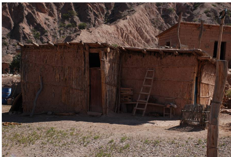
Figura 4 – Construcciones de quincha en Jujuy, Argentina
