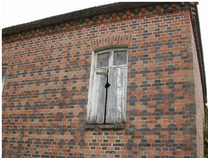
Figura 6 – Casa de alvenaria de tijolos aparentes
