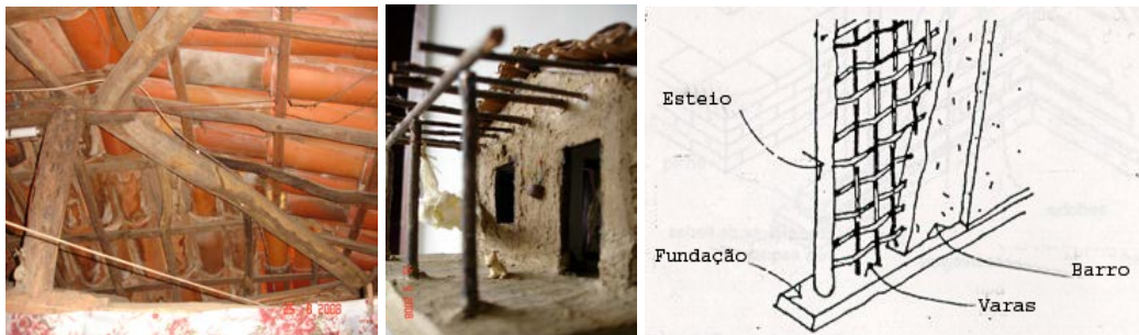
Figura 6 – Estrutura da cobertura e das paredes
