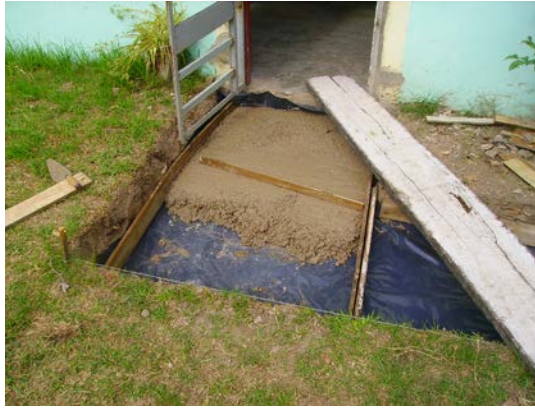
Figura 2 – Contrapiso colado con tosca estabilizada
