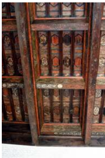
Figura 3 – Alfarge policromada del gran zaguán, apoyada sobre el arrocabe de yesería
