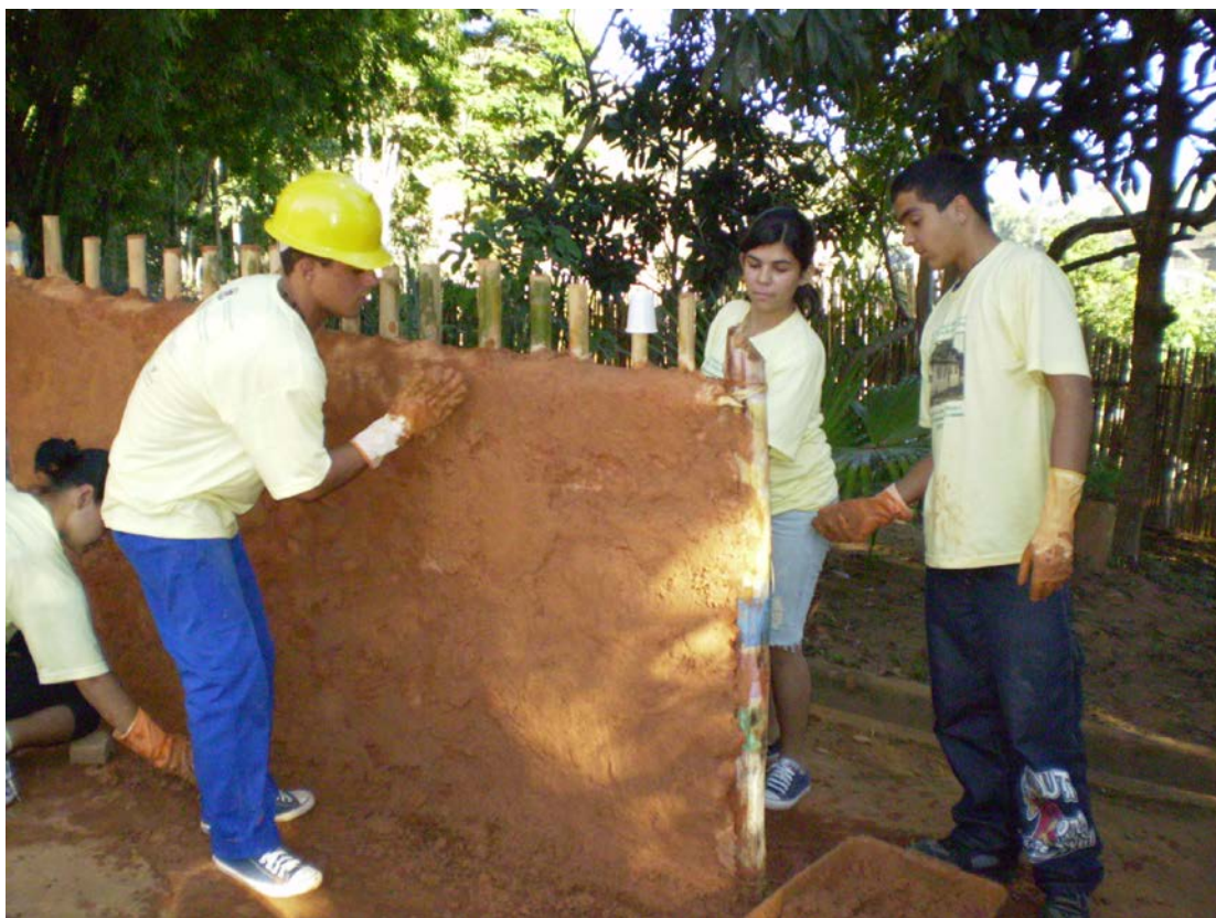
Figura 2 – Barreamento de parede em pau a pique
