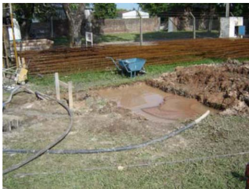
Figura 3 – Barros de excavación de pilotes
