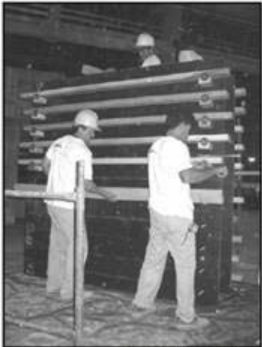
Fôrma de madeira
