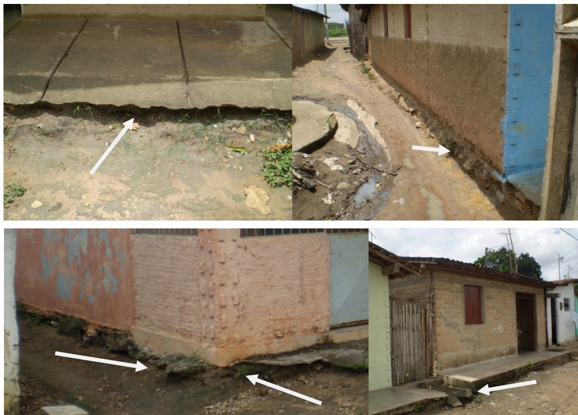
Figura 14 – Calçadas e fundações sendo descalçadas pela erosão do solo e falta de cuidado dos moradores
