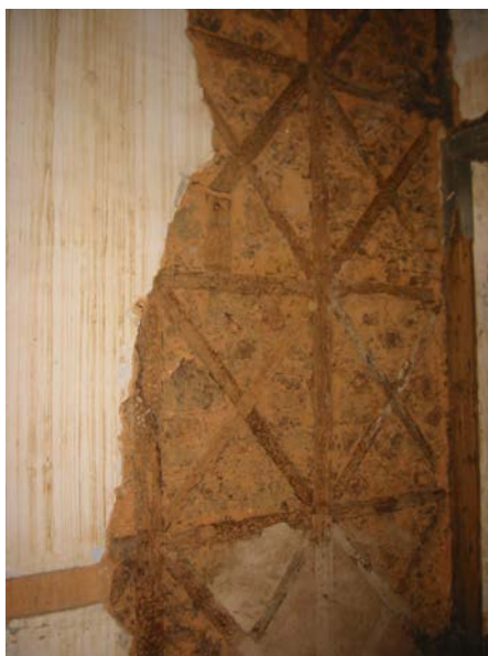
Figura 3 – Paredes do Solar dos Leite com reboco deteriorado, mostrando a estrutura em cruz de Santo André. Foto: Luisa Venancio
