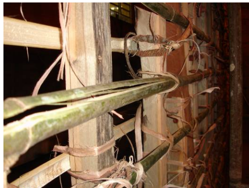
Figuras 3 e 4 – Execução da trama do pau-a-pique
