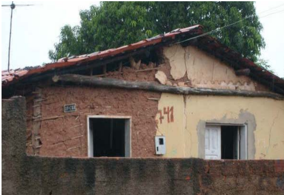
Figura 5 – Casa de taipa de mão, vendo-se a madeira flexionada
