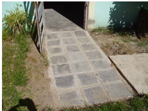
Figura 4 – Piso terminado con junta con mortero cementicio
