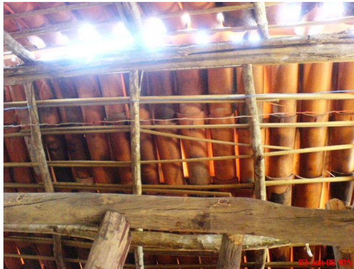
Figura 6 – Fresta na cumeeira sem acabamento Fonte: Thiago Melo, 2008
