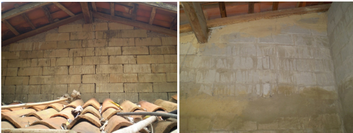
Figura 12 – Falta de limpeza da alvenaria quando da execução
