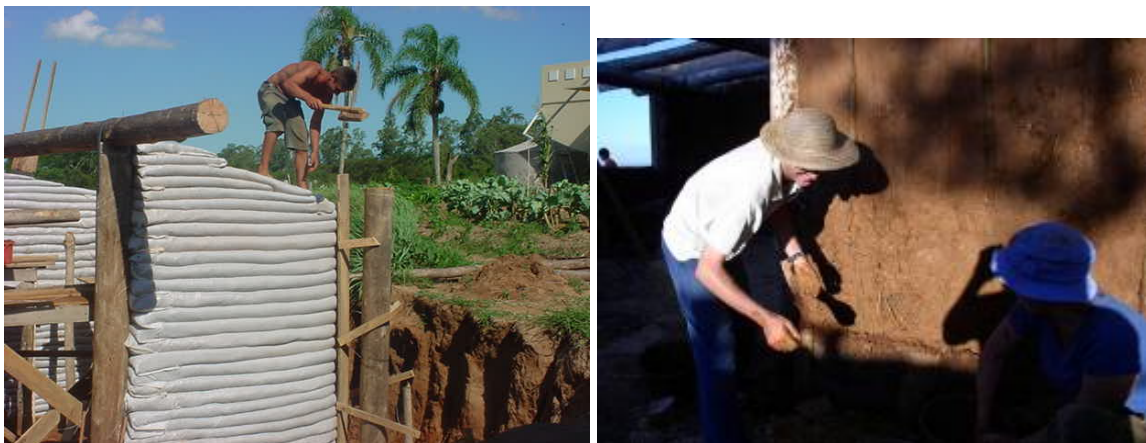
Figura 1 – Superadobe (a) e reboco de terra (b)
