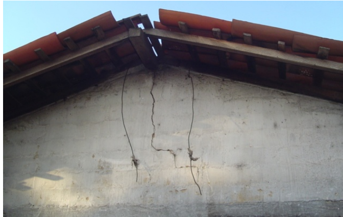
Figura 8 – Fissura causada pelo apoio direto da peça estrutural de madeira sobre o tijolo
