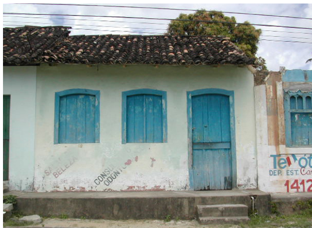
Figura 1 – Casa térrea em partido de meia-morada construída em taipa com coberta em duas águas; cumeeira paralela à fachada; beiral simples em caibro
