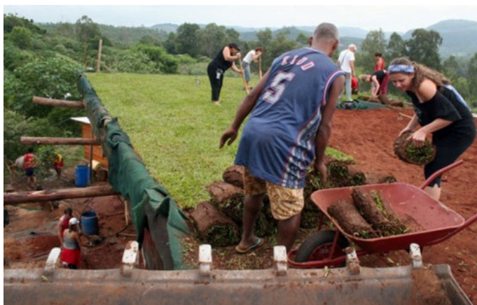
Figura 5 – Mutirão de construção do telhado vivo – IMCA
