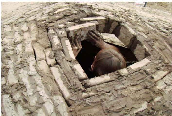
Figura 6 – Cierre de bóveda. Foto colectivo libre de fotografía
