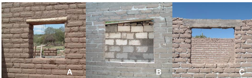
Figura 5 – Distintos casos registrados: A- muro adobón-dintel triple rollizo; B- muro BSC- dintel de junta reforzada 2Φ8; C- muro adobe-dintel de hormigón armado
