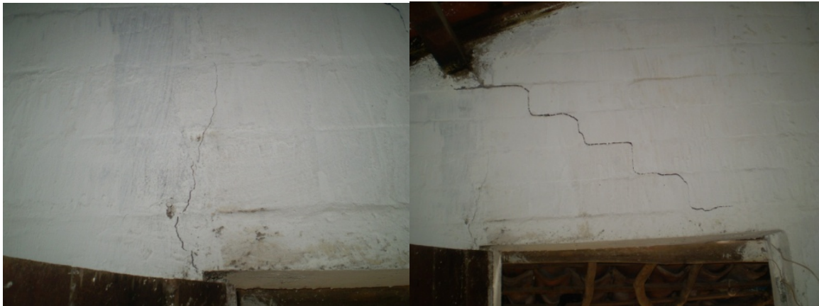
Figura 9 – Fissuras provocadas pela pouca rigidez da cinta sobre vãos de portas
