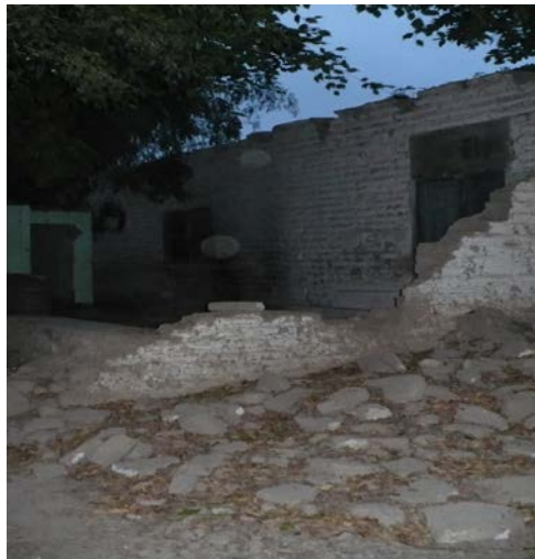
Figura 5 – Vivienda típica de adobe en Santa Luisa
