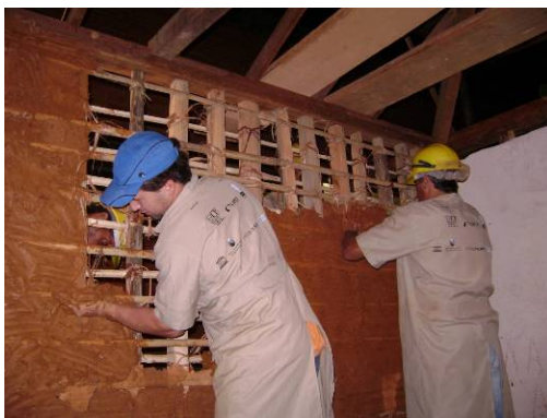
Figura 2 – Preenchimento do pau-a-pique com barro
