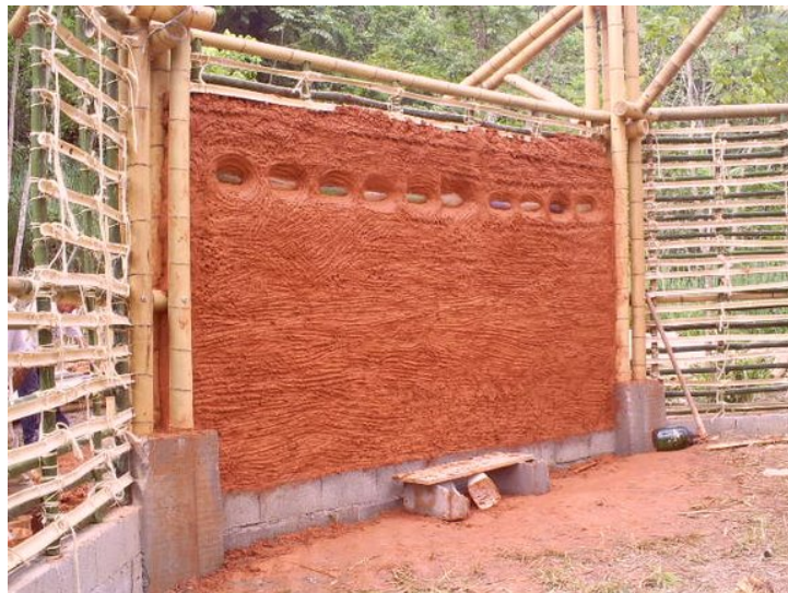
Figura 2 – Parede de taipa de mão no Pavilhão iBiosfera
