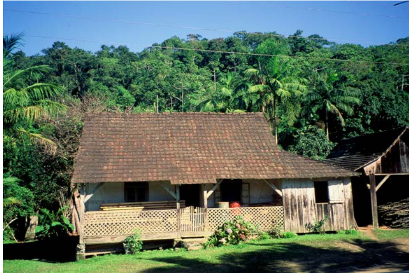
Figura 3 – Casa enxaimel inteiramente com vedações em taipa de mão
