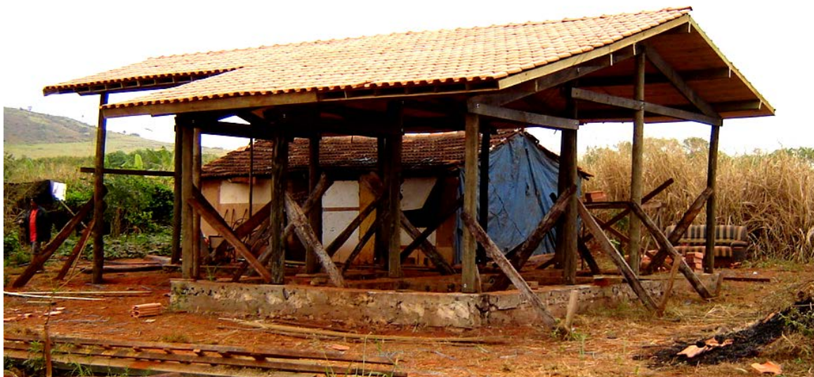
Figura 1 – Casa com sistema estrutural pilar-viga
