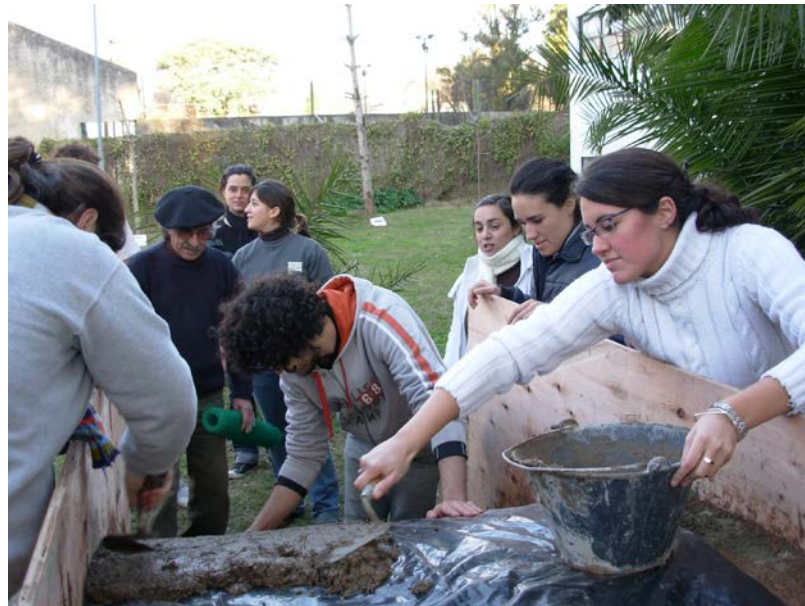
Figura 4 – Media bóveda, malla plástica y suelo cemento
