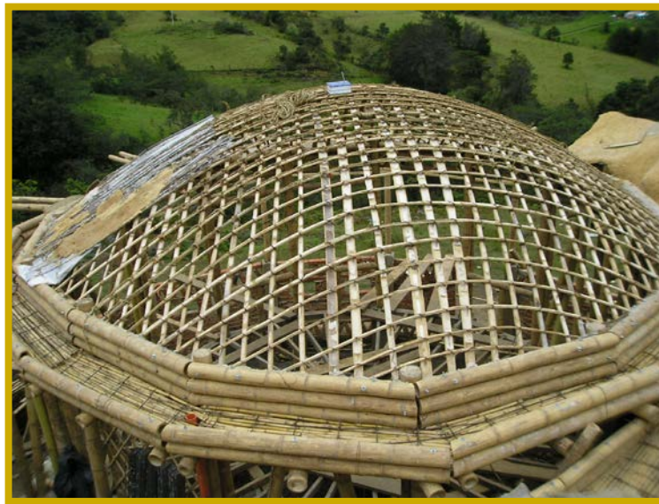
Figura 2 – Domo techo experimental de 7 metros con latas de guadua - Arq. Clara Ángel Gachantiva, Boyacá, Colombia
