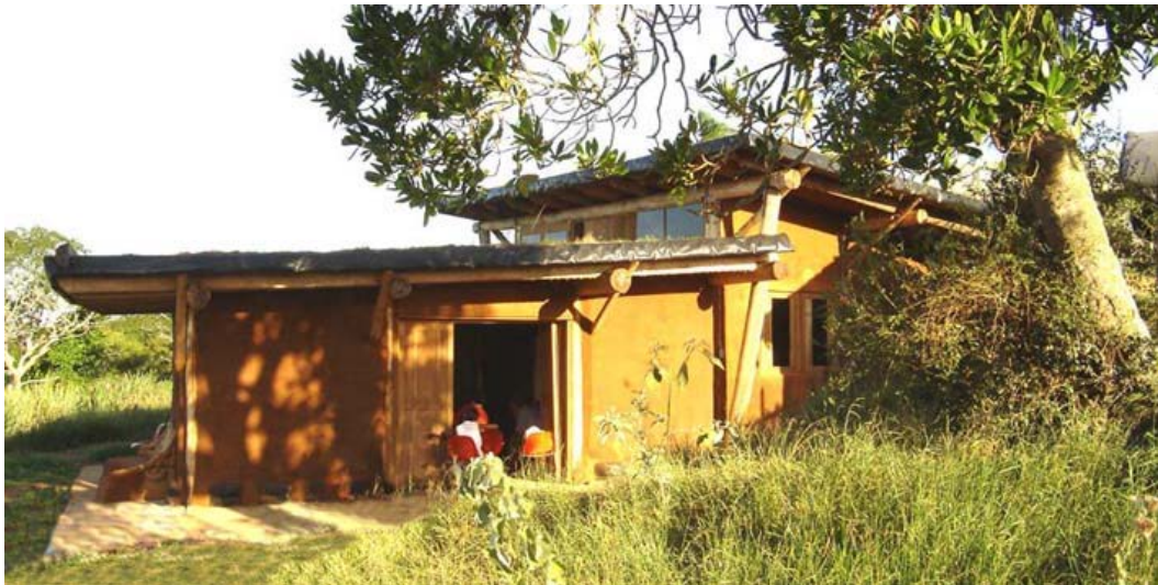
Figura 4 - Oficina do Assentado – obra concluída
