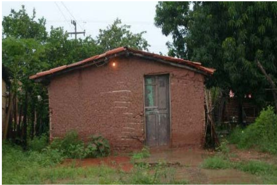
Figura 4 – Casa de taipa de mão sem reboco
