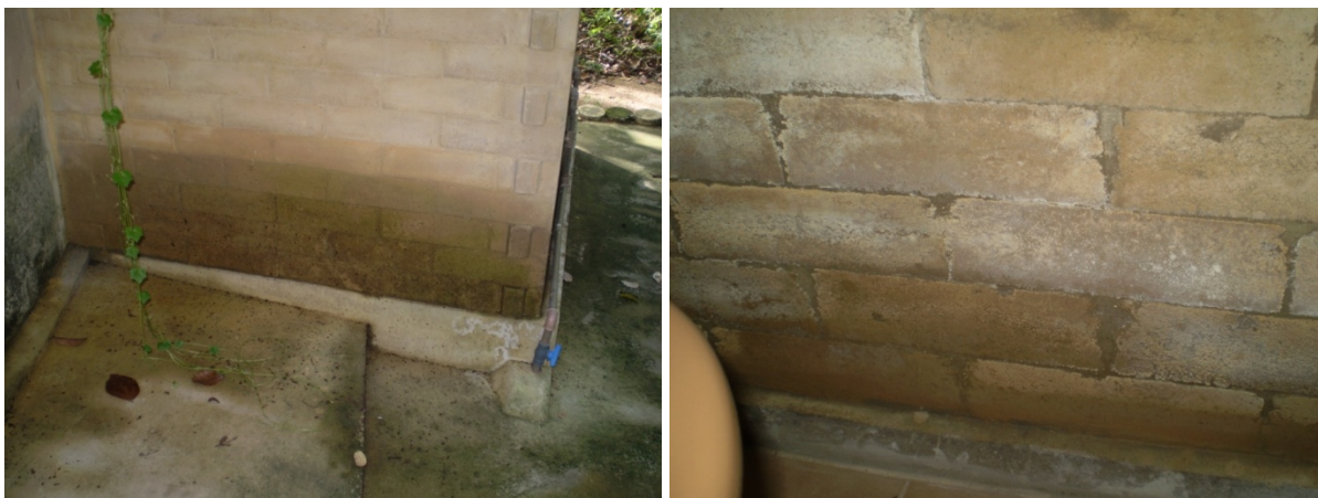
Figura 11 – Paredes com excessivo contato com água de respingos de chuva e com manchas de lixiviação na parte interna
