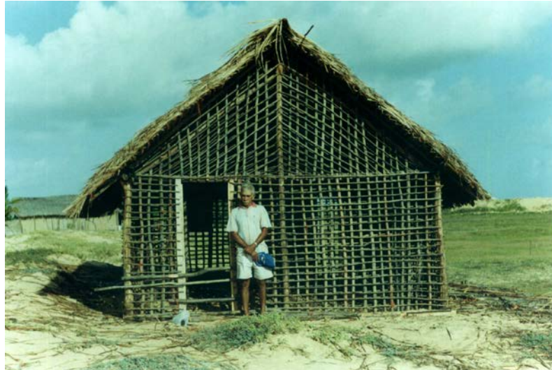
Figura 1 – Casa pronta para o tapamento
