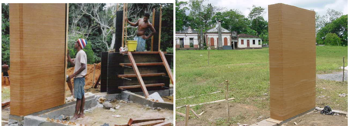
Figura 5 – Construção do Centro Comunitário em Ilhéus
