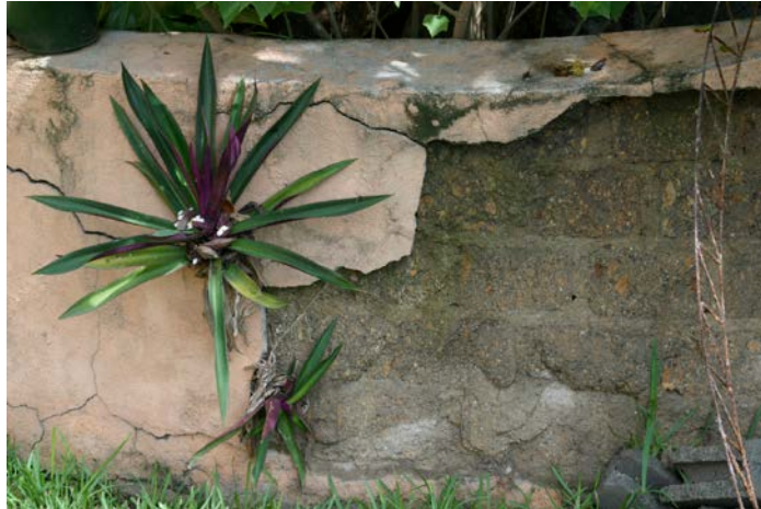
Figura 1 – El Trópico favorece la vida, inicia con el moho, aparecen las grietas, nace la flora y llega el posterior colapso, primero del repello y luego del muro completo
