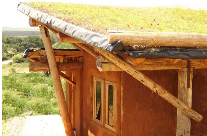
Figura 2 – Telhado vivo (b)
