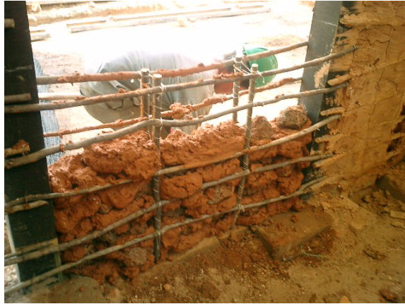
Figura 5 – Relleno de barro y cal - Casa Rafael Urdaneta. Fuente: Empresa Arquiluz, 2007
