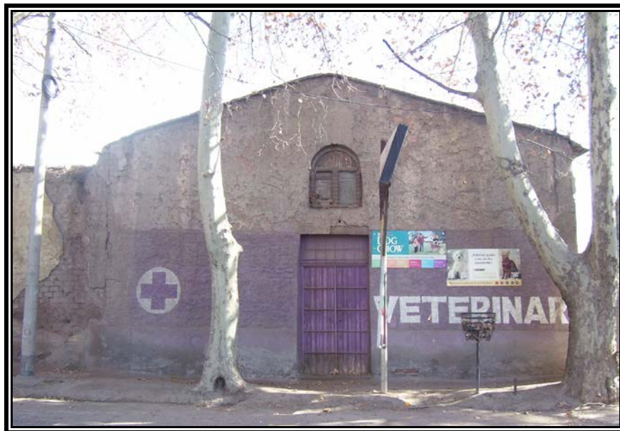
Figura 1 – Fachada del edificio
