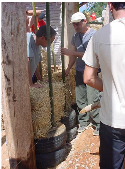
Figura 3 - Workshop alvenaria de fardos de palha (a) e Workshop telhado vivo (b)
