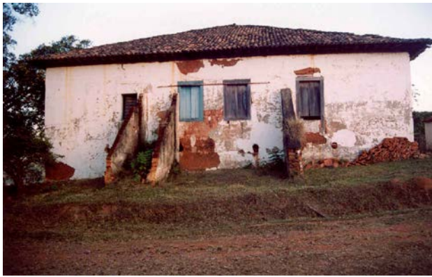
Figura 4 – Fachada lateral do casarão do Tatu em 2004, com o contraforteamento feito para impedir a abertura da parede. Trincas e falhas no reboco da Igreja da Boa Morte em 2004, antes da pintura atual em terra.
