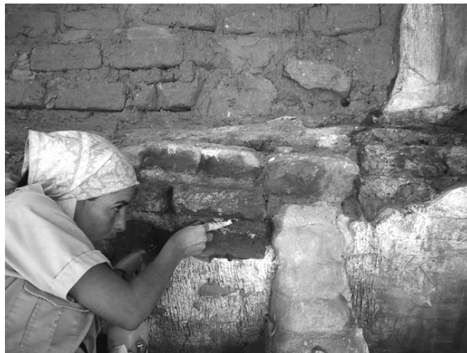
Figura 7 – Limpieza y consolidación de las yeserías del presbiterio
