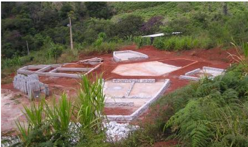
Figura 1 – Vista geral da implantação, com os muros de cantaria prontos para o assentamento dos adobes em solo-cal
