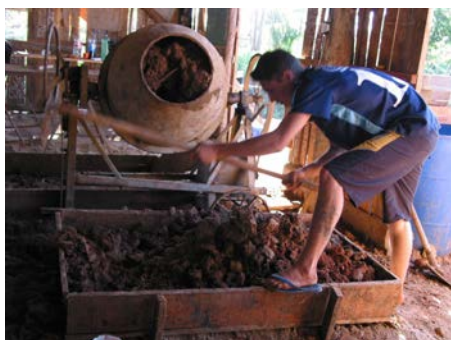
Figura 2 – Mistura da argamassa, COOHAP
