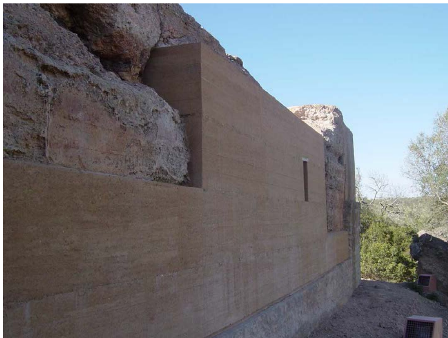
Figura 6 – Pano de muralha finalizado
