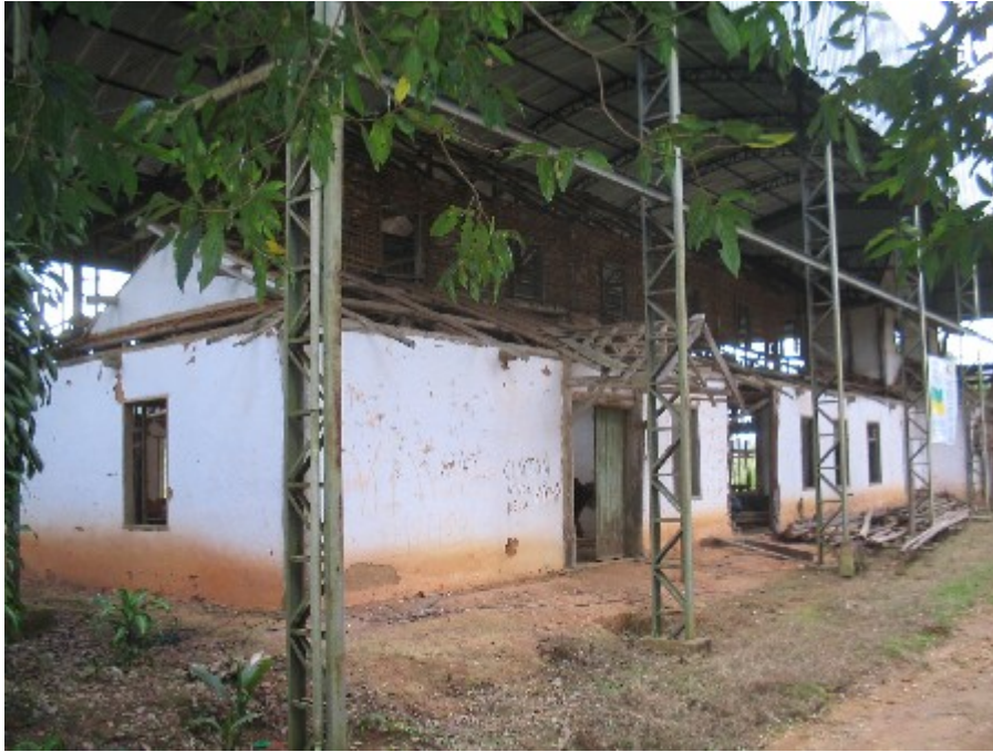
Figura 1 – Aspecto do Casarão do Chá, em processo de restauro, junho de 2006
