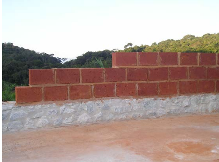
Figura 3 – Alvenarias em adobe solo-cal, 20,0x20,0x32,4cm sobre muro de cantaria
