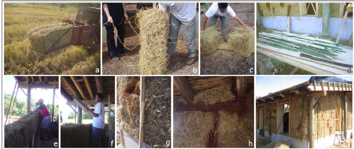
Figura 4 – Seqüência construtiva das paredes de fardo
