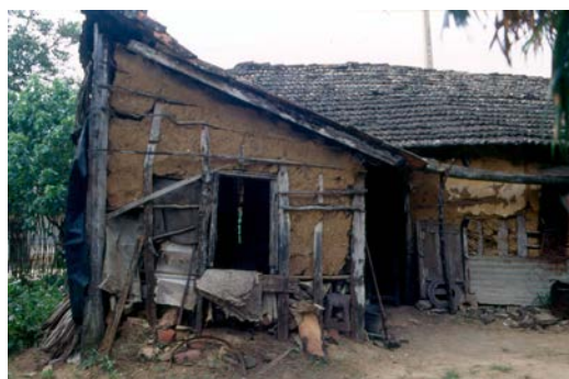
Figura 2 – Casa em pau-a-pique – San Pedro, Trinidad, Cuba
