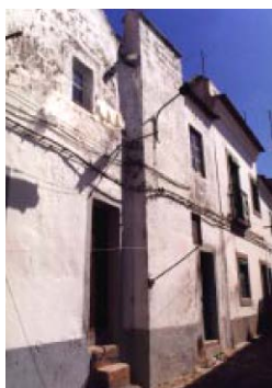
Figura 9 – Estremoz (Évora). Casa urbana de dois pisos com chaminé
