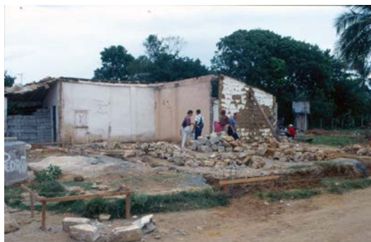
Figura 1 – Visita técnica dos arquitectos às obras em curso – San Pedro, Trinidad, Cuba
