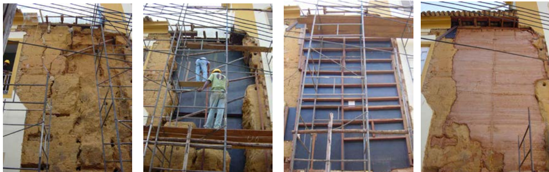
Figura 1 - Seqüência fotográfica dos trabalhos de restauro na fachada lateral leste entre janeiro e fevereiro de 2006: a) situação da área com o grande desprendimento e fissuras estruturais; b) desmontagem da área da taipa de pilão comprometida estruturalmente; c) situação após a reconstrução da área, com o "taipal" progressivo; d) após retirada do taipal, vista da área reconstruída
