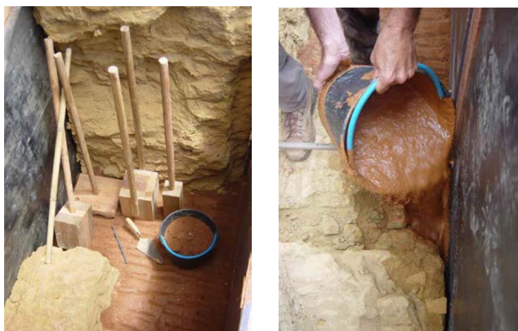
Figura 2 - Inovação e tradição na elaboração da Super-Taipa: a) pilões utilizados durante a execução da nova estrutura em taipa; b) lama líquida reforçada com fibras e dispersão de A. P. nas fissuras verticais da taipa histórica
