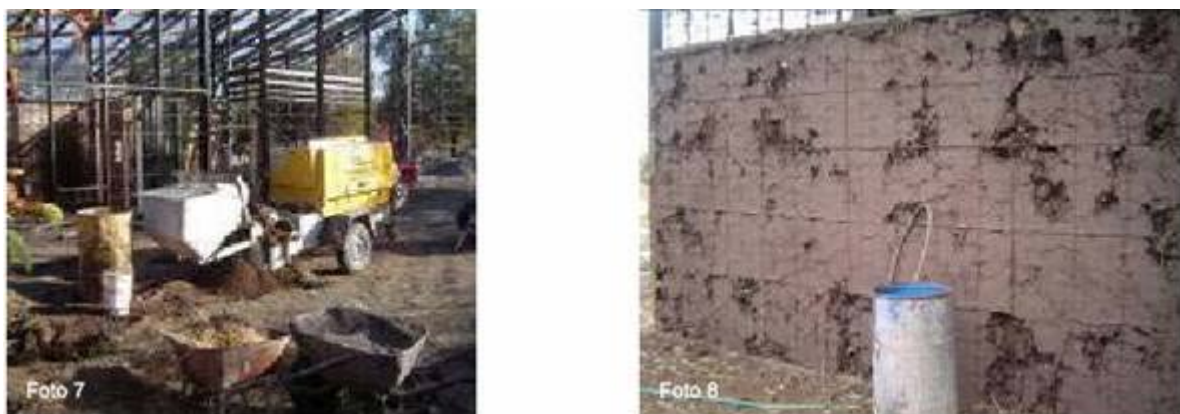
Figura 6 – Llenado de estructuras
