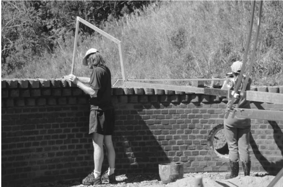
Figura 1 – Guía rotatoria para construir cúpulas sin encofrado
