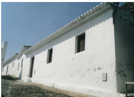
Figura 8 – Mértola (Beja). Casa urbana de um piso
