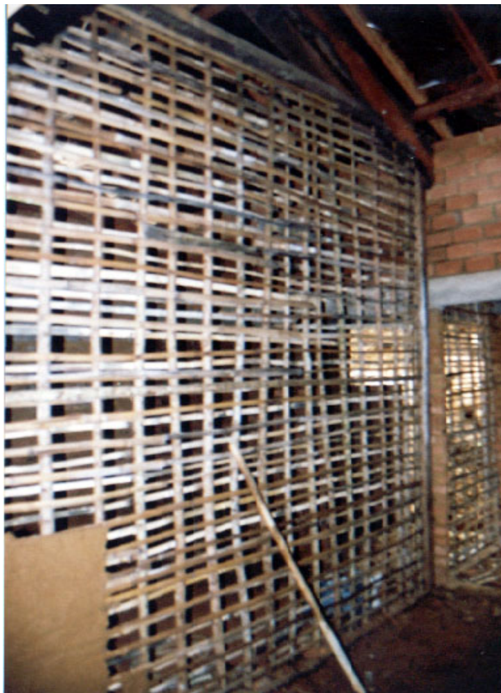
Figura 4 – Estrutura de madeira da taipa de mão. (Canteiro, 2005)
