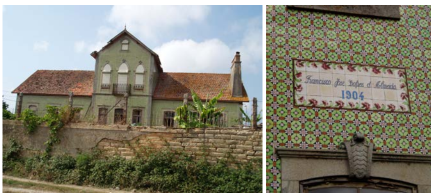
Figura 1 – Bunheiro (Murtosa). Casa construída em 1904 por Francisco José Lopes de Almeida, emigrante no Brasil.
