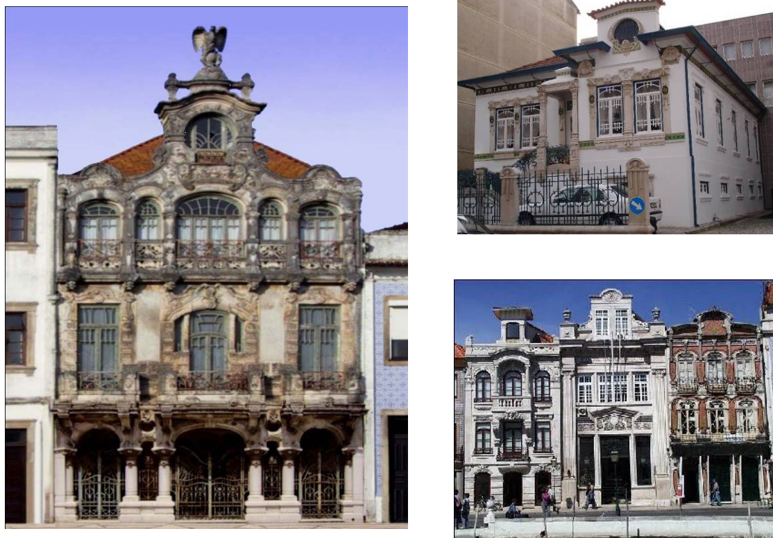
Figura 2 – Exemplos de edifícios em Art Nouveaux com paredes resistentes em adobe e elementos decorativos em pedra nas fachadas
