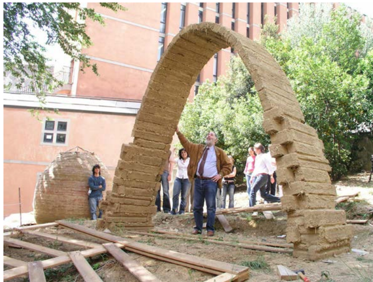
Figura 5 - El módulo de bóveda experimentado en la Facultad de Arquitectura Genova con la mano de obra de los estudiantes. La mezcla por los ladrillos está constituida exclusivamente por tierra y paja.
