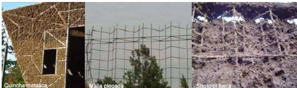
Figura 2 – Aspectos constructivos – la casa, el tramo de fiero e el barro
