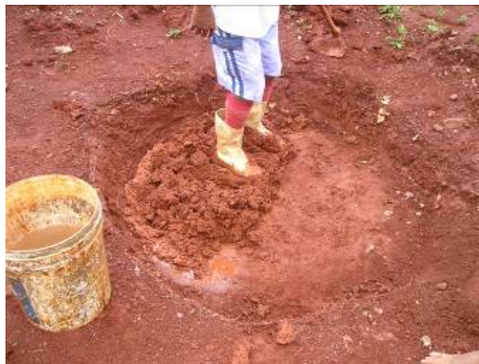
Figura 4 – Mistura, por pisoteamento, da massa composta de cal, solo e água
