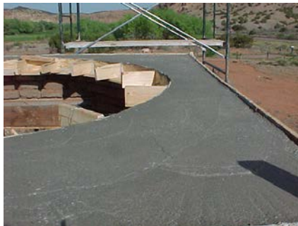
Figura 5 – Viga de ligação
