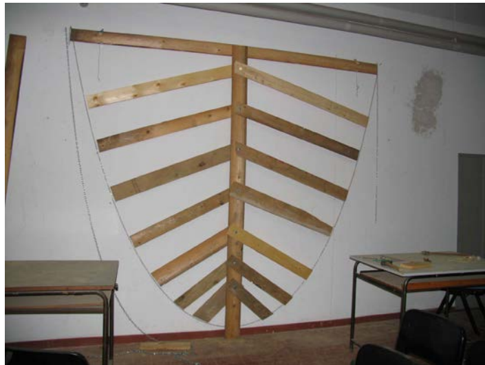
Figura 4 – Construcción de la cimbra para un módulo de la bóveda
