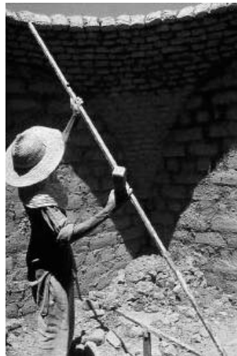
Figura 2 – Braço radial utilizado para o posicionamento dos tijolos na cúpula
