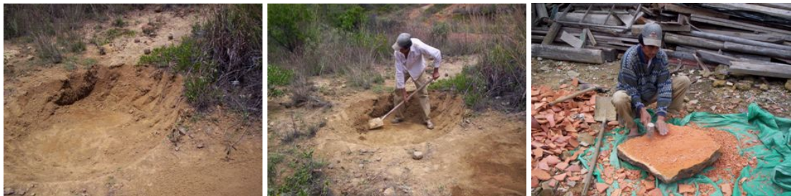
Figura 1 – Extracción de la tierra & trituración de residuos cerámicos
