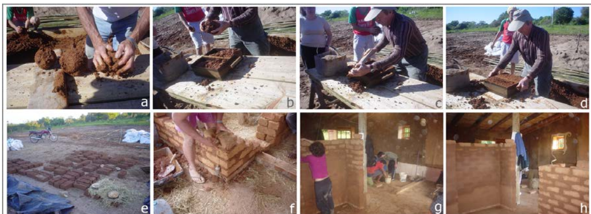
Figura 5 - Seqüência construtiva das paredes de adobe
