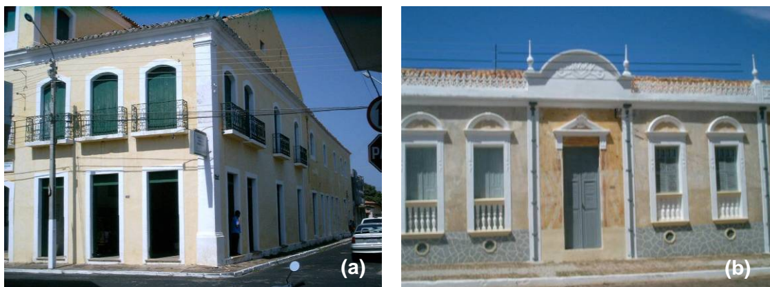
Figura 2 – Vistas da Biblioteca Pública Municipal em Parnaíba (a), e do Museu Memorial Tertuliano Brandão Filho em Pedro II (b), executadas com adobe Foto: Sandra Alexandria, 2006
