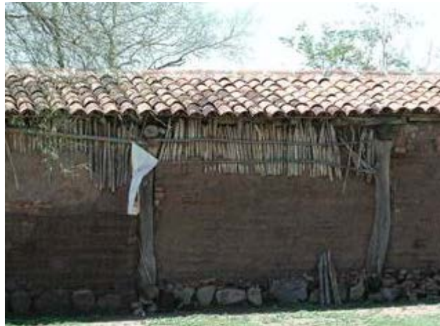
Figura 4 – Casa con muros de horcones y bajareque, zona de la Tierra Caliente.
