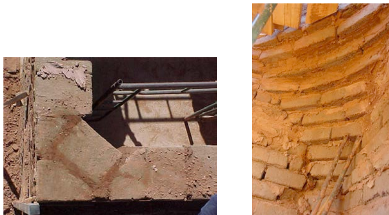
Figura 4 – Construção dos pendentes
