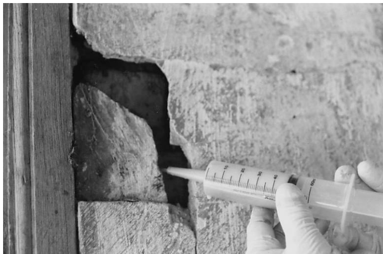
Figura 2 – Injeção de consolidante
