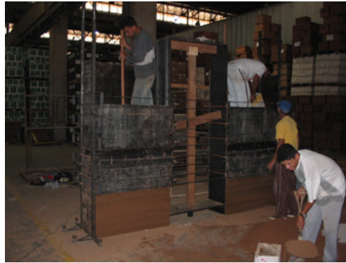
Figura 2 – Construção de painel de taipa de pilão em São Paulo, SP
