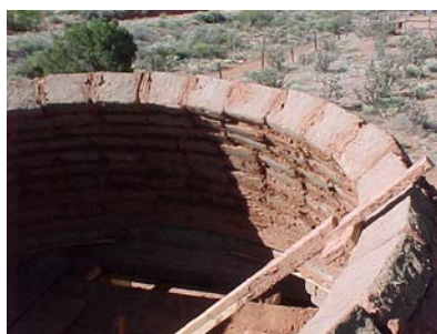
Figura 6 – Construção da cúpula
