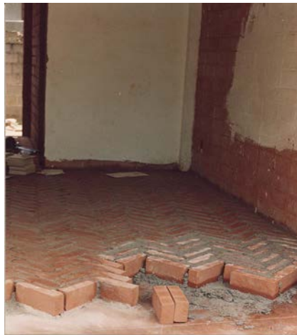
Figura 9 – Assentamento do piso
