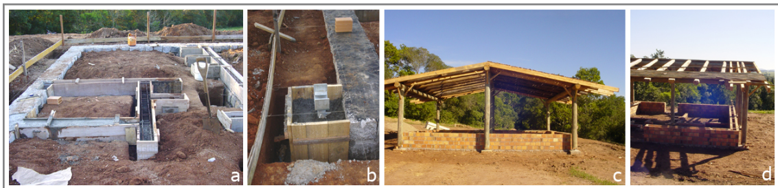
Figura 2 – Fundações e estrutura do Protótipo
