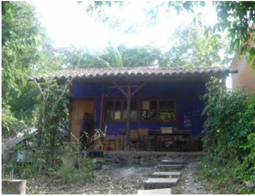
Figura 1 – Casa experimental de bajareque , construída na Facultad de Arquitectura de la UNACH, 2000
