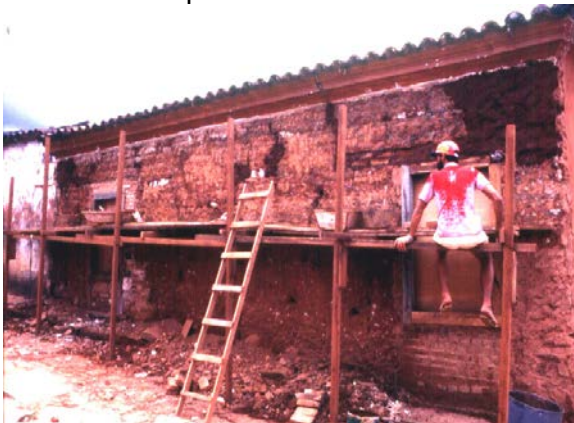
Figura 4 – Restauro de parede de taipa
