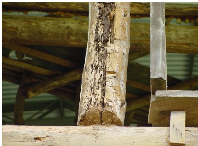
Figura 4 – Ataque intenso de cupins-arbóreos em madeira estrutural
