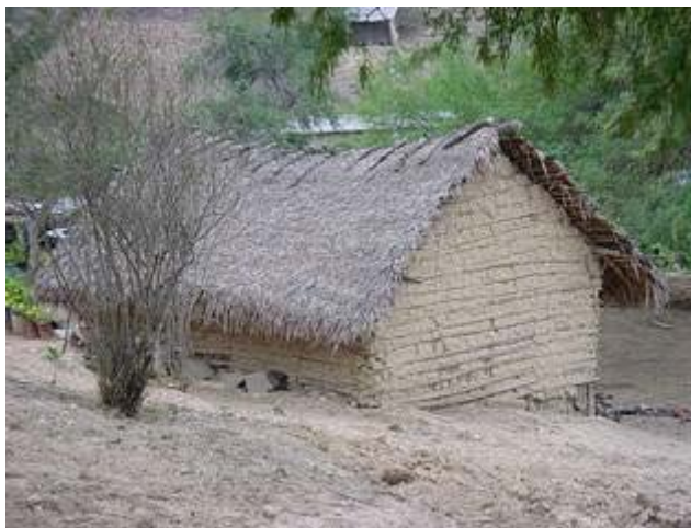
Figura 5 – Casa con muros de bajareque, zona de San Luis Potosí.
