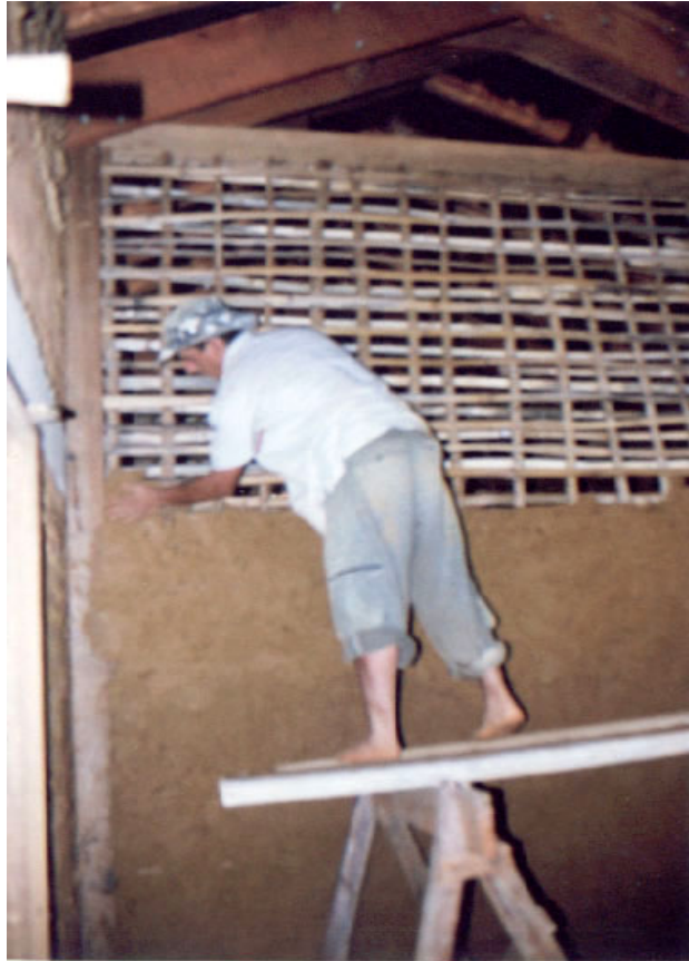
Figura 5 – Prensamento da argamassa de barro na trama (Canteiro, 2005)
