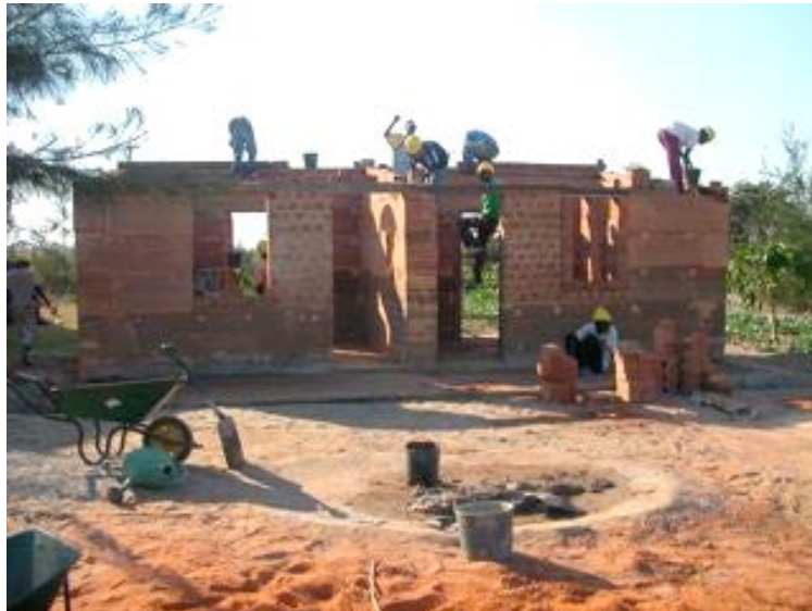
Figura 3 – Vista da obra
