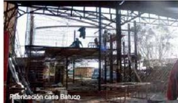
Figura 3 – Montaje del chasis metálico
