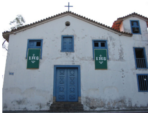
Figura 1 – Parede de taipa da Igreja do Embu, SP
