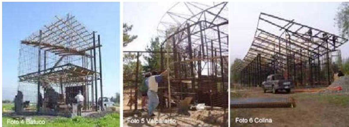
Figura 5 – Montaje de las estructuras
