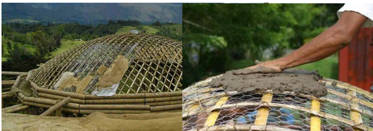
Figura 3 – Abóbada de bambu e terra
