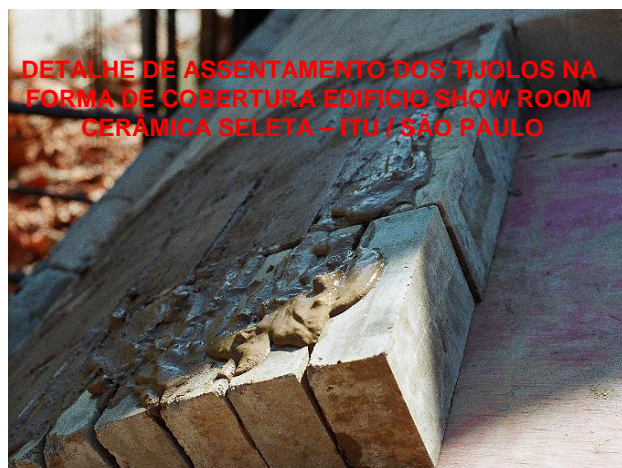
Figura 7 – Assentamento da forma de cobertura
