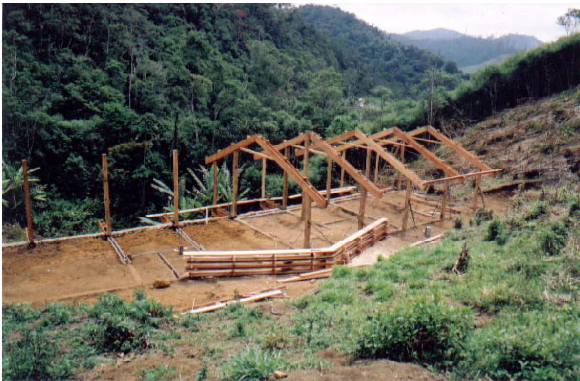
Figura 3 – Estrutura de Madeira. Canteiro (2005)
