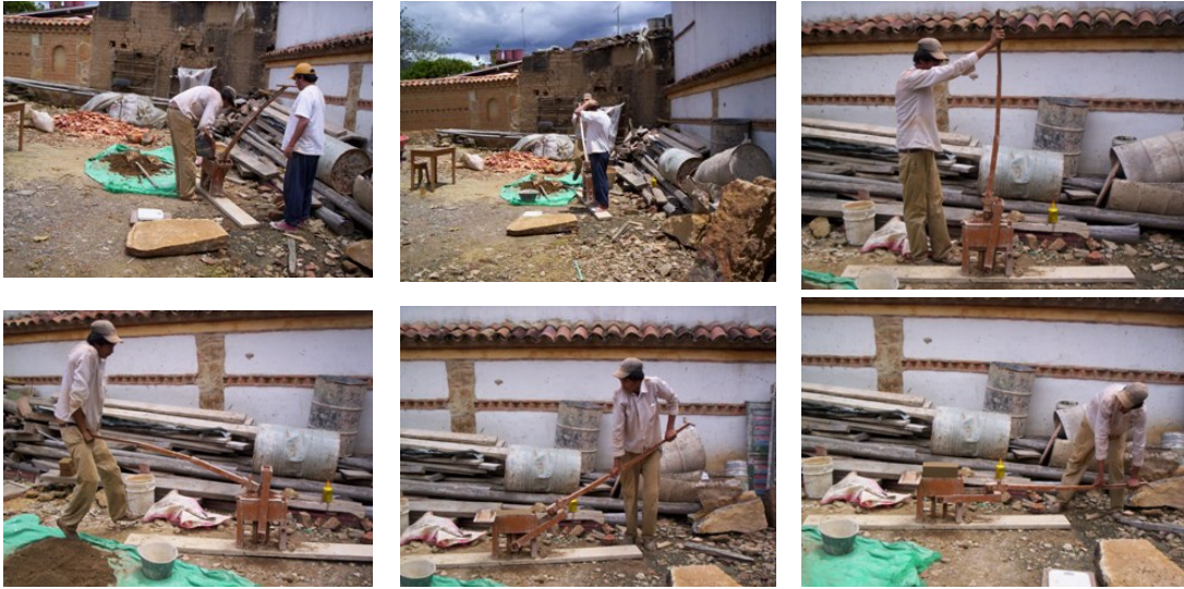
Figura 3 – Proceso de elaboración de bloques con inclusión cerámica.
