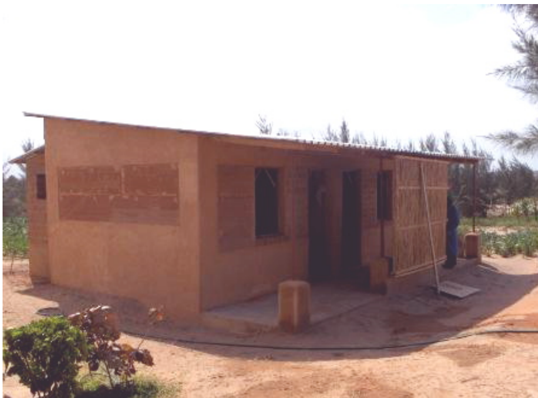
Figura 4 – Obra na sua fase de conclusão
