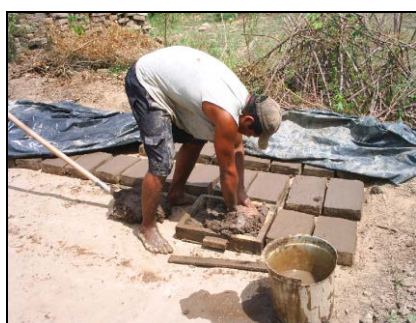
Figura 3 – Moldagem do adobe
