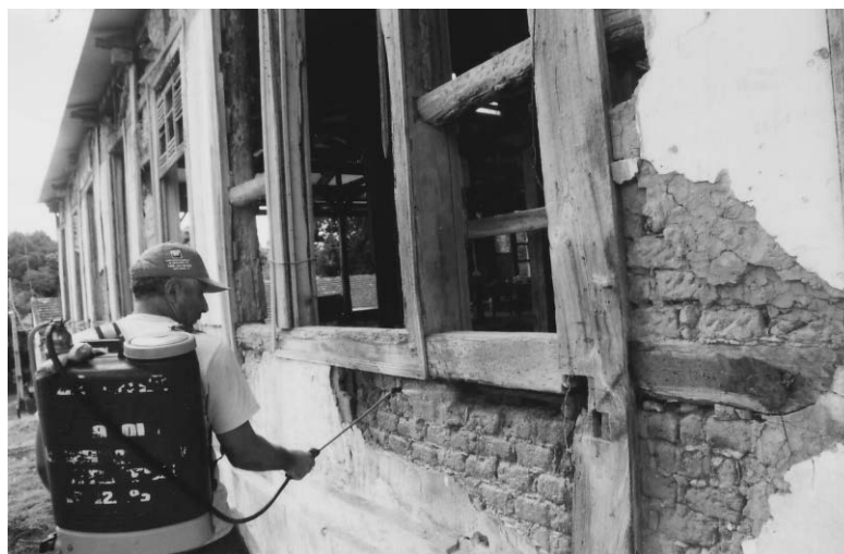
Figura 3 – Pulverização de Primal AC 33
