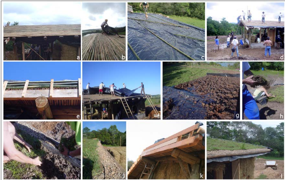
Figura 3 – Seqüência construtiva da cobertura verde
