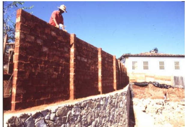
Figura 5 – Execução de muro de adobe
