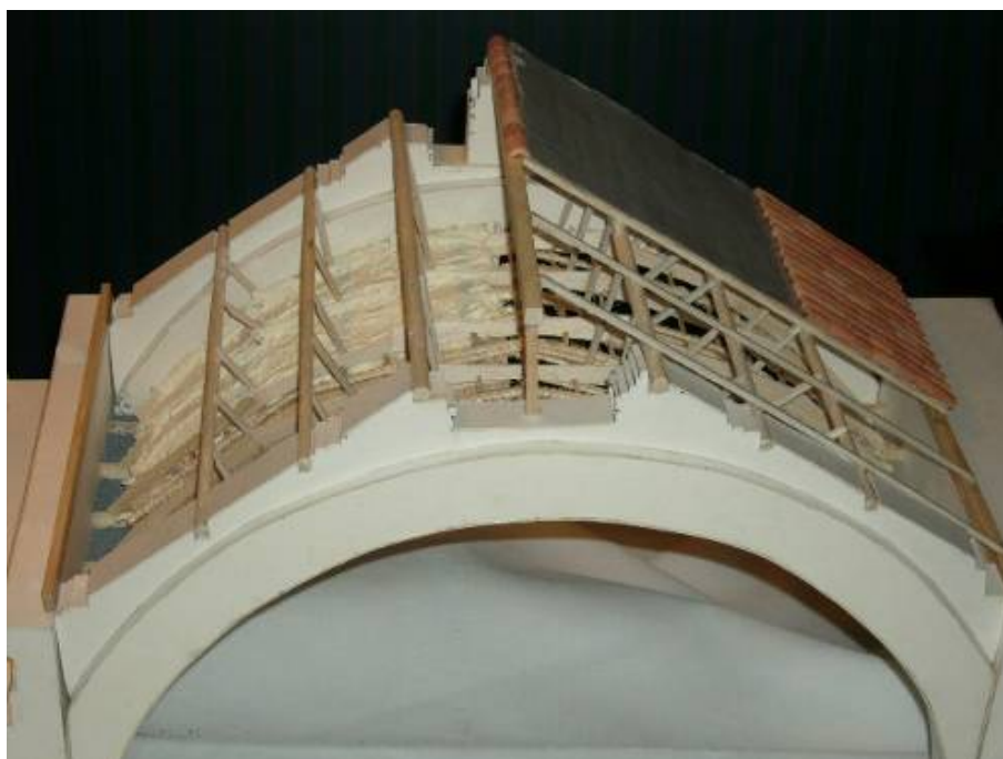
Figura 6 – Detalle de la bóveda y la cubierta
