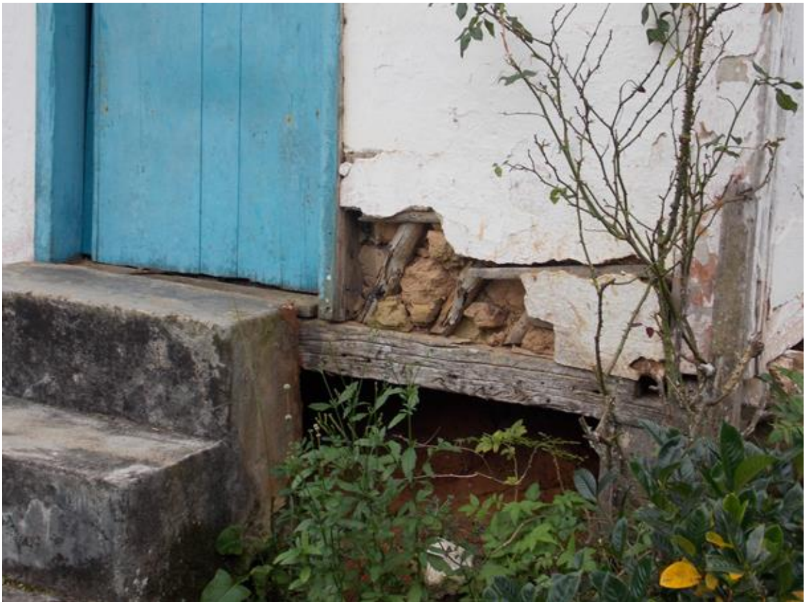
Figura 3 – Detalhe do encaixe do baldrame com o esteio. Aparece também como o trançado da taipa é simplesmente apoiado na estrutura de madeira.
