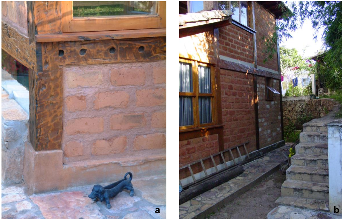
Figura 3: (a) detalhes da fundação, estrutura em madeira e vedação; (b) adobes antigos e novos.
