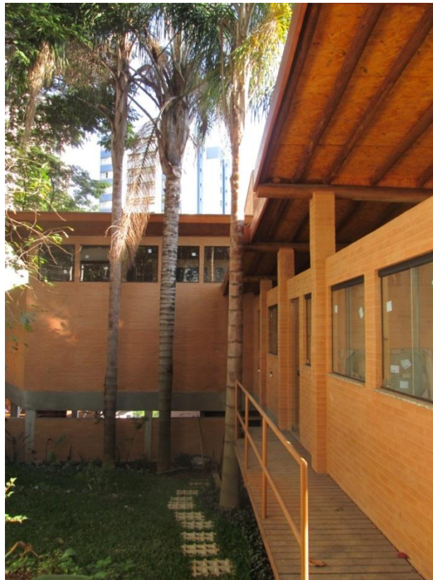
Figura 2 - Vista do setor de serviço
