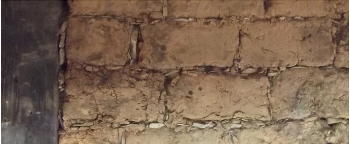
Figura 2. Alvenaria de adobe.
