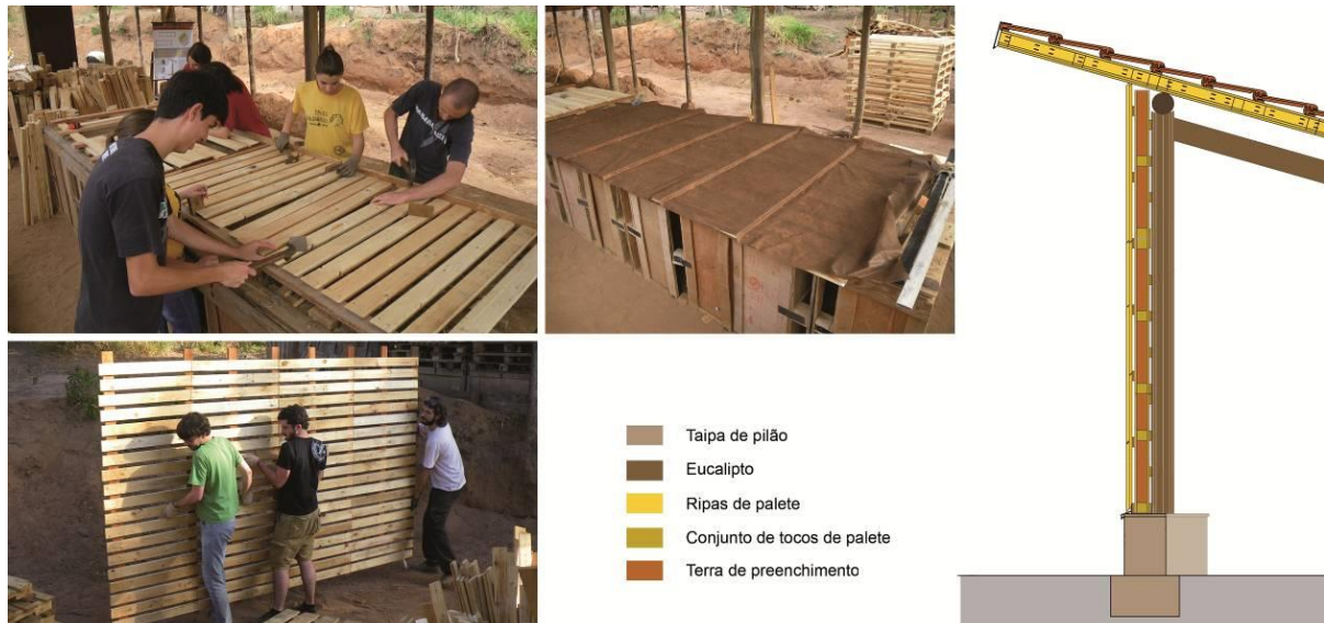
Figura 5 – Montagem e corte do painel de parede.
