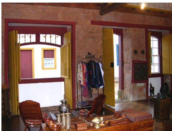
figura 5 - vista interna - fachada principal
