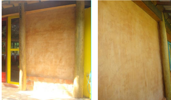
Figura 7- Revestimentos em 2014 do Bloco administração/eventos face Norte e Sudoeste
