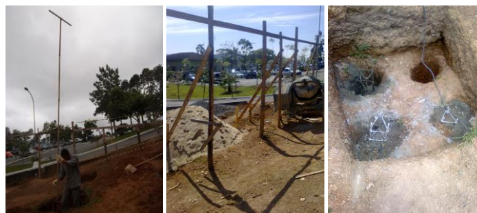
Figura 3 – Utilização do trado manual para a perfuração das brocas, escoras ao redor da estrutura do gabarito, brocas concretadas. Crédito: Duarte, 2013
