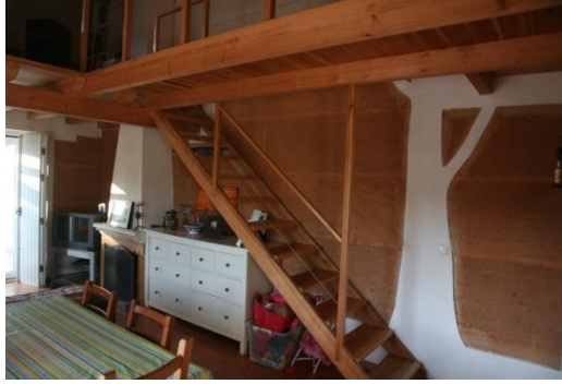
Figura 4. Recorte pictórico dos rebocos caiados sobre taipa na casa Zambujeira Velha de Santa Maria
