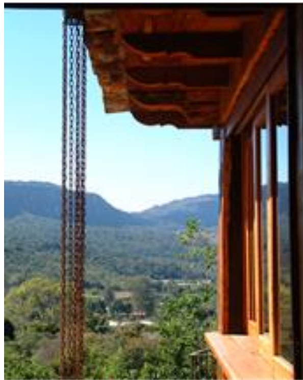
Figura 4. Detalhes do beiral encachorrado e esquadrias.
