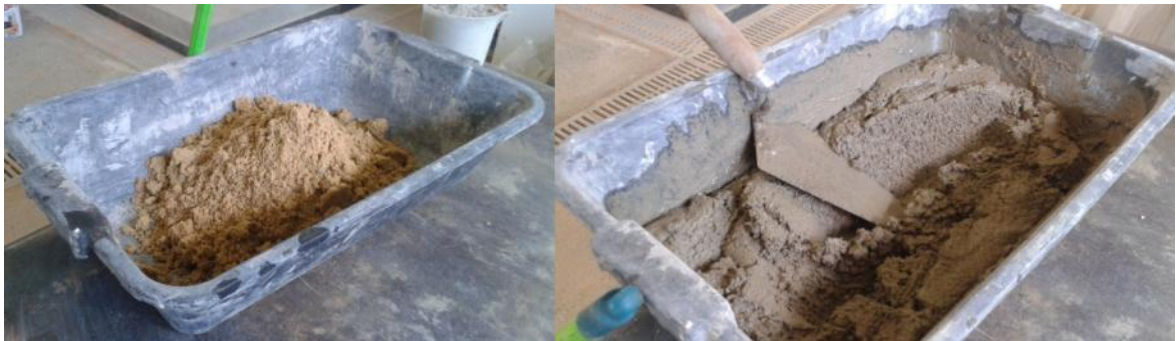
Figura 4 - Preparo da argamassa. Fonte: Vale, 2012.
