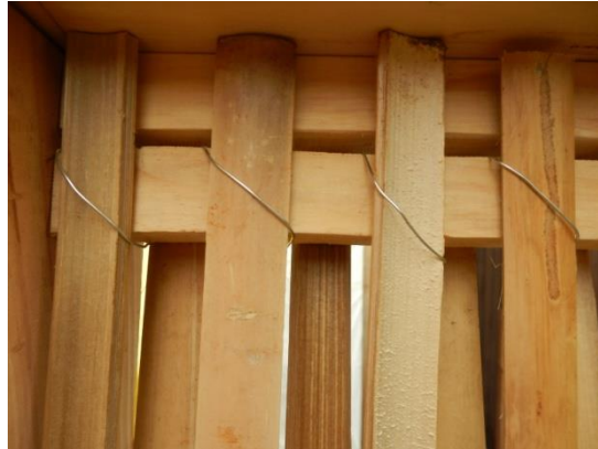
Figura 4: Fixação com arame. Fonte: Acervo Pessoal.
