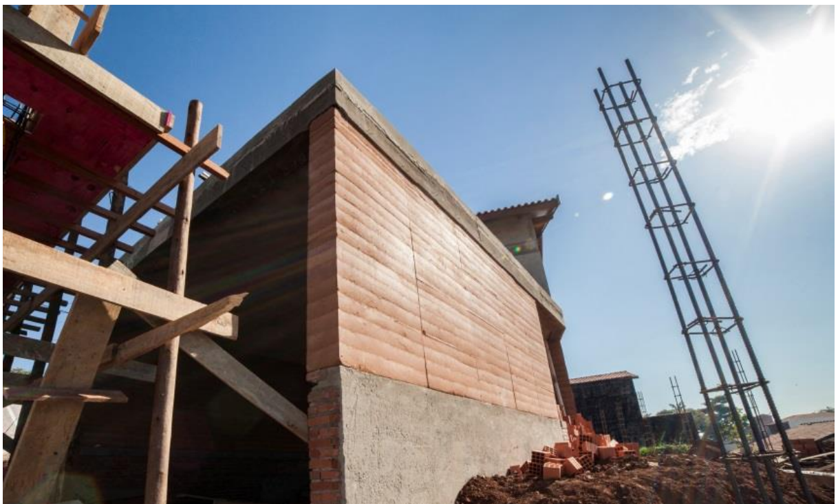
Figura 7 – Imagem da obra.
