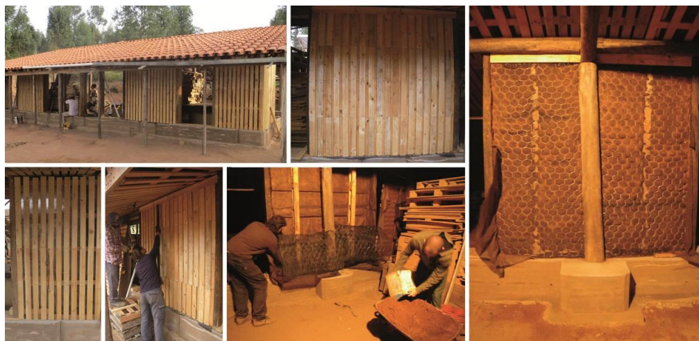
Figura 6 – Primeira realização da mata-junta e preenchimento da parede.
