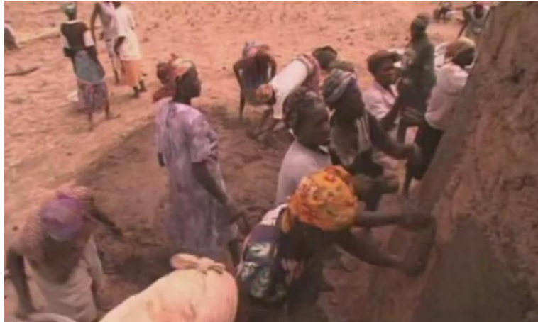
Figura 3: As mulheres da aldeia de Tera rebocam as paredes da casa do novo casal Katigura e Aganachi, em sua cerimônia de casamento. (Fonte: Katigura; Aganachi, 2014).
