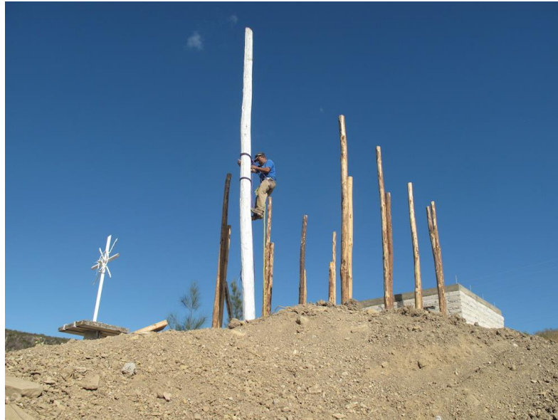
figura 3, las columnas de madera y la cadena de cierre (foto de los autores)
