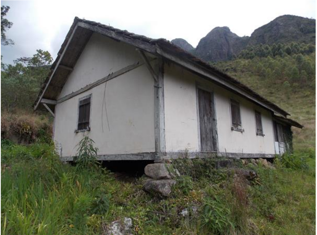
Figura 2 – Casa em Boa Esperança de Cima, distrito de Lumiar, exemplo típico da arquitetura de taipa encontrada na região.
