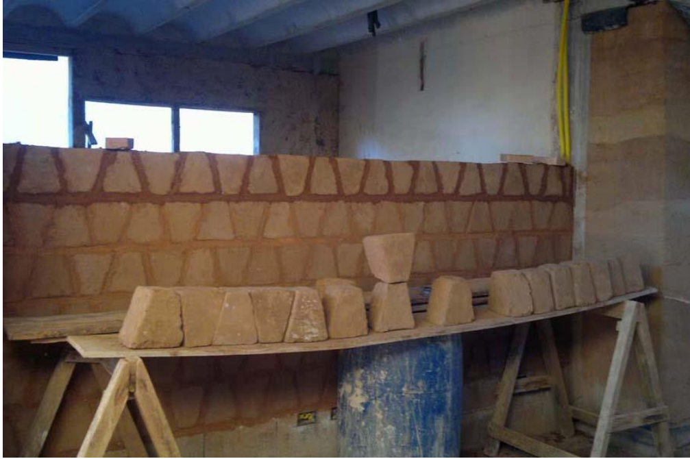
Figura 4 - Alvenarias de adobe e taipa de pilão
