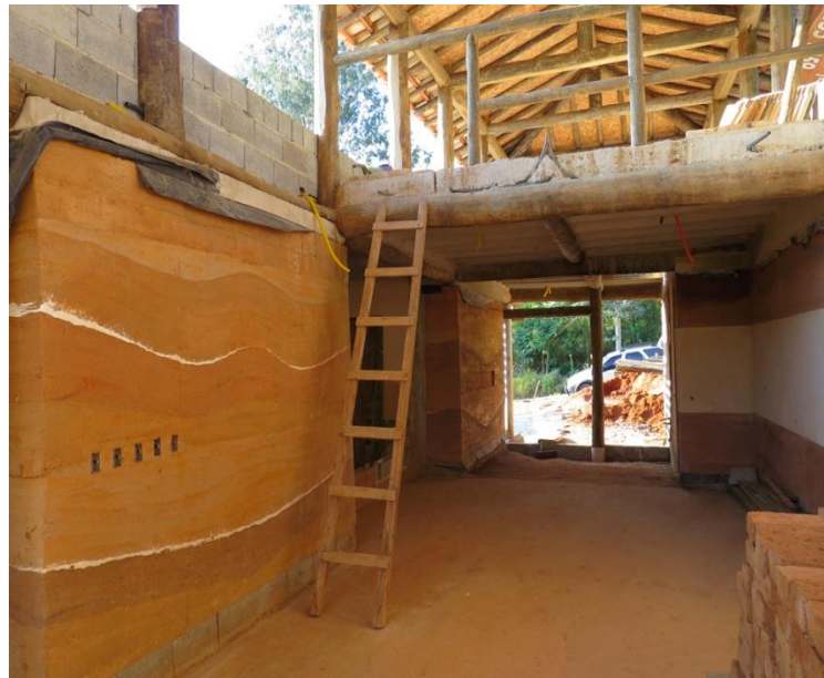
Fig. 06 - Vista da estrutura de madeira e alvenarias em terra
