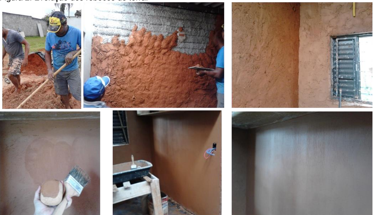
Figura 2: Evolução dos rebocos de terra.
