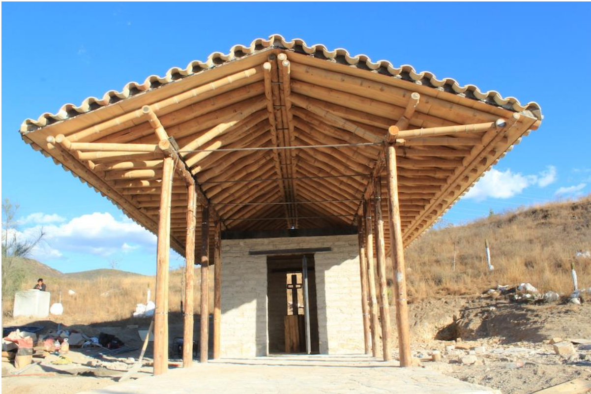
figura 4, la cubierta de bambú, triply y tejas (foto de los autores)
