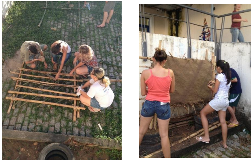
Figura 2 - Canteiro experimental da disciplina de Técnicas Construtivas Tradicionais – Taipa de mão, ano 2013.1
