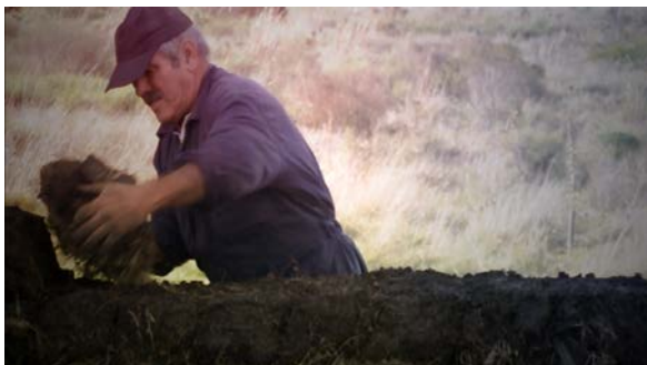
Figura 5 y figura 6: Ejecución del muro y rebajes entre hiladas
