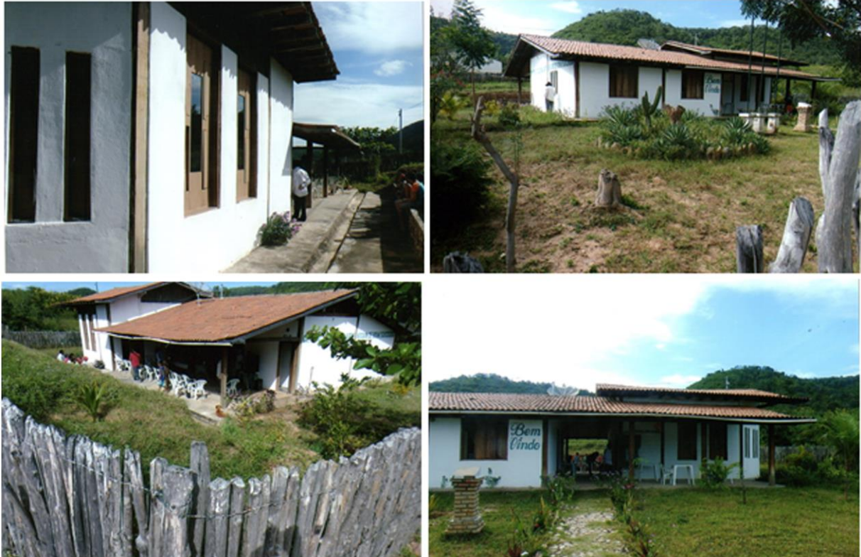
Figura 06 - Obra Pronta do Centro de Cultura Negra da Comunidade de Bom Sucesso
