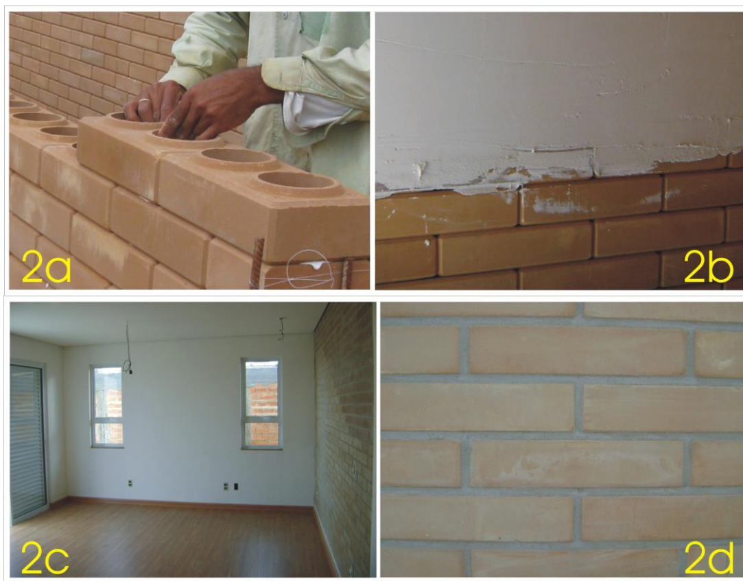
Figura 2 – Aspectos das paredes com tijolos de solo-cimento avaliadas acusticamente
