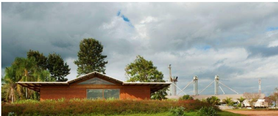
Figura 1 - vista do escritório com silos ao fundo
