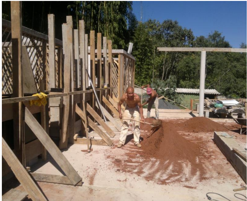
Figura 3 - Taipal de madeira e estabilização do solo.
