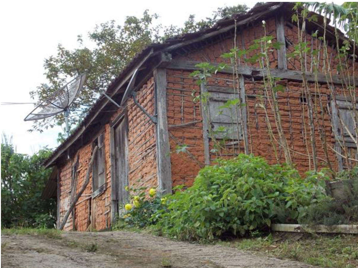
Figura 4 – Nesse exemplo, situado no centro de Lumiar, aparece a técnica construtiva em todos os detalhes descritos acima: a estrutura em enxaimel, as vedações em taipa.
