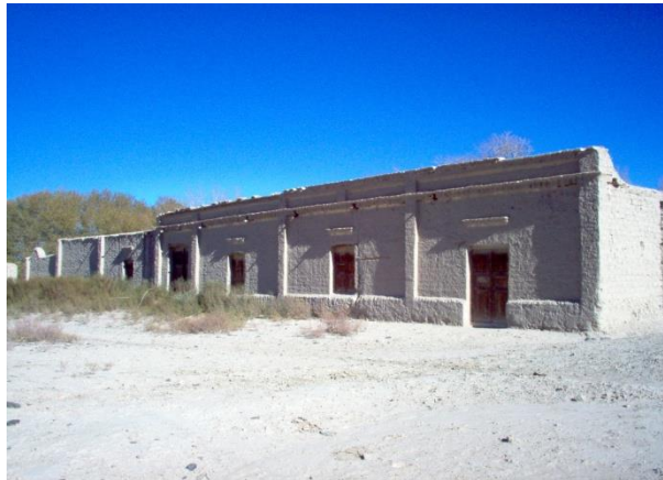
Figura 2 – Casona del principio del siglo XX. Construcción en adobe. Las Flores – Iglesia. San Juan Argentina
