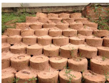
Figura 4 - Muro de contenção em Dezembro de 2013.
