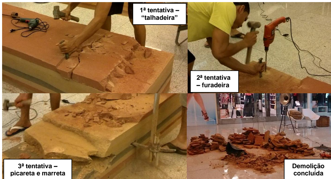
Figuras 10 a 13. Processo de demolição para retirada do banco de taipa de pilão
