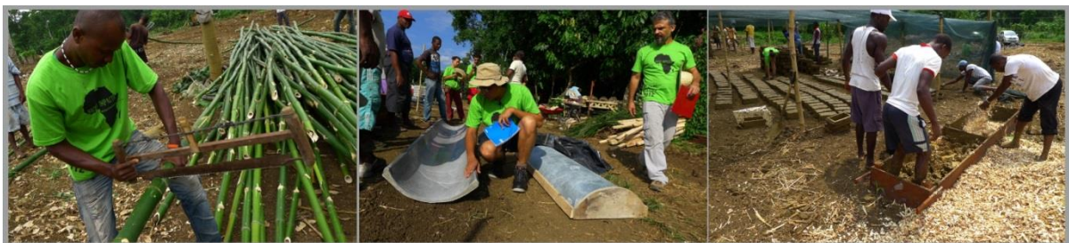
Figura 1 – Processo de Capacitação e Produção de Materiais Alternativos de Construção (bambu, cascaje e adobe).
