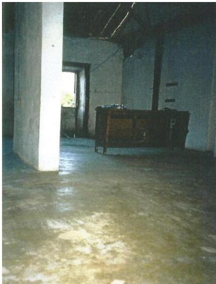
figura 3 - interior antes da intervenção
