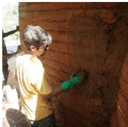
Figura 4 - Execução do reboco
