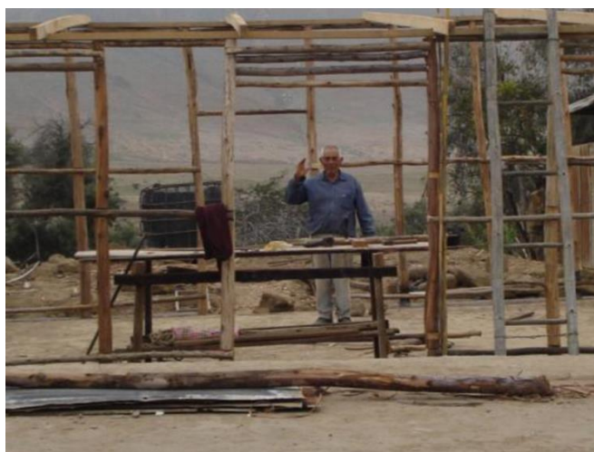
Figura 1 – Don Néstor Castañeda (84 años), construyendo una vivienda de quincha y tierra en el Pueblo de Atiquipa hace 6 años.
