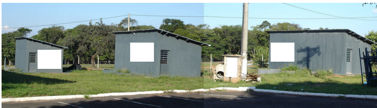
Figura 3. Vista geral da face norte dos três protótipos: adobes (A), blocos de concreto (C) e blocos cerâmicos (B). (adaptado de Faria, 2007)
