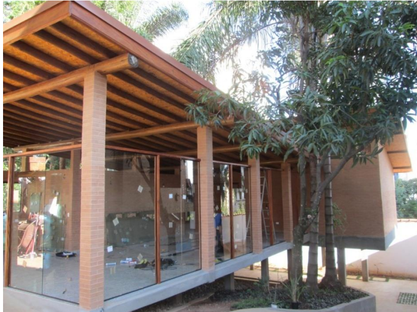
Figura 1 – vista da sala
