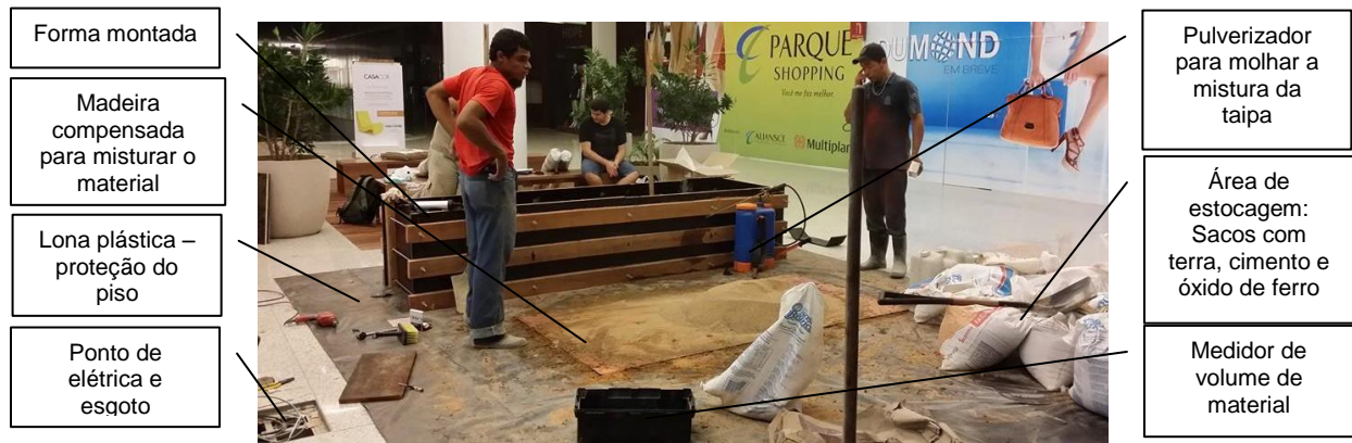
Figura 4. Canteiro de obra
