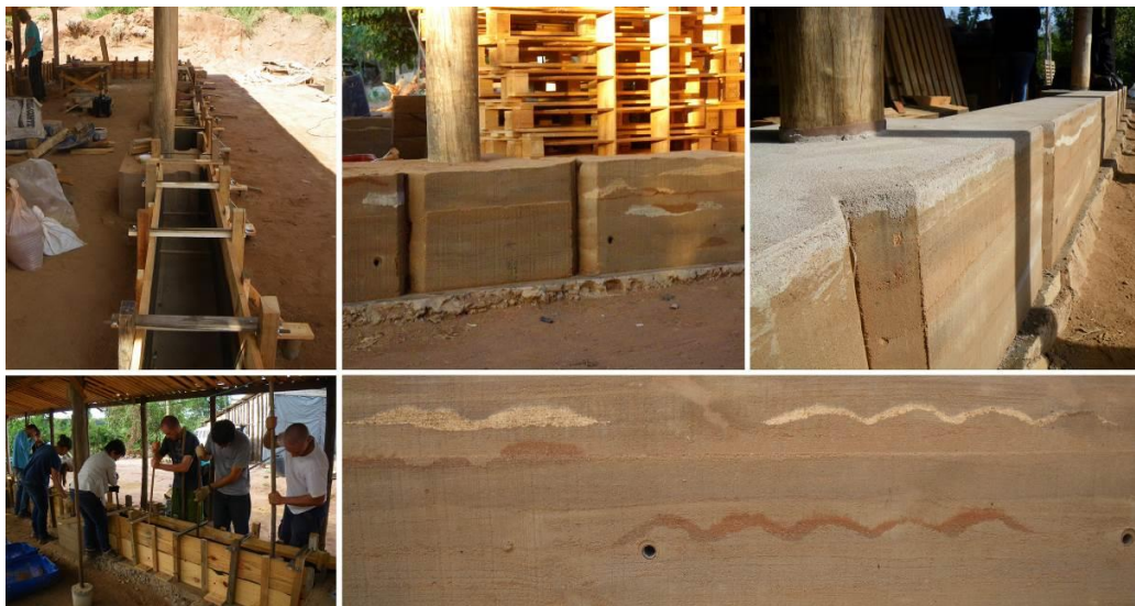
Figura 4 – Taipa de pilão das bases de paredes.
