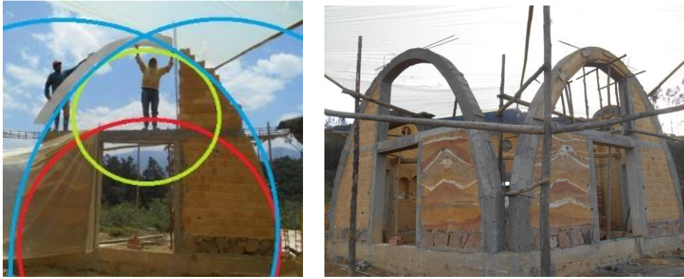
Figura 2 a y 2 b – Trazo de arcos en catenaria / paredes el pentágono (Lucia E. Garzón)
