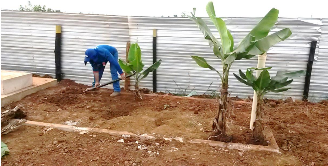
Figura 3 – Construção de bacias de evapotranspiração para o sistema de tratamento de esgoto, uma das tecnologias aceito pela comunidade.
