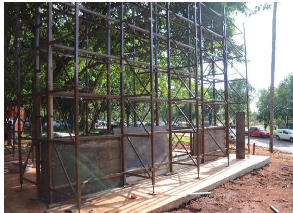
Figura 1. Fôrma – estrutura treliça
