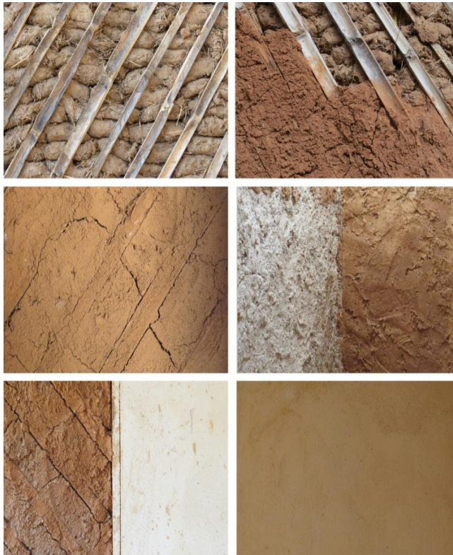
Figura 5 - Processos de execução da taipa de mão.
