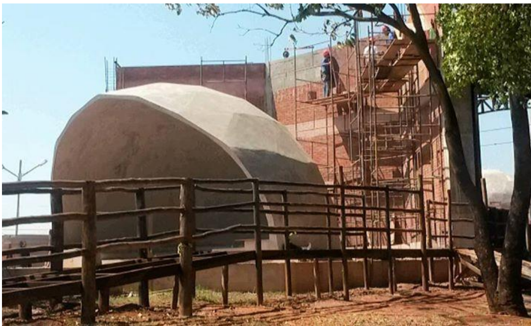
Figura 6 – Execução da Concha Acústica - Estrutura Geodésica e Ferrocimento.
