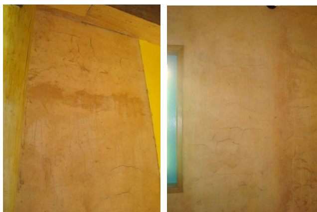
Figura 6 – Parede sudeste bloco administração
