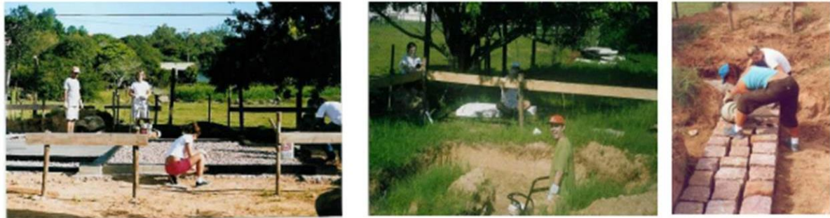
Estudantes “transpirando” durante a construção do Protótipo Casa Alvorada, no Campus da UFRGS (2001).
