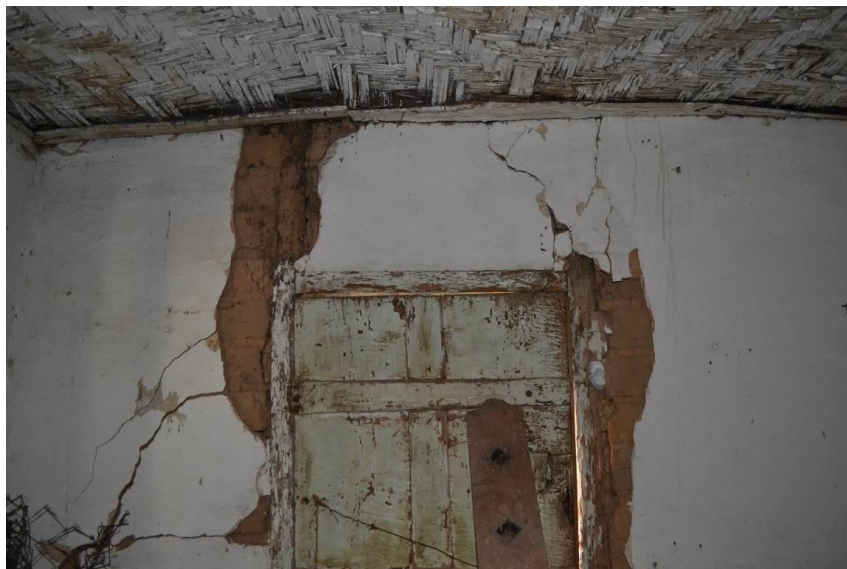
Figura 4 Detalhe do suporte em adobe e argamassa de assentamento em terra evidentes sobre reboco de terra e cal hidráulica. Foto de Fernanda Silva, 2013
