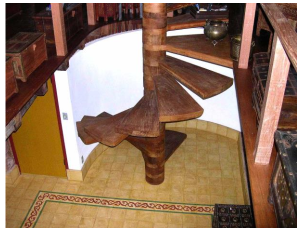
figura 6 - acesso ao porão
