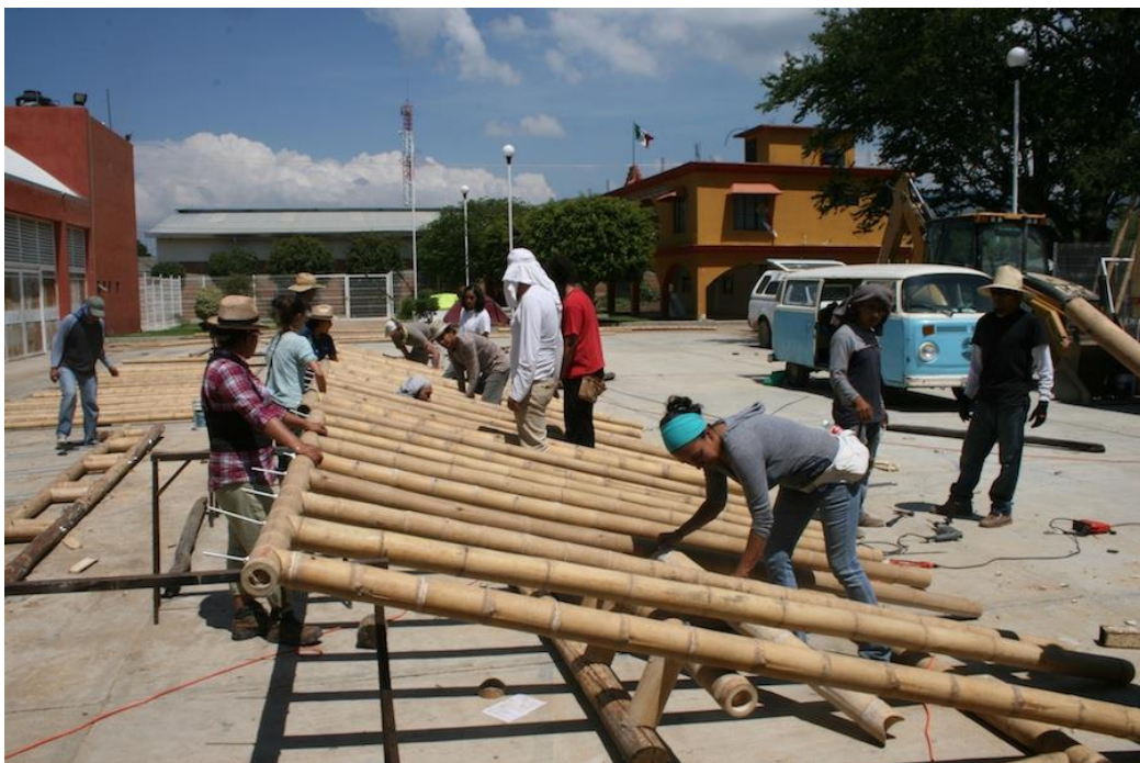
figura 5, el taller de construcción de la estructura de bambú (foto de los autores)
