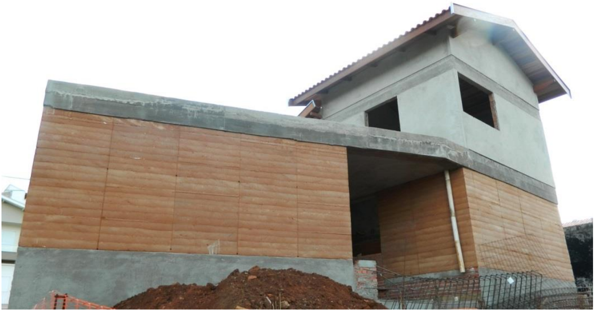
Figura 6 – Imagem da obra.
