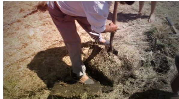
Figura 3 y figura 4: Marcado y corte del terrón
