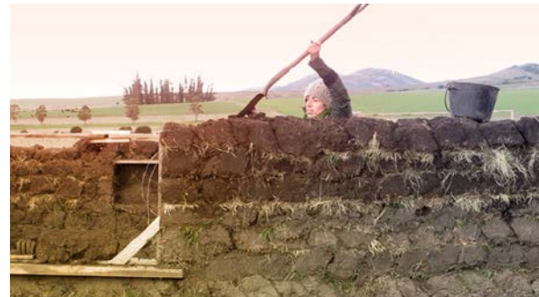
Figura 5 y figura 6: Ejecución del muro y rebajes entre hiladas
