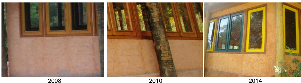
Figura 4 – Evolução das fissuras mapeadas entre 2008 e 2014, na parede Noroeste do restaurante
