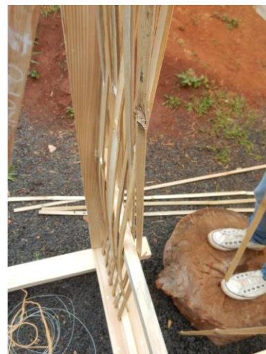
Figura 3: Elaboração do entramado de bambu. Fonte: Acervo Pessoal.
