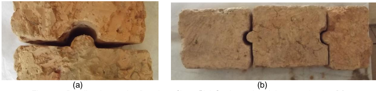
Figura 4. Detalhe do encaixe “macho e fêmea”(a) Conjunto de adobes encaixados (b).
