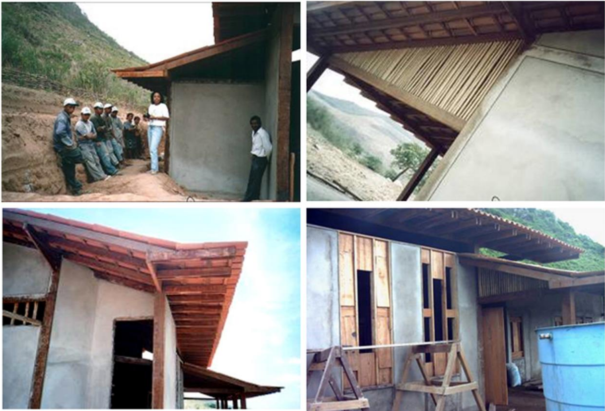
Figura 04 - Obra do Centro de Cultura Negra da Comunidade do Minador
