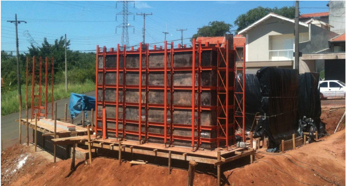
Figura 5 – Imagem da obra – montagem da forma e proteção das paredes prontas.
