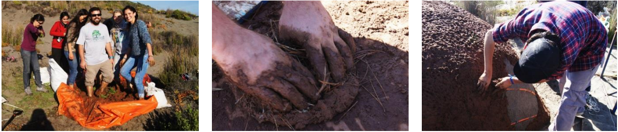
Figura 11 – Preparação da terra, detalhe da confecção da placa e aplicação no molde.
