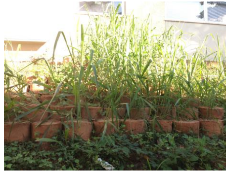
Figura 5 - Muro de contenção em Março de 2014.
