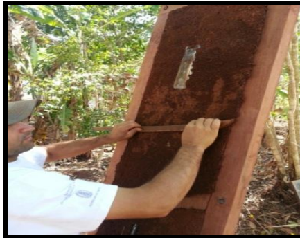
Figura 3 Acabamento de uma placa de taipa leve. IPEC 2013. FOTO: Gustavo Fernandes.
