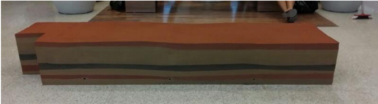
Figura 5. Banco de taipa de pilão finalizado
