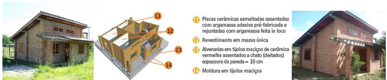
Figura 4. Imagens do Projeto Alvorada em fases distintas da obra, com especificações do sistema construtivo. Fonte: Sattler, 2007b.
