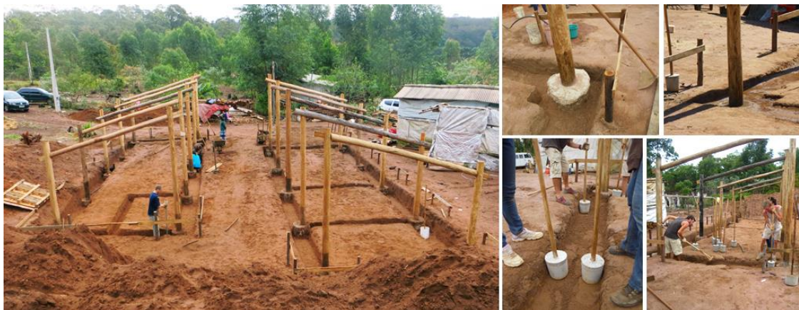
Figura 3 – Realização das escavações e fundações em taipa de pilão.
