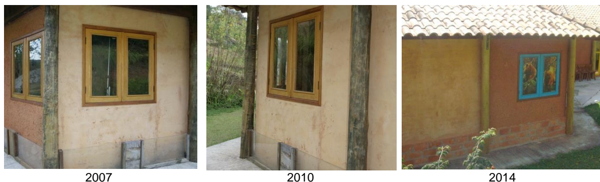
Figura 3 – Proteção da base externa das paredes no bloco da administração.
