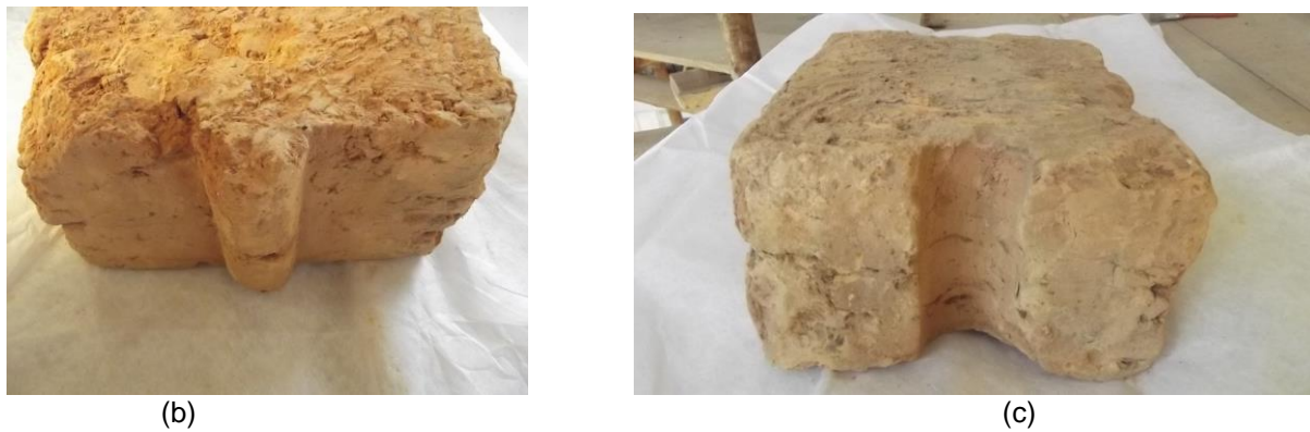
Figura 6. Fiada da alvenaria de adobe (a) Detalhe dos adobes: não existe argamassa nos encaixes (b e c).
