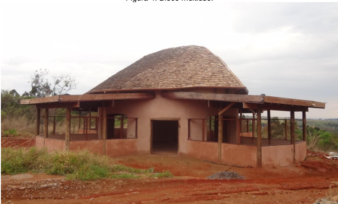
Figura 5. Bloco multiuso em fase de construção.
