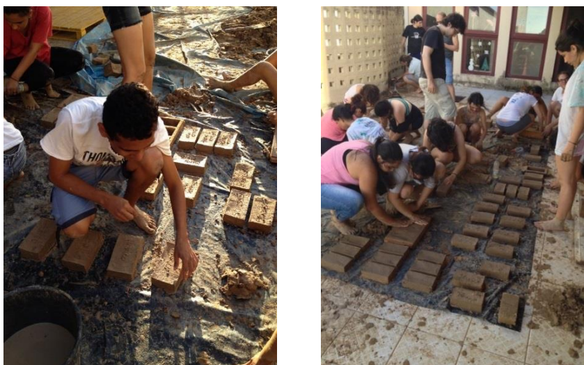
Figura 3 - Canteiro experimental da disciplina de Técnicas Construtivas Tradicionais – Adobe, ano 2013.2
