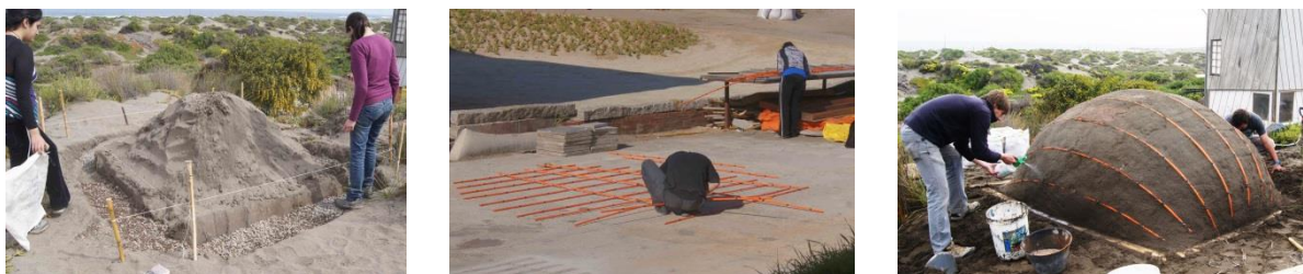
Figura 10 – Nivelamento do terreno, amarração do grid e molde de areia.
