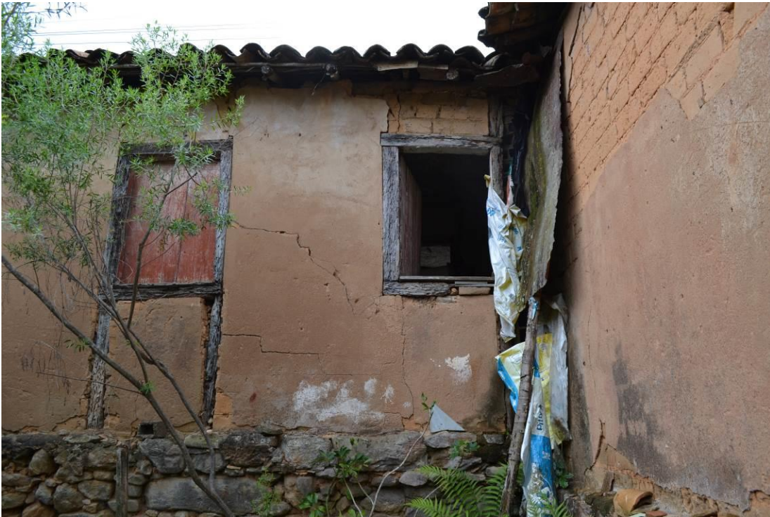
Figura 5 Presença da terra no adobe, tijolo queimado (peitoril), argamassa de assentamento e revestimento. Foto de Fernanda Silva, 2013.
