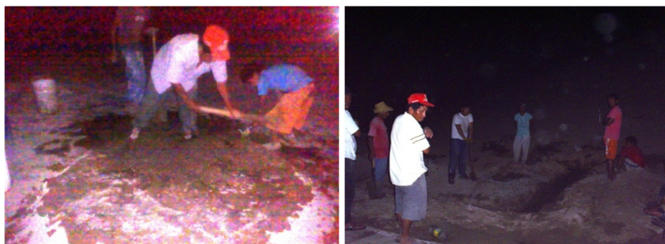
Figuras 9 y 10. Vaciado nocturno de los cimientos (CECOS-BRIGURP 2011)
