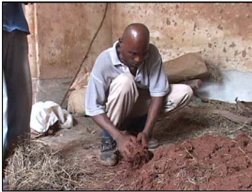
Figura 22. Mezclando la tierra con hierba
