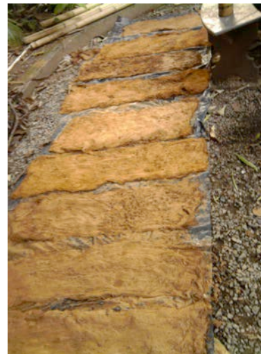
Figura 15 – Lâminas de fibrobarro alinhadas sobre lona plástica (Acervo do LILD, 2011)
