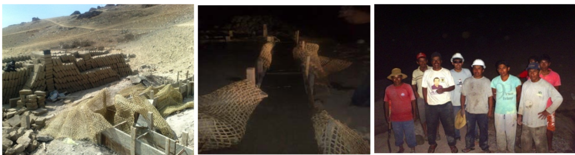
Figuras 15, 16 y 17. Armado del encofrado para sobrecimientos con mallas de junco (CECOS-BRIGURP 2011)
