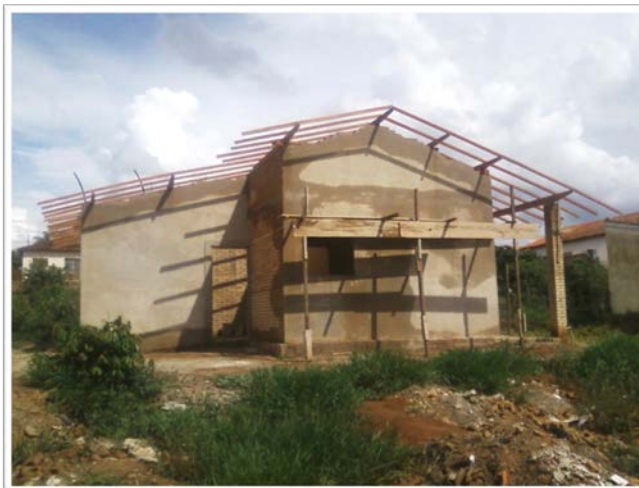
Figura 5. Obras já adiantadas: paredes rebocadas – melhor aceitação por parte dos moradores vizinhos. (do autor, 2011)
