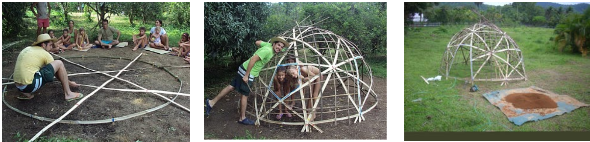
Figuras 5, 6 e 7. Estruturas primária e secundária de ripas de bambu (Acervo do LILD)
