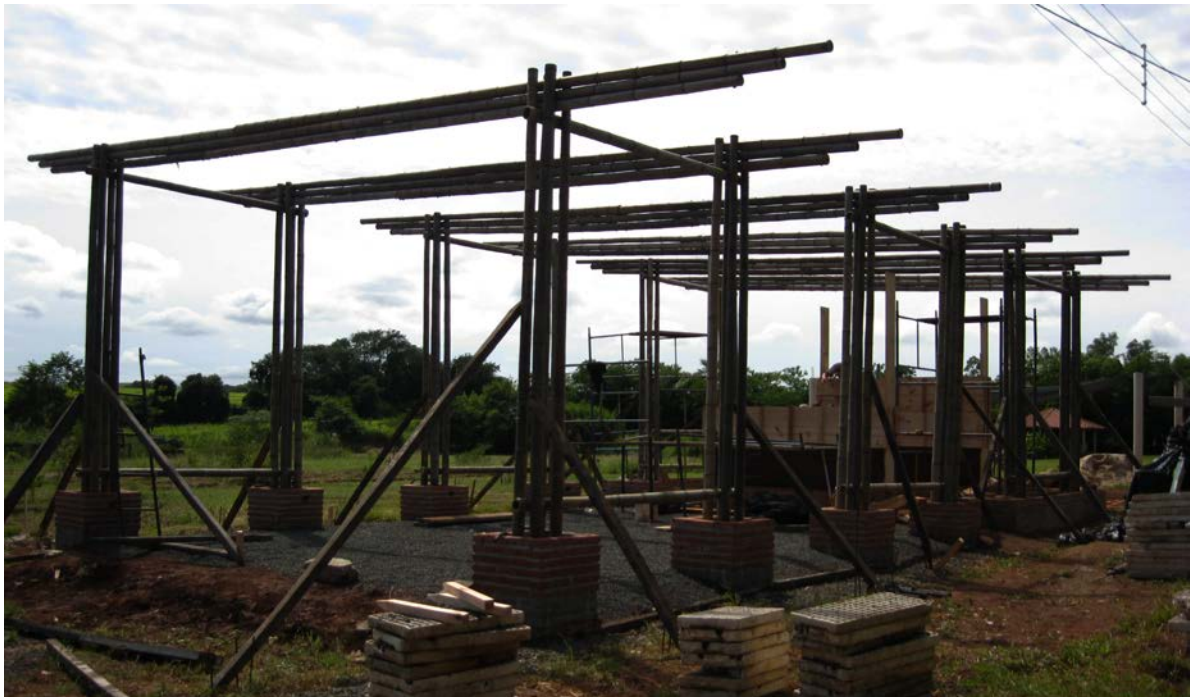
Figura 3. Estrutura de bambu, antes da colocação dos tirantes (Baglioni E., fevereiro 2011).
