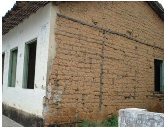
Figura 2. Casa em taipa pau-a-pique. Planta em meia morada com porta e duas janelas (frontal) e janela lateral – Tatuamunha. (Acervo Inventário, 2006)
