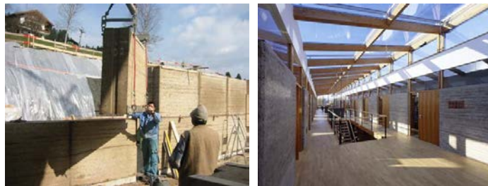
Figuras 5 y 6. Construcción prefabricada en tapia. Imprenta Gugler. Melk, Austria. Fuente: Martin Rauch
