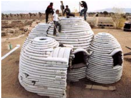
Figura 4. Construção em superadobe. Disponível em http://www.busyboo.com/2008/10/13/superadobe-earth-home/
