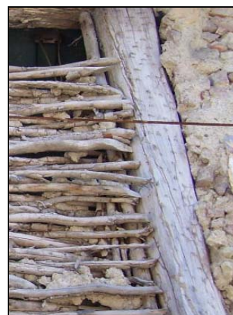
Figura 9. Unión horcón-encestado
