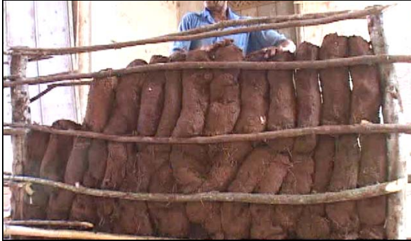
Figura 20. Estructura del muro
