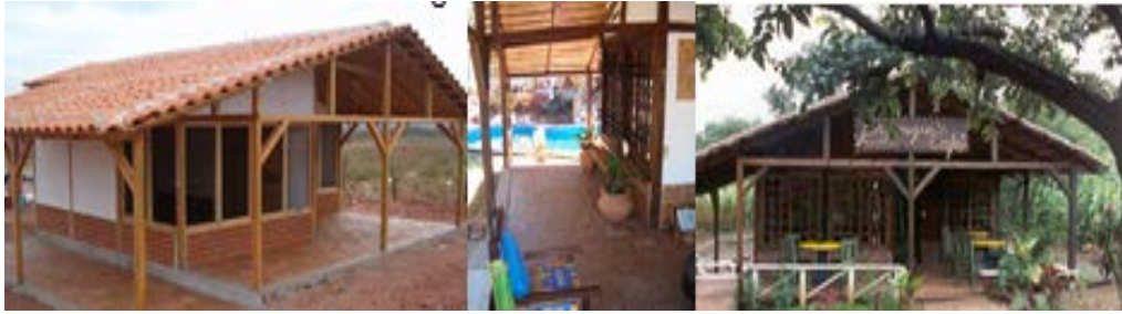
Figura 16c. Oficinas y cafetería
