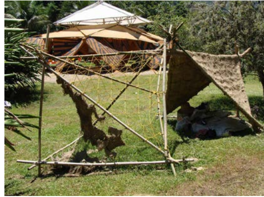
Figura 20 – Processamento de barro para confecção de lâminas de fibrobarro (Acervo LILD) . Figura 21 – Estrutura ampliada e casca de fibrobarro. (Acervo LILD)
