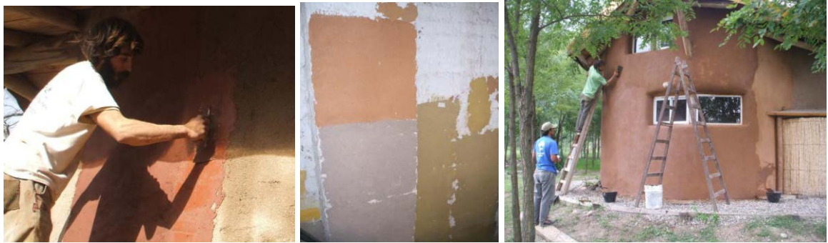
Figura 6. Prueba de los revoques deshidratados y coloreados en una vivienda prototipo
