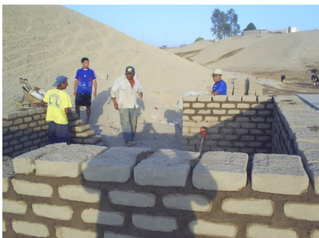
Figura 18. Levantamiento de muros de adobe (CECOS-BRIGURP 2011)
