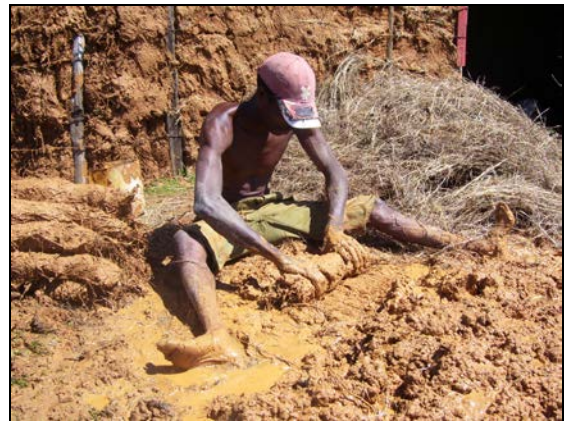
Figura 32. Conformando el relleno
