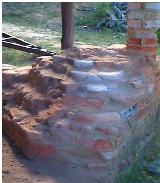
Figura 5. Alvenaria de tijolo de barro, maciço, 'batido' em formatos: retangulares, arredondados e cuneiformes (embasamento e coluna) de terraço lateral, excessivamente desgastada por impregnação de umidade. – Tatuamunha (Acervo Inventário, 2007)
