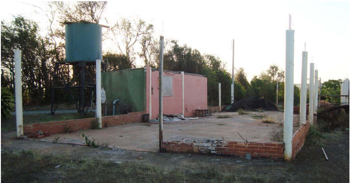
Figura 1. Antigo galpão cujo teto foi demolido por uma tempestade (Munhoz, setembro 2010)
