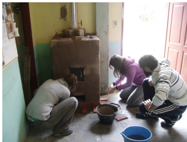
Figura 1: Construcción de estufa de adobes con pasantes de grado en centro vecinal, Bancalari, Buenos Aires, 2011. (Crédito: R. Rotondaro)
