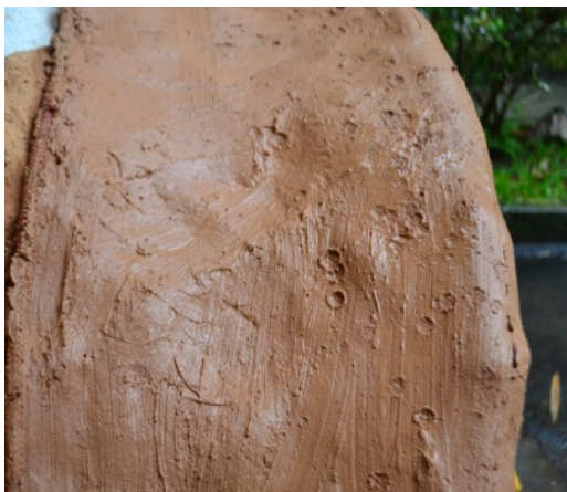
Figura 17 – Barro em estado plástico devido à ação da chuva incidindo diretamente (Acervo LILD, 2011)
