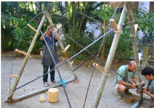
Figura 10 – Primeiro módulo da estrutura metálica de apoio (Acervo do LILD, 2011)
