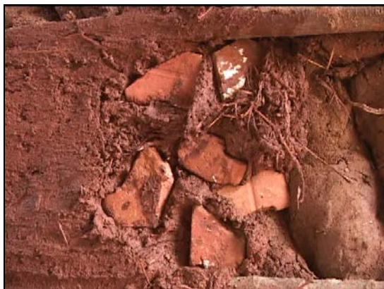
Figura 24. Relleno del muro
