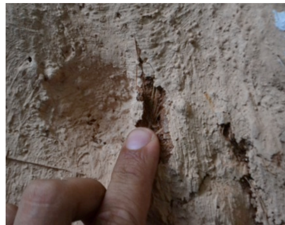
Figura 18 – Dano causado devido à ação da chuva. Fibras expostas sem a presença do barro: sinal de enfraquecimento (Acervo LILD, 2011)
