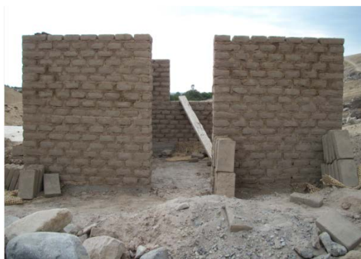
Figura 19. Vista final del módulo de adobe antes de colocar las mallas de refuerzo (CECOS-BRIGURP 2011)
