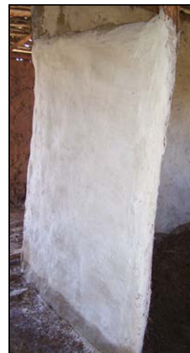
Figura 34. Revestimiento con cal
