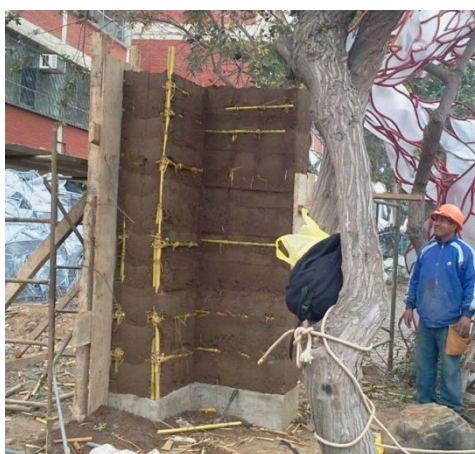
Figura 10. Muro de tapia apisonada en T previo a ser sometido a la prueba de impactos horizontales (CECOS-BRIGURP 2011)
