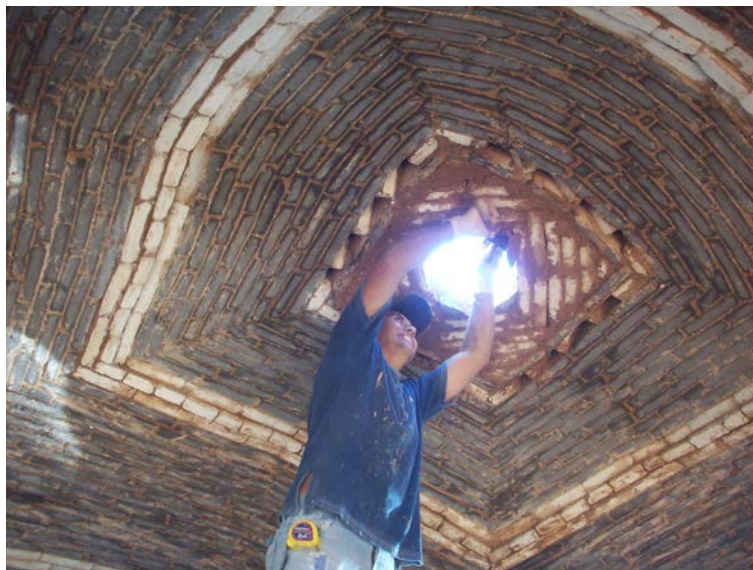
Figura 1. Cierre de bóveda oficina Exaltar Construcciones, Paraguay (Aguirre, 2011)
