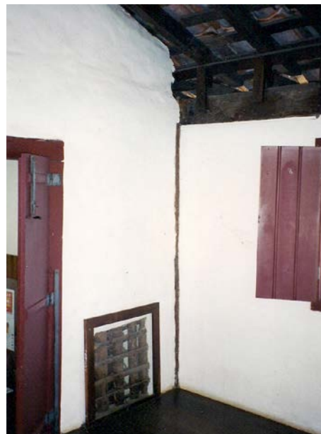
Figura 5. Detalhe da trama de madeira em parede interna (Wilza Lopes, 2002)
