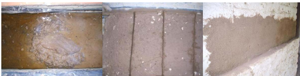
Figura 4. Preparado, acopio y muro rebocado
