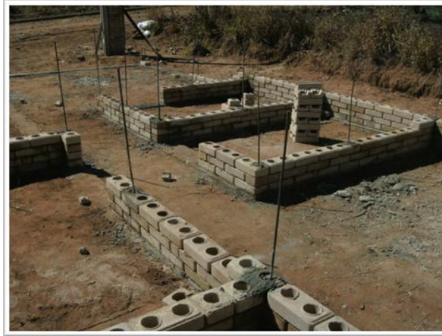
Figura 4. Início das obras: primeiras fiadas assentadas com tijolos de solo-cimento, em Casa Branca, SP. (do autor, 2010)
