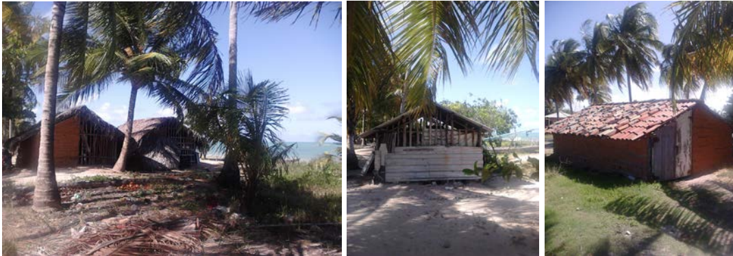
Figura 6. Imagens de palhoças, abrigos de barcos de pesca, situadas na praia do Patacho (Povoado de Tatuamunha, Alagoas), mostrando, em sequência, uma construção tradicional de taipa com cobertura de palha de coqueiro; com estrutura de madeira vedada com placas metálicas e outra coberta com telha cerâmica. Fonte: acervo do Grupo de Pesquisa Estudos da Paisagem
