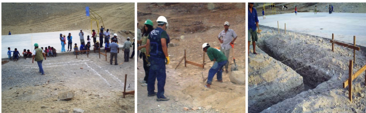
Figuras 6, 7 y 8. Proceso de trazado y excavación de los cimientos (CECOS-BRIGURP 2011)
