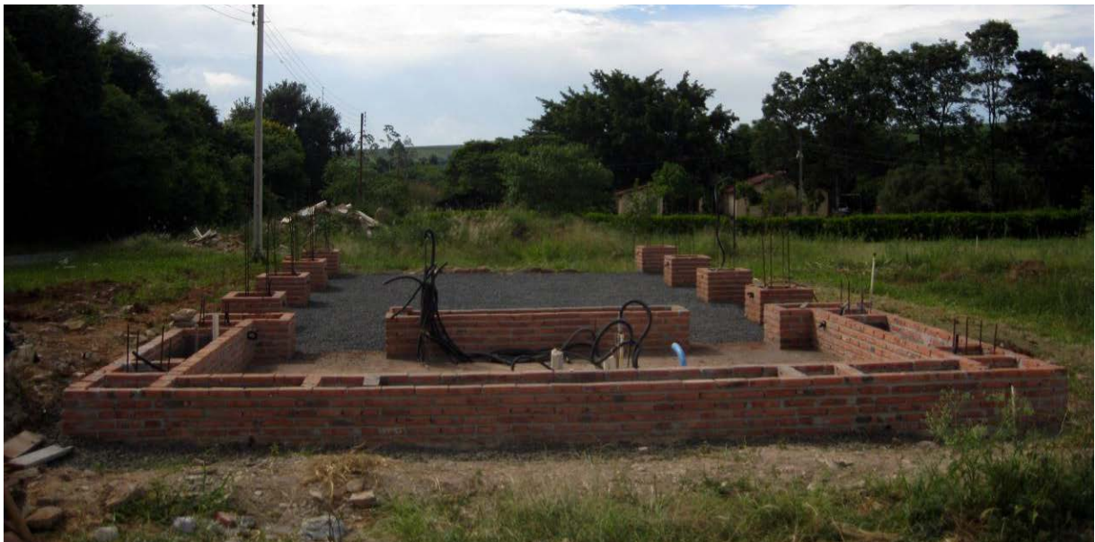
Figura 2. Vista preliminar da obra (Baglioni, fevereiro 2011)
