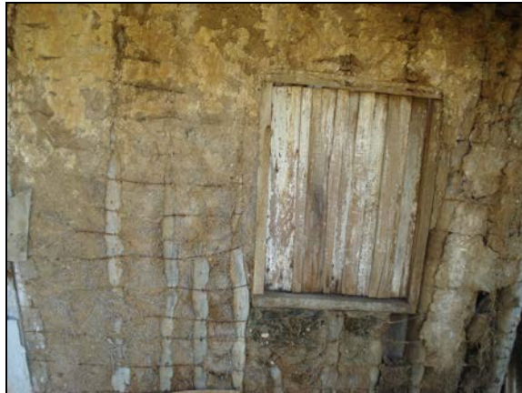
Figura 26. Fachada de la solución del tipo constructivo 3
