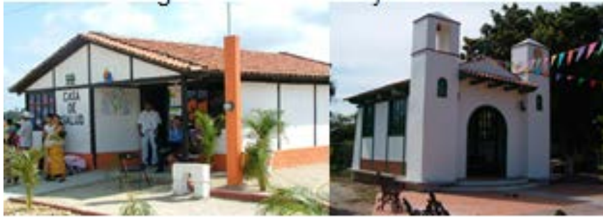
Figura 16d. Casa de salud y capilla con técnica mixta
