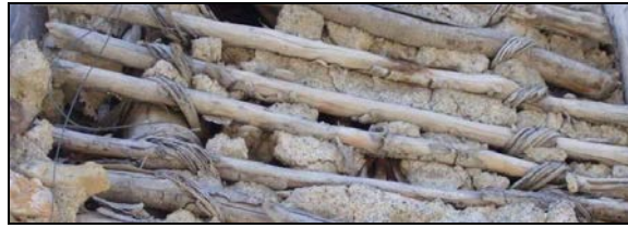
Figura 11. Unión de los cujes
