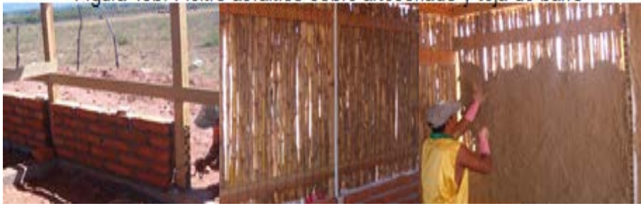
Figura 14. Rodapié de ladrillo mostrando las corcholatas en polín de madera y en el área del rodapié, ensetado de cañamaíz cubierto con malla gallinera y embarro
