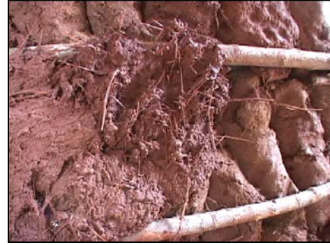
Figura 21. Relleno del muro
