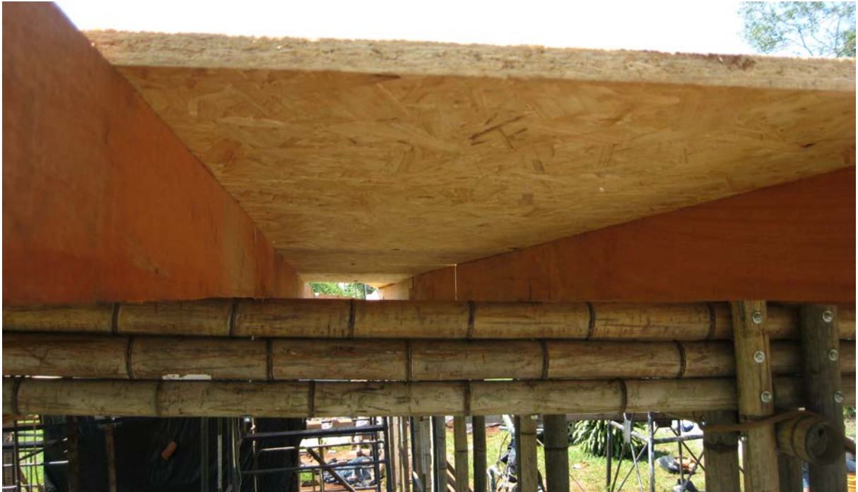
Figura 6. Parte da estrutura de cobertura realizada no Curso (Baglioni, fevereiro 2011)
