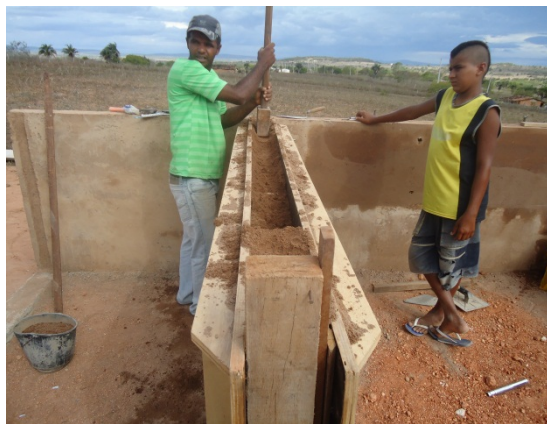
Figura 2 – Tecnologia para a produção das paredes
