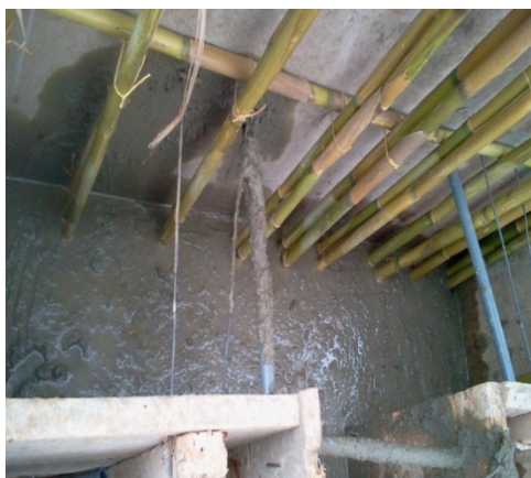
Figura 9. Colocación de las cañas ( Arundo donax ) en el muro de tapia (CECOS-BRIGURP 2011)
