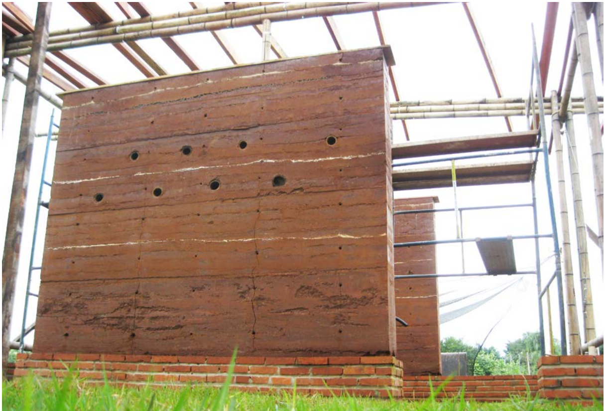
Figura 4. As duas paredes de taipa de pilão (Baglioni, março 2011).
