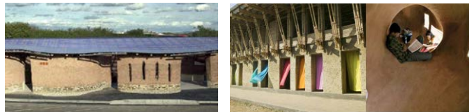
Figura 11. Pabellón de Servicios del Eden Project, Cornwall, Reino Unido. Fuente: Abey Smallcombe. Figura 12. Handmade School en Rudrapur, India. Fuente: BASE-habitat
