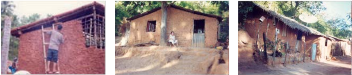
Figura 4. Construção de casa de taipa em Pontal do Coruripe. (Fonte: acervo do Grupo de Pesquisa Estudos da Paisagem)
