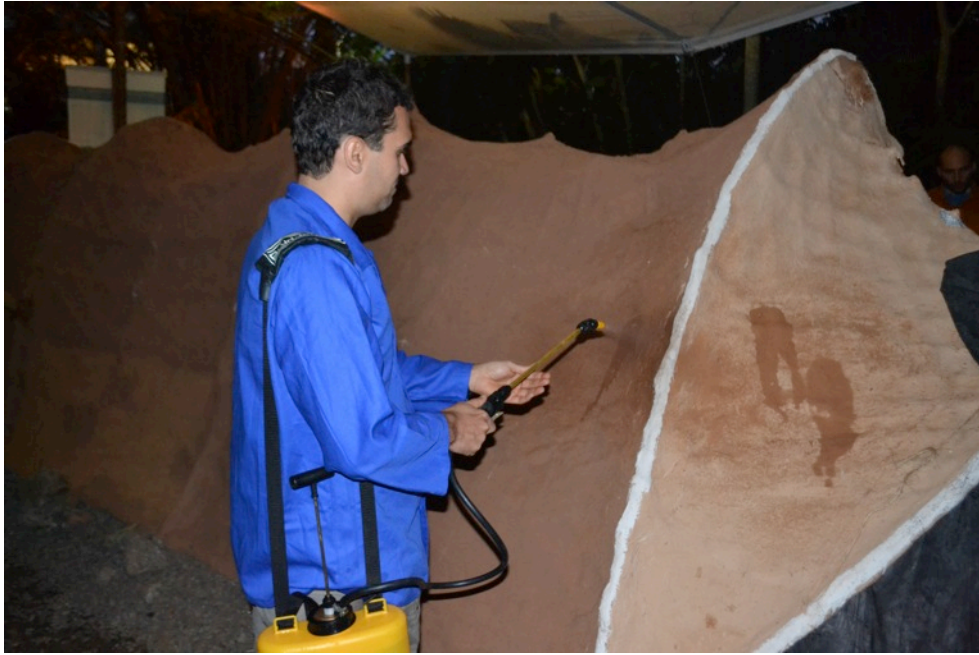
Figura 13 – Spray de água feita com pulverizador para hidratar homogeneamente (Acervo do LILD, 2011)
