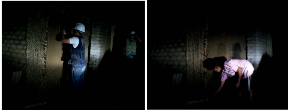
Figuras 20 y 21. Colocación de la malla en el muro y tarrajeo del mismo (CECOS-BRIGURP 2011)
