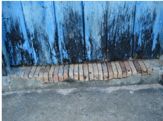
Figura 1. Casa em meia morada, construída em taipa pau-a-pique; soleira da porta em tijolo de barro, maciço 'batido', assentado "em pé". - Porto de Pedras (Acervo Inventário, 2006)
