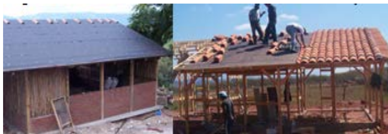
Figura 13b. Fieltro asfáltico sobre artesanado y teja de barro
