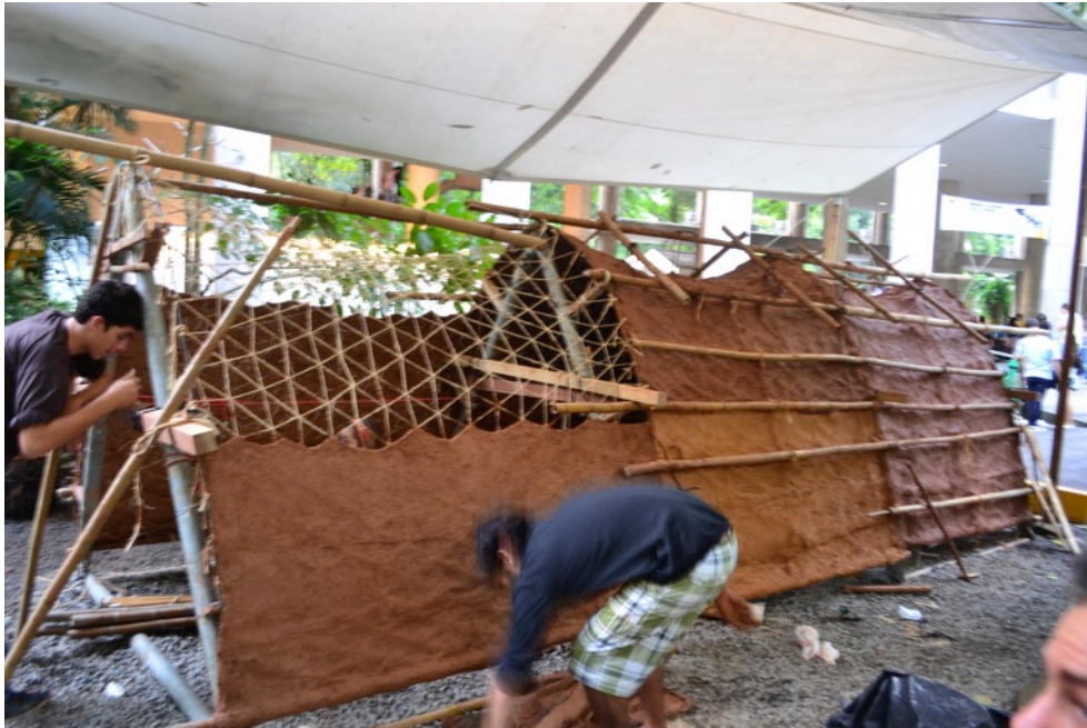
Figura 12 – Hastes de bambu utilizadas como estrutura auxiliar da trama de montagem (Acervo do LILD, 2011)
