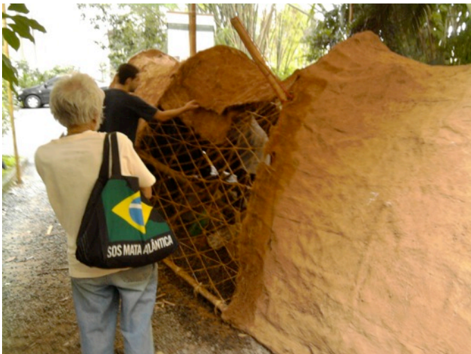
Figura 14 – Trama sem fibrobarro durante a desmontagem (Acervo do LILD, 2011)
