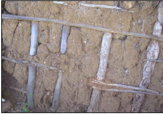
Figura 29. Entramado del muro
