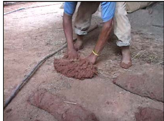
Figura 23. Conformando los rolos
