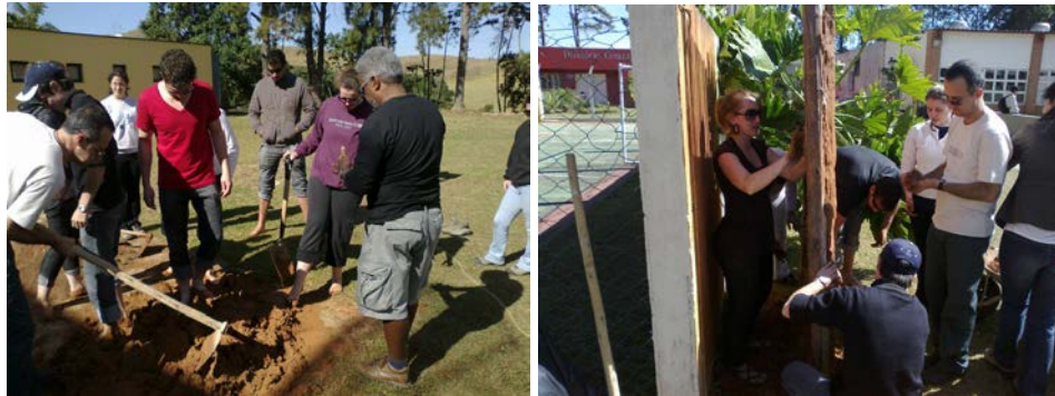
Figuras 1 e 2. Preparo da mistura para confecção de adobes; preenchimento de painel de taipa-de-mão (Créditos: Junqueira; Miranda, 2011)
