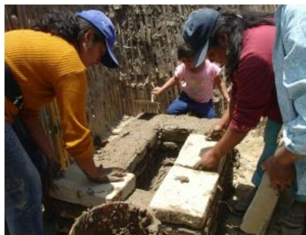
Figura 2. Casas sismoresistentes de quincha mejorada-Huarangal (www).
