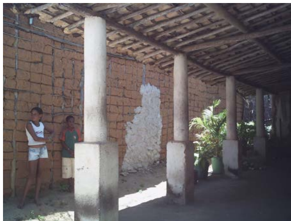
Figura 3. Colunas de alpendre lateral em alvenaria de tijolos batidos: cuneiformes – fustes circulares; retangulares - bases elevadas. Ao fundo, parede em taipa de casa vizinha, sem reboco. - Porto de Pedras (Acervo Inventário 2006)
