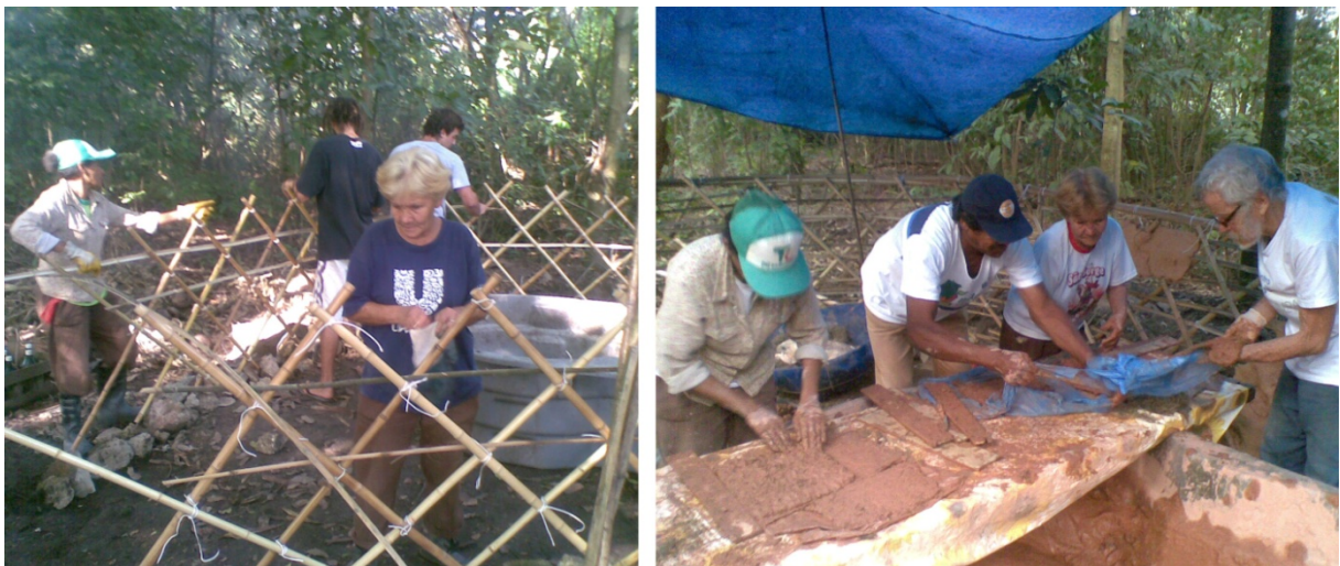
Figura 4 – Construção da treliça e ensino da técnica de fibrobarro
