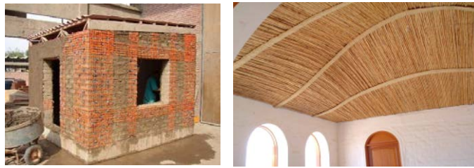
Figura 9. Módulo reforzado para ensayos de simulación sísmica. Lima, Perú. Fuente: Marcial Blondet Figura 10. Techo de Domocaña en Vivienda de Humay. Fuente: Raquel Barrionuevo
