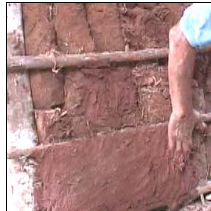
Figura 25. Acabado del muro
