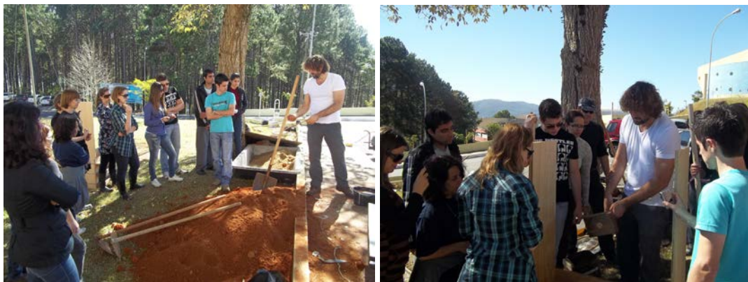
Figuras 3 e 4. O processo de preparação da terra e a montagem das formas para a execução dos bancos de taipa-de-pilão (Crédito: Parisi, 2011)
