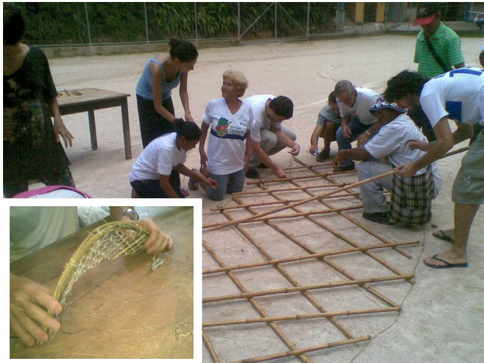
Figura 2 – O grupo formado pelos trabalhadores do Anil, alunos de graduação em design e pesquisadores do LILD montam a treliça, antes explicada em forma de miniatura (detalhe)
