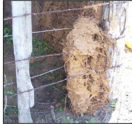
Figura 30. Uso de alambres en la estructura
