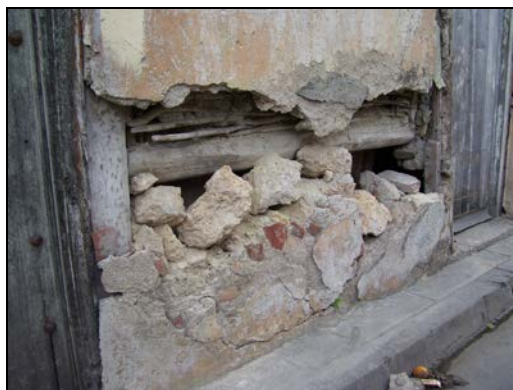
Figura 8. Base del muro
