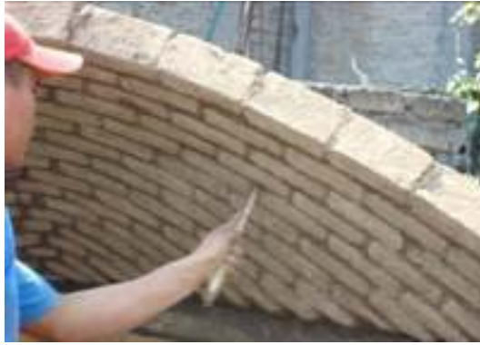
Proceso de limpieza de las esquinas de la bóveda
