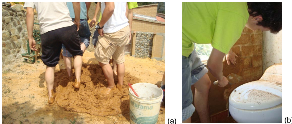
Figura 4. (a) Pisando con los pies descalzos la mezcla y (b) aplicación del pañete en el baño
