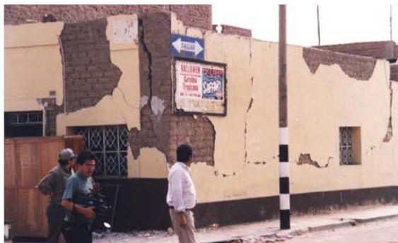
Figura 1. Fallas típicas en viviendas de adobe por acción sísmica perpendicular al plano de los muros: desgarramiento vertical en las esquinas y grieta vertical por flexión en la zona central del muro (Fuente: CTAR/COPASA, 2002)
