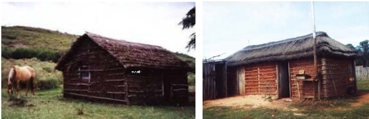
Figura 2. Técnica de pau-a-pique utilizada em habitações rurais no Uruguai, em Tacuarembó e Rivera , respectivamente. Fonte: Etchebarne et al. (2006).
