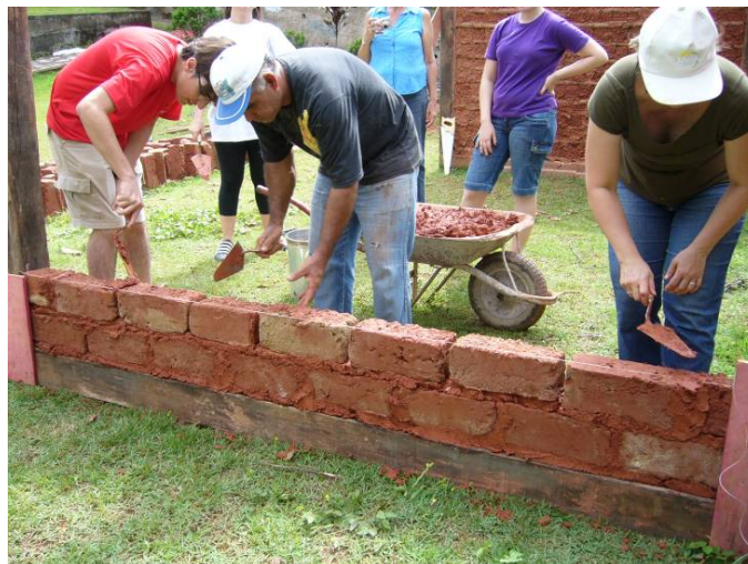
Figura 2. Execução da parede de adobes no segundo módulo do Curso de Capacitação em Arquitetura de Terra no município de Santa Luzia/MG (crédito: Quintão, 2009)
