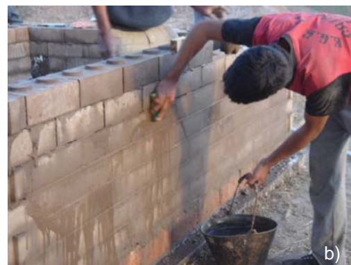
a) alvenaria de bloco Mattone com argamassa fluida; b) limpeza da superfície
