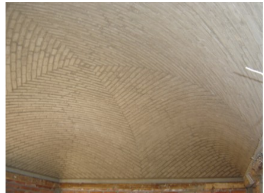
Cierre en forma de espiral e interior de la bóveda terminada
