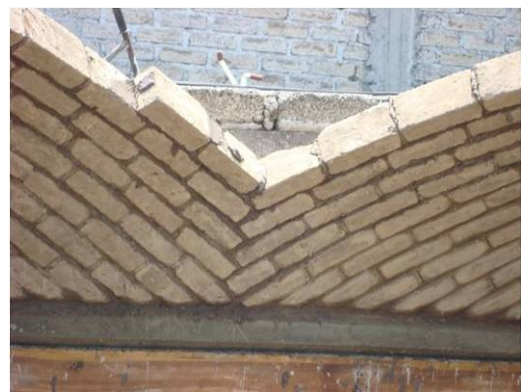
Termino de pechinas y cuatraper de BTC para iniciar cerramiento de bóveda
