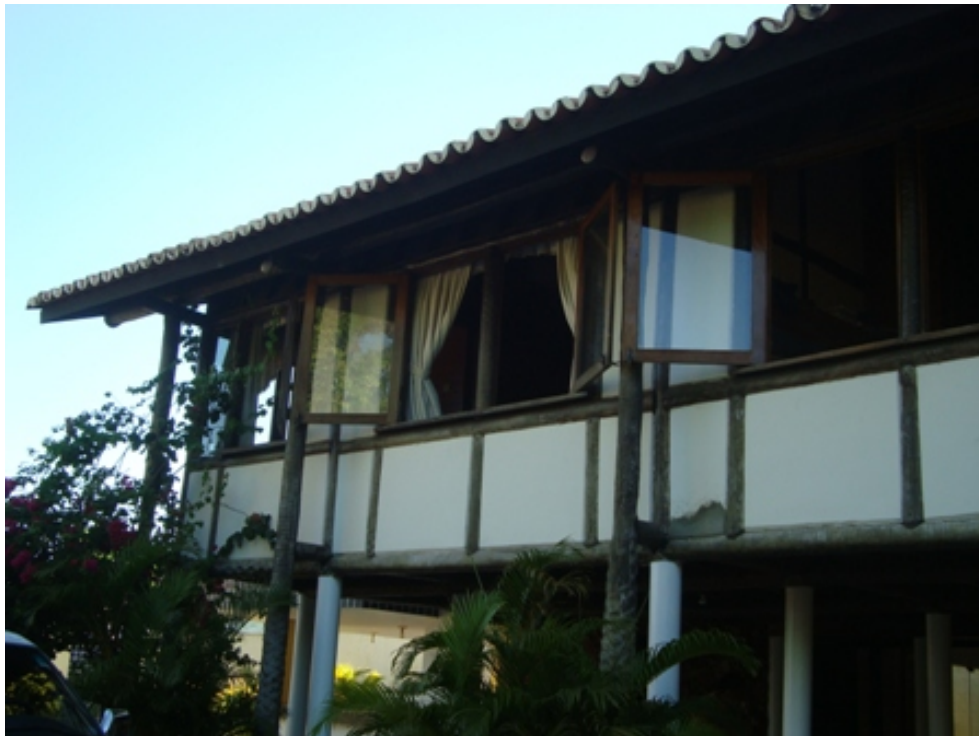
Figura 6. Fachada principal, nos dias atuais (Foto Thais Carvalho, 2009)
