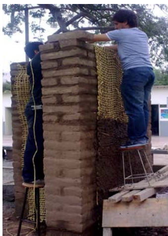
Figura 5. Colocación de la malla
