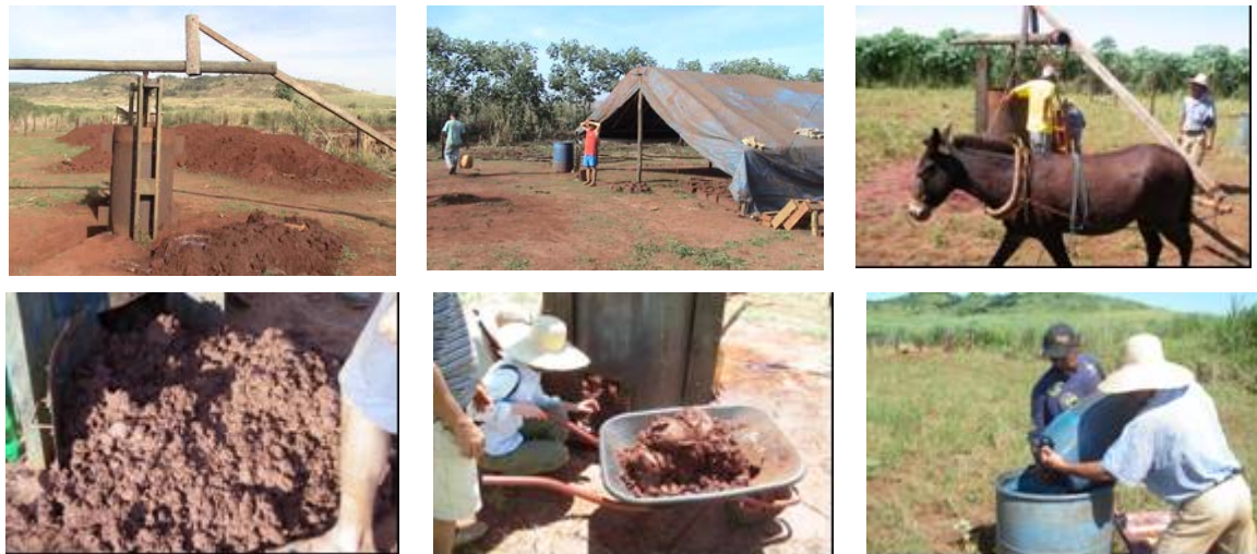
Figura 7. Pipa em funcionamento e barracão para secagem e armazenamento dos adobes
