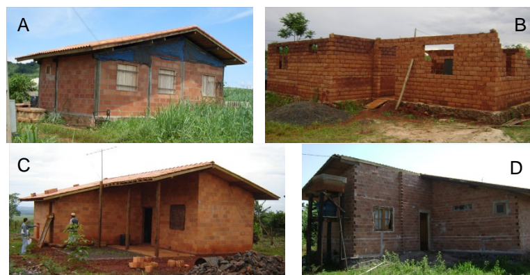
Figura 5. Tipologias do Grupo Alternativo: A- pilar-viga com vedação em tijolo cerâmico; B- adobe; C- cerâmico estrutural; D- tijolo baiano com função estrutural (Fonte: HABIS, 2008)
