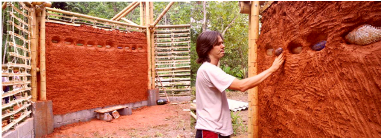
Figura 3. Painel ibiosfera – Estrutura em bambu e barro (taipa de mão)
