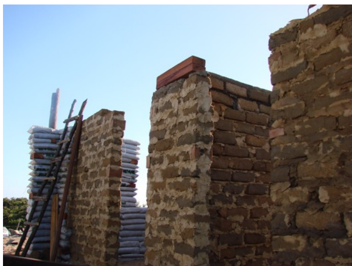
Figura 3. Paredes internas construídas com adobe
