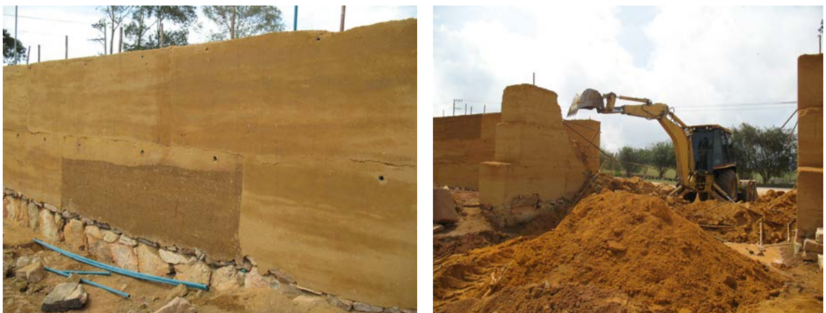
Figura 3. Tumbando las tapias mal construidas antes de que se cayeran solas
