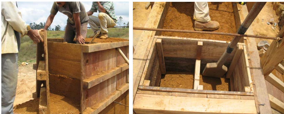
Figura 5. Trabas dentro del tapial para reforzar su estabilidad
