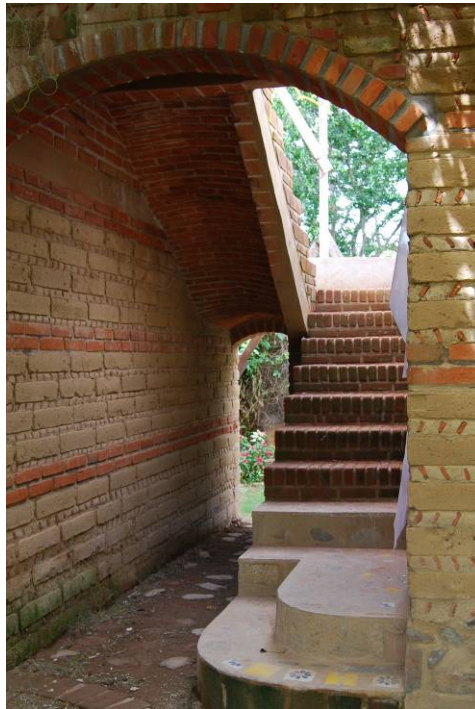
Figura 2. Bóvedas de cuña como rampa de escalera en una casa de adobe. Jantetelco, México. (Ramón Aguirre y Joel Torres).
