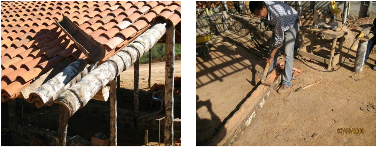
Figura 2. Tejas de palma macana autoportantes
