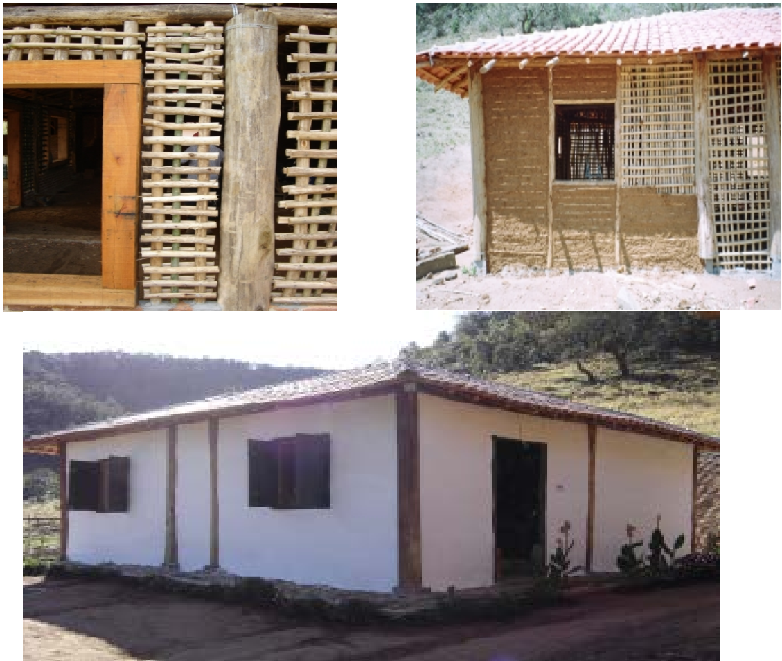
Figura 4. Painel bambu a pique-estrutura em bambu e barro. Fonte: http://bambuapique.com/index11.html
