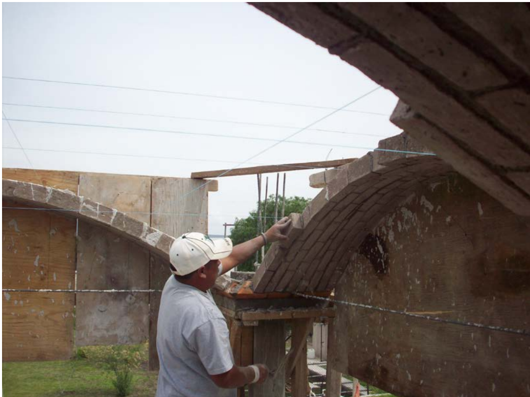
Figura 4. Proceso de ejecución de una bóveda hecha con ladrillos de tierra cruda. Universidad Autónoma de Querétaro, México. (Ramón Aguirre)
