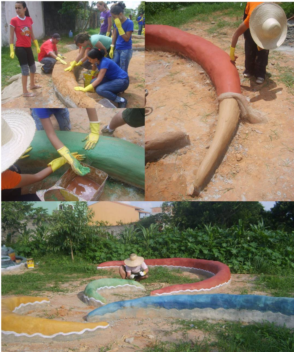
Figura 3. Acima: o trabalhado em oficina de calfitice com estudantes do ensino médio de uma das escolas do bairro. Abaixo: o acabamento: resina, argamassa e uma faixa de tinta para deixar os bancos protegidos e bem acabados
