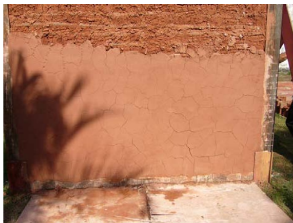
Figura 4. Vista da superfície onde foi aplicada uma argamassa de reboco com traço 1:2:1 (cal: areia:terra). Observam-se trincas generalizadas evidenciando a grande retração da argamassa. Curso de Capacitação em Arquitetura de Terra no município de Santa Luzia/MG (crédito: Quintão, 2009)
