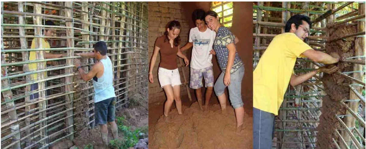
Figura 3 – Preenchimento do entramado e amassamento do barro com os pés (crédito: Paiva, 2009)
