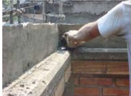
Colocación del primer BTC
