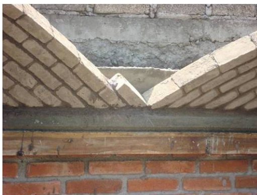
Termino de pechinas y cuatraper de BTC para iniciar cerramiento de bóveda
