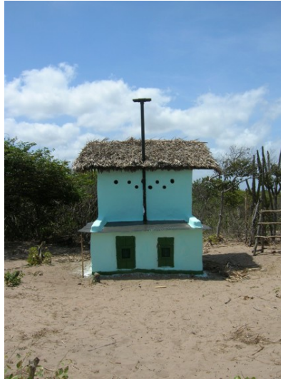
Figura 6. O sanitário seco finalizado
