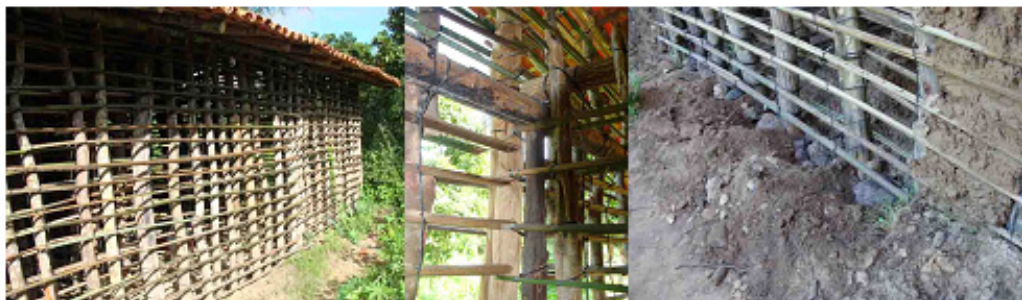
Figura 1 – Entramado na área externa, entramado na área interna e fundação das varas do entramado (crédito: Paiva, 2009)
