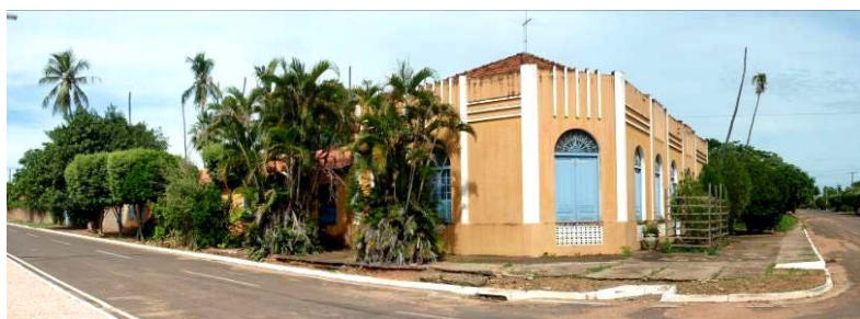
(a) Fachada Sudeste, 2009 (créditos: Zanoni)
