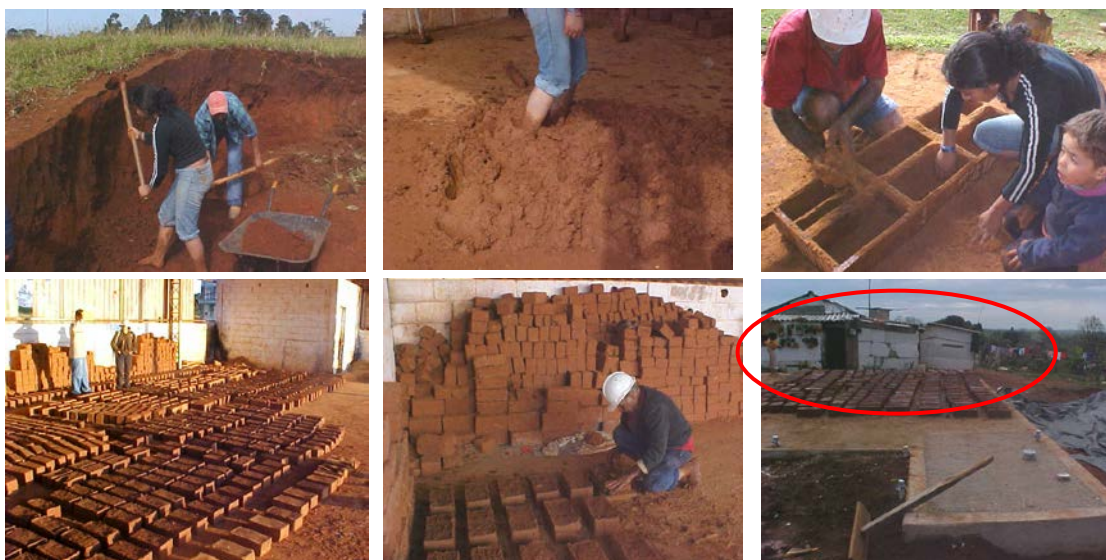
Figura 2. Imagens da seqüência de produção dos adobes, observando-se no destaque a precariedade da situação habitacional da família, anterior à construção da nova casa
