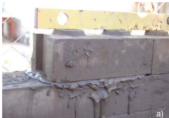
a) alvenaria de bloco Mattone com argamassa fluida; b) limpeza da superfície
