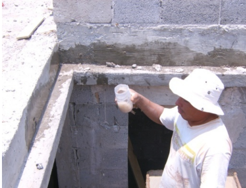
Proceso de humedecer el área de contacto del BTC
