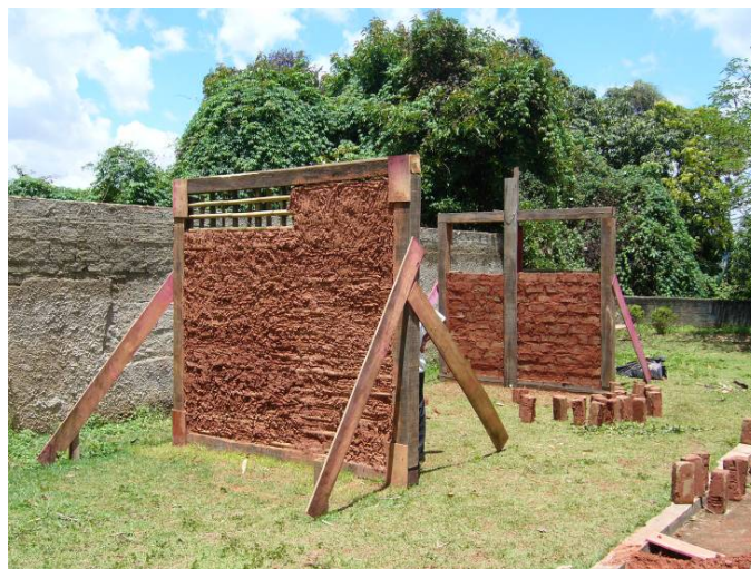
Figura 3. Vista das paredes de pau-a-pique e adobes no canteiro de obras do Curso de Capacitação em Arquitetura de Terra no município de Santa Luzia/MG (crédito: Quintão, 2009)
