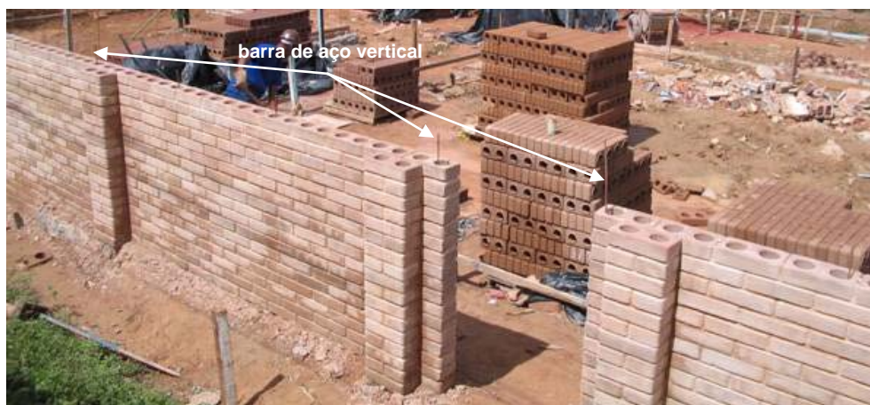
Alvenaria de BTC com furos e junta de argamassa
