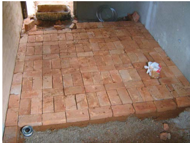
Figura 3. Contrapiso do banheiro
