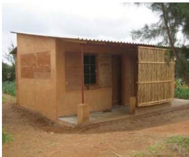
Casa de taipa de mão com reboco – Angola
