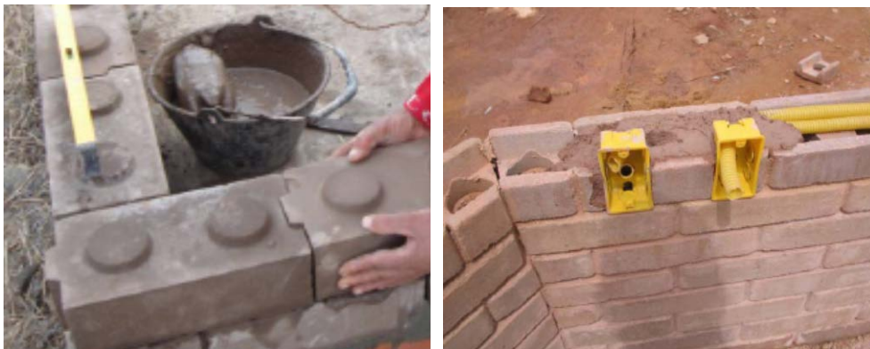
Figura 5. Assentamento de tijolos e blocos BTC, acabamento aparente
