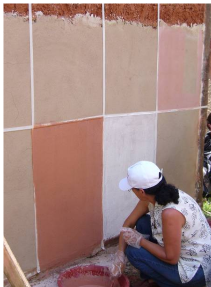
Figura 5. Execução da pintura em terra sobre reboco de cal e areia (1:3) no segundo módulo do Curso de Capacitação em Arquitetura de Terra no município de Santa Luzia/MG (crédito: Quintão, 2009)
