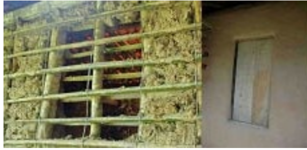
Figura 4 – Colocação das janelas (crédito: Paiva, 2009)
