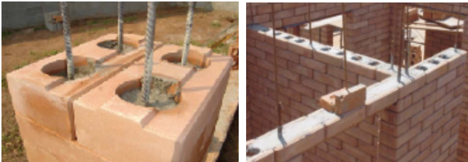
Figura 4. Colunas e paredes de BTC vazados, já com armações internas e concretagem das fundações
