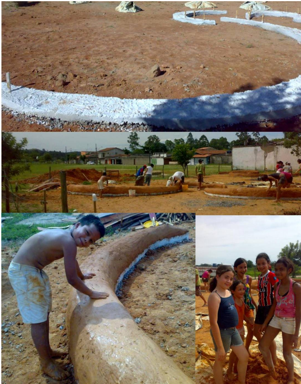
Figura 2. Acima: fundações executadas em concreto armado. Abaixo: imagens das crianças experimentando modelar bancos e canteiros com o COB nas oficinas
