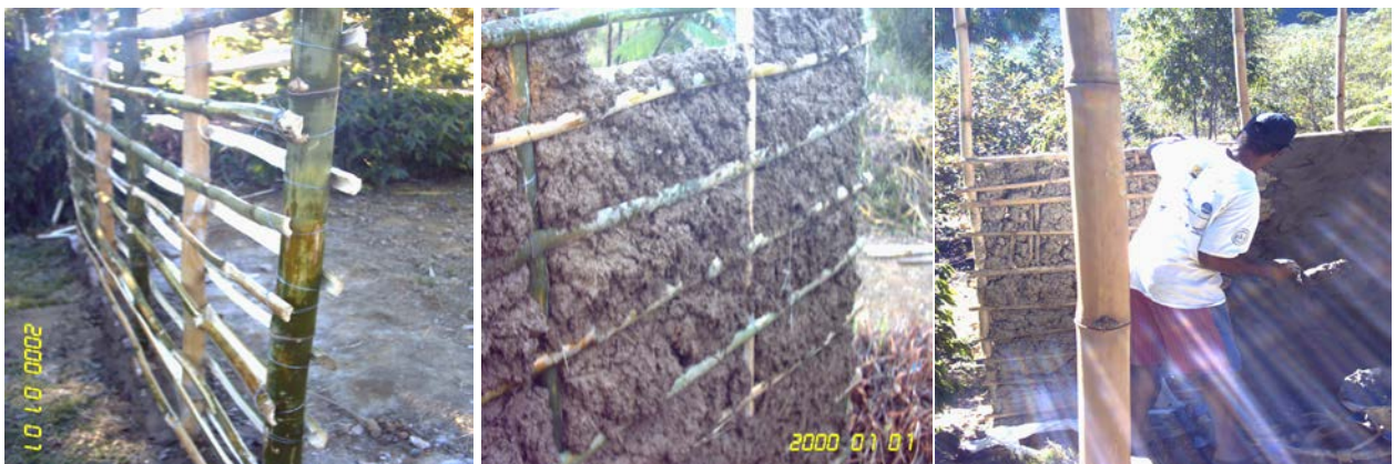
Figura 6. Painel protótipo: montagem de estrutura com bambu e enchimento com barro.
