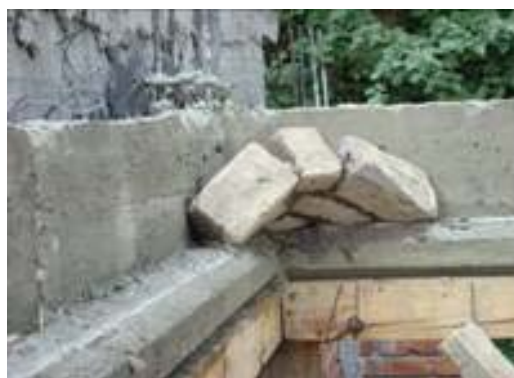
Colocación de la tercera hilada, ajustando a la pieza del centro
