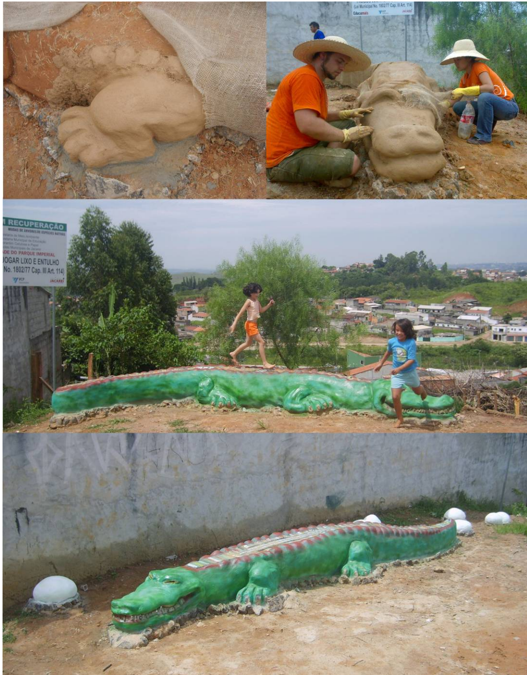
Figura 6. Acima: os arquitetos da Espiralando: César Costa e Juliana Okumura, executando parte do revestimento com a técnica de Calfitice. Abaixo: crianças do bairro brincam sobre os bancos escultóricos já finalizados
