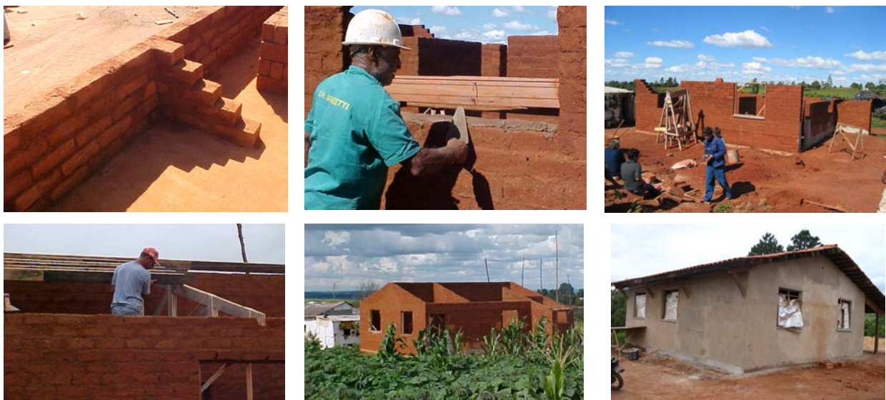
Figura 3. Fotos da seqüência de elevação da casa de adobe
