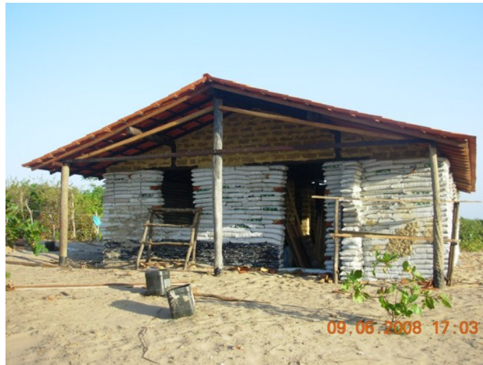
Figura 4. A casa já coberta, ainda sem reboco
