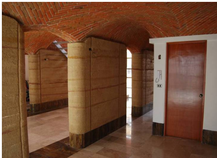
Figura1. Bóvedas de cuña sobre muros de tapial. Casa en la ciudad de México (Ramón Aguirre)
