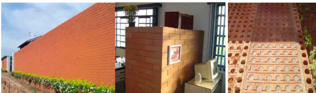
Figura 6: Aplicações de blocos de terra comprimida de solo-cimento: muros, divisórias e pisos.
