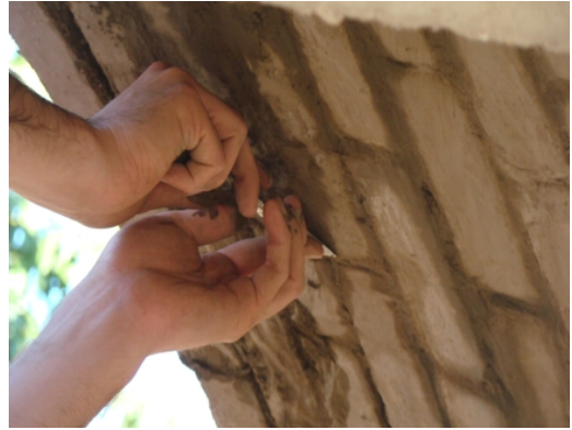
Proceso de limpieza de las esquinas de la bóveda
