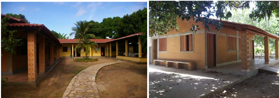
Figura 1. Salão multiuso de 40m 2 , construído com tijolo convencional e BTC. (Fotografias de Yudith Gómez 2005).
