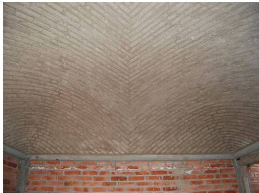
Cierre en forma de espiral e interior de la bóveda terminada
