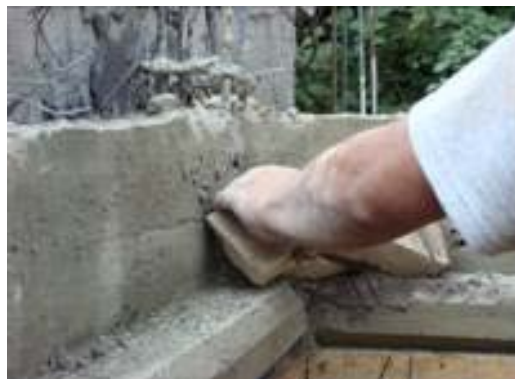
Construcción de la primera hilada
