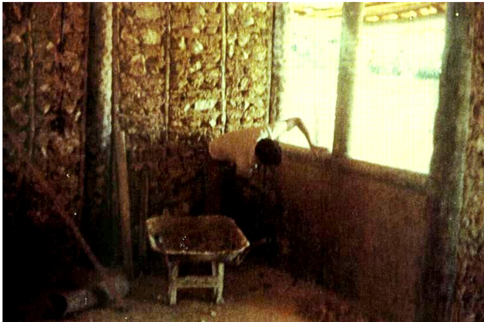
Figura 5. Parede após o primeiro barreamento (Foto Paulo Frota, 1984)
