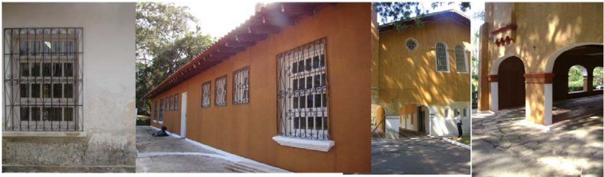
Figura 3. Aspectos anteriores à pintura e a progressiva valorização da edificação com os trabalhos de pintura (Crédito: Parisi, R., 2009)
