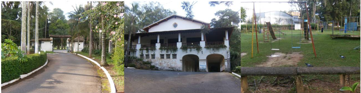
Figura 1. Aspectos gerais do Parque Municipal e o casarão antes de sua reforma (Crédito: Parisi, R., 2009)
