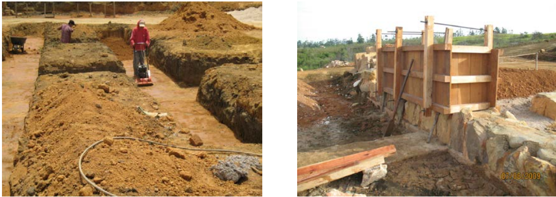
Figura 2. Preparando el subsuelo y armando las tapias a partir del sobrecimiento en piedra
