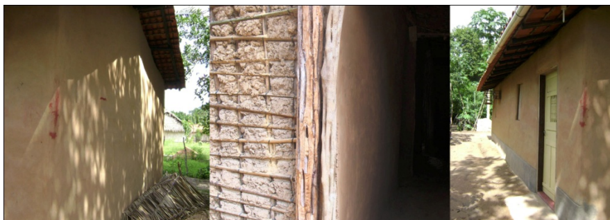
Figura 6 – Aplicação do reboco liso (crédito: Paiva, 2009)
