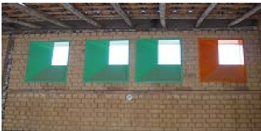
Figura 6. Ventanas “lego” que impiden el paso directo del sol sin suprimir la iluminación
