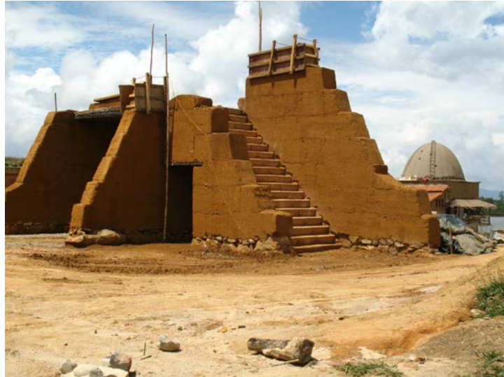
Figura 1. Puerta Urbana en proceso de construcción. Al fondo cúpula de bahareque
