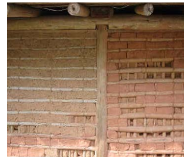
Parede de taipa de mão sem reboco – Brasil
