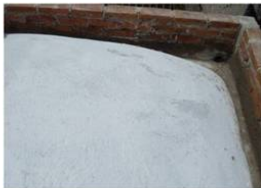
Bóveda con lechada de cal y arena
