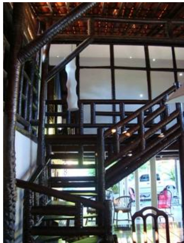
Figura 3. Escada de carnaúba e ipê e parede do piso superior (Foto Thaís Carvalho, 2009)
