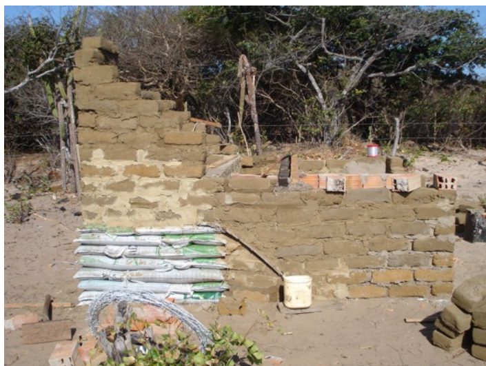
Figura 5. O sanitário seco em construção
