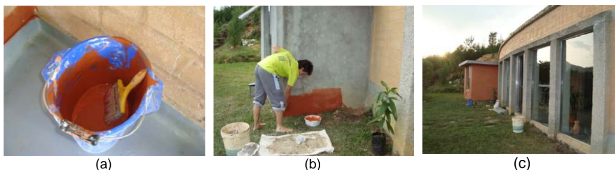
Figura 6. (a) Pintura roja elaborada con tierra; (b) aplicación de la pintura con brocha y (c) pintura de tierra roja aplicada en el exterior
