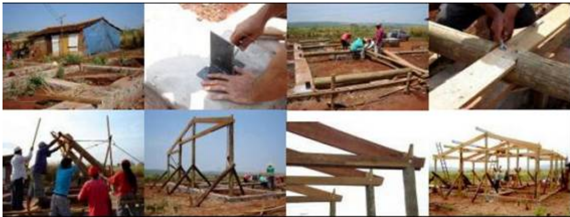
Figura 9 – Algumas etapas de execução do sistema estrutural pilar-viga de eucalipto roliço (acervo HABIS).
