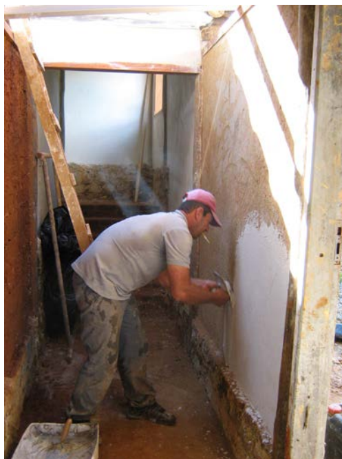
Figura 6. Aplicação da segunda camada do revestimento
