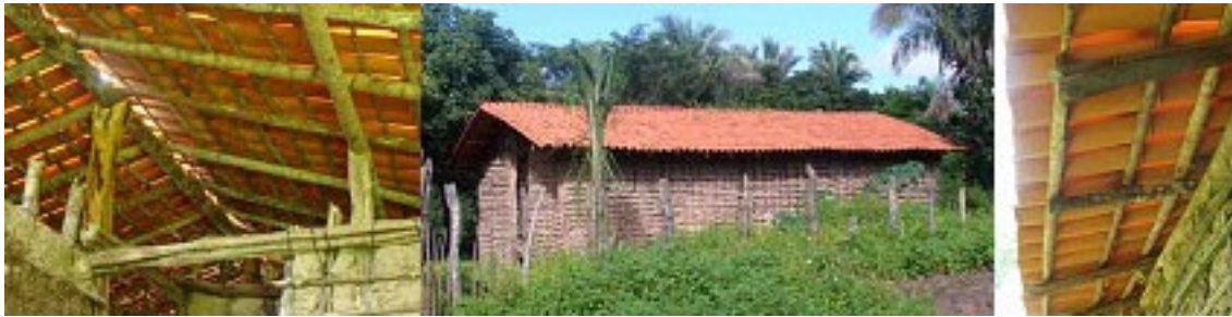
Figura 2 – Estrutura da cobertura, vista externa e beiral (crédito: Paiva, 2009)
